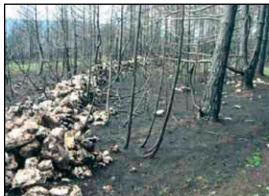
(fig. 8) Après le feu, des structures jusque là masquées par la végétation apparaissent, ici un mur ancien. (Causse Méjean, Lozère vers Caussignac).
