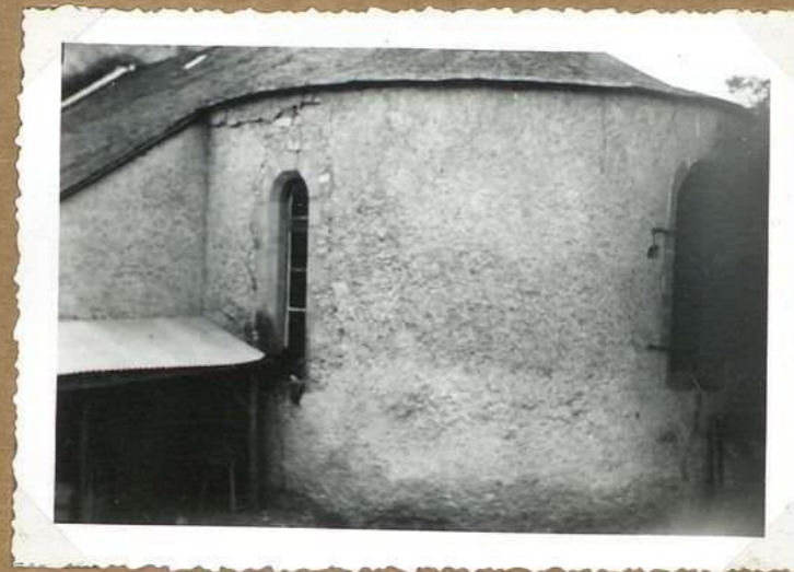
12.199 Abside de l'église
