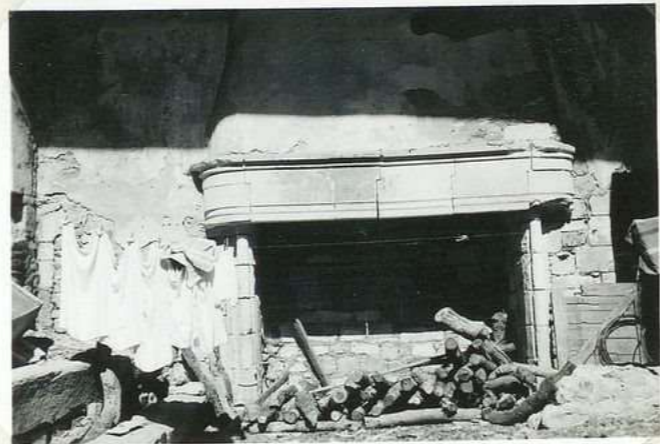
12.096 Cheminée XVI e château
