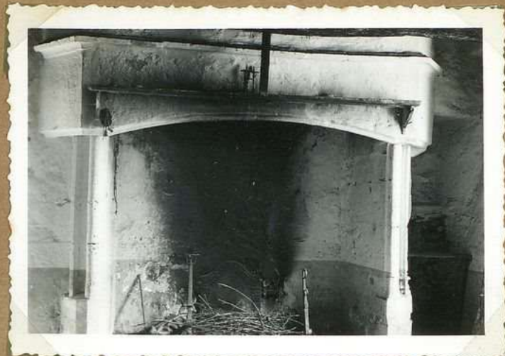
12.116 Cheminée Maison Dolcaupe
