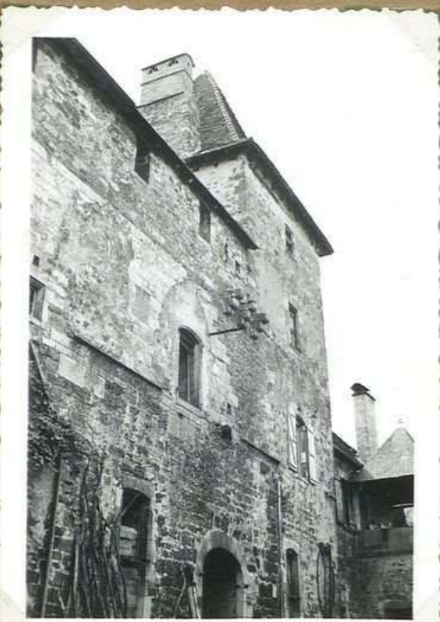
12.098 Corps de logis ouest (rue intérieure)
