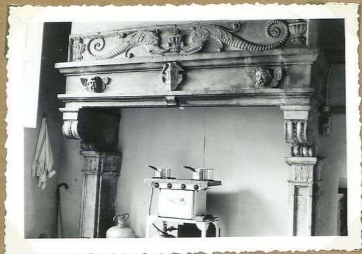
12.120 Maison Charlat Cheminée aux hypocaustes
