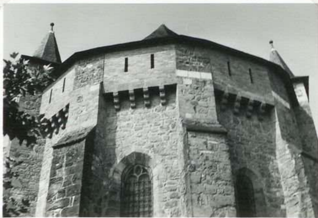
12210 Eglise de Vayrac abside et machicolis
