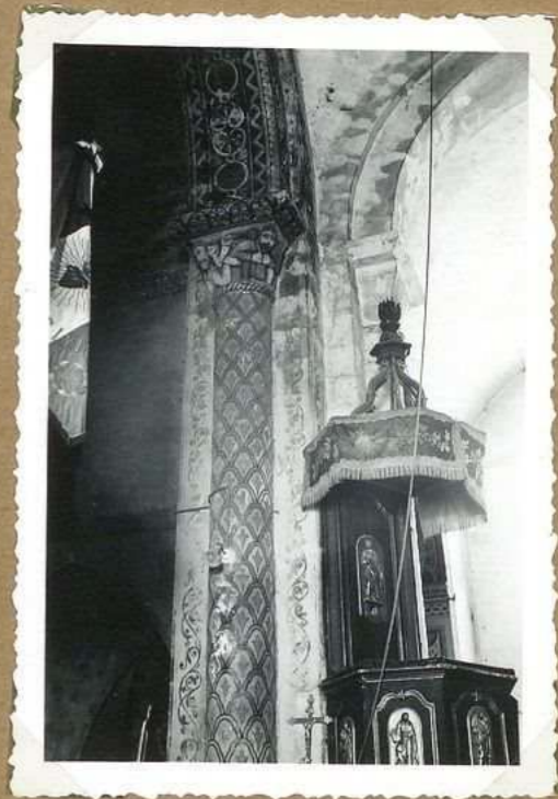
72257 Eglise de S t Michel chapiteau du chœur, épître
