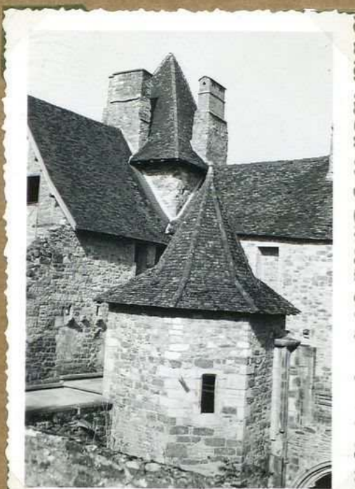
12.086 Tour d'angle S.E. au donjon du château
