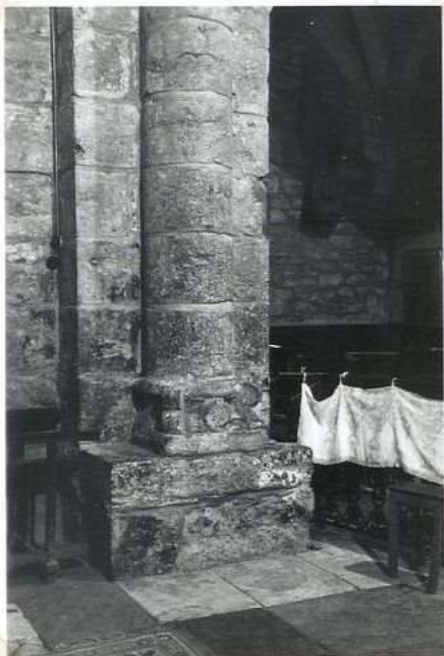
12313 Eglise de Cavagnac base de chœur
