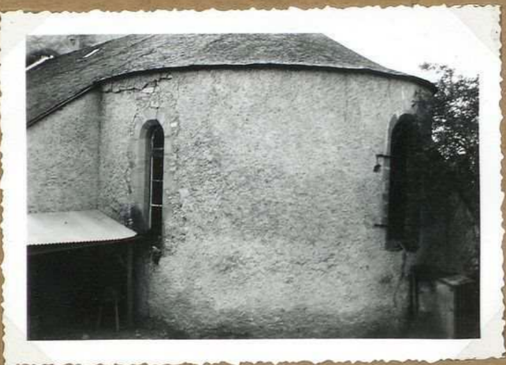
12.197 Abside de l'église
