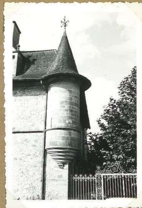
12.170 Tourelle - Château de la Tourelle
