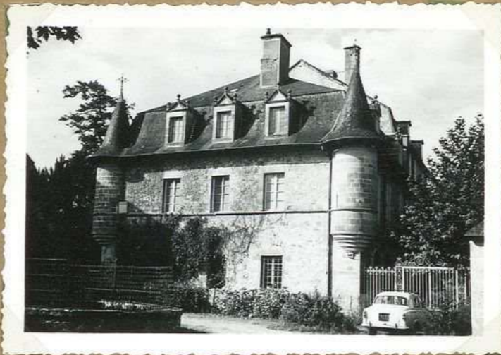
12.169 Château de la Tourelle Facade N.E
