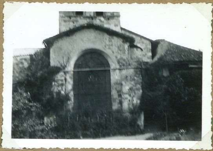
12.151 Abside de l'église
