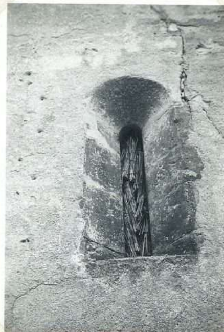
12202 Château de Vayrac, fenêtre d'aspect romain
