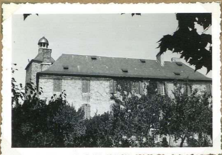
12329 Château de Cavagnac, ensemble côté sud
