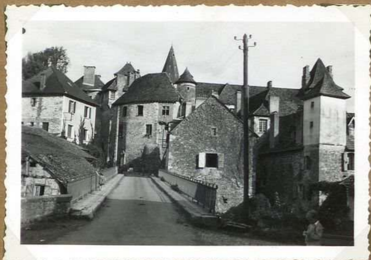
12.135 Vue générale ouest
