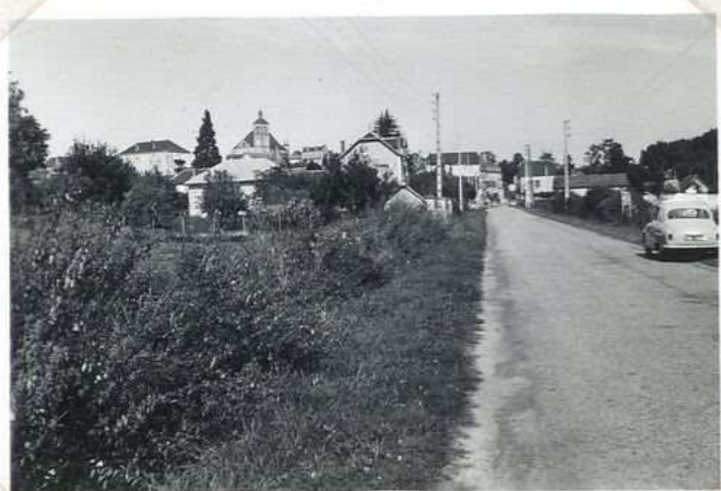
12203 Vayrac vue générale ouest
