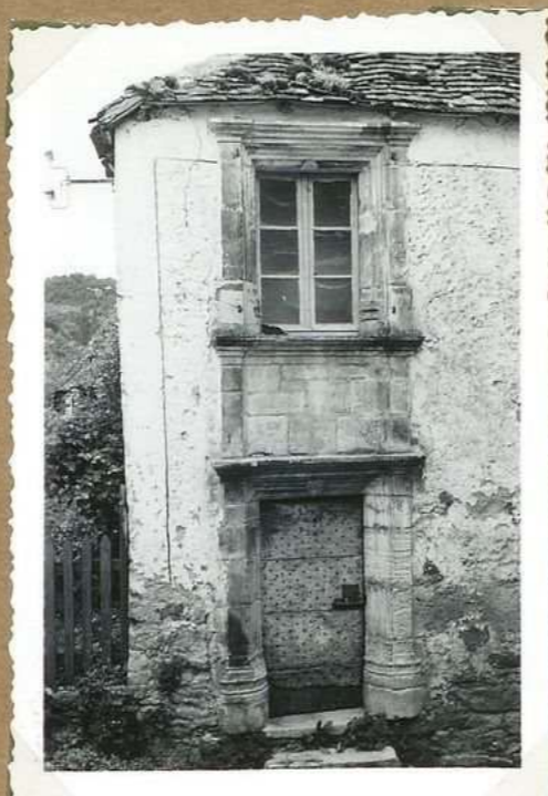
12.124 Maison Gentilhomme Porte et fenêtre façade
