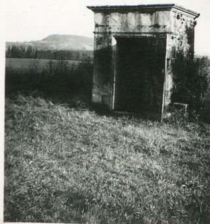
3958 Source minérale St. Pelix
