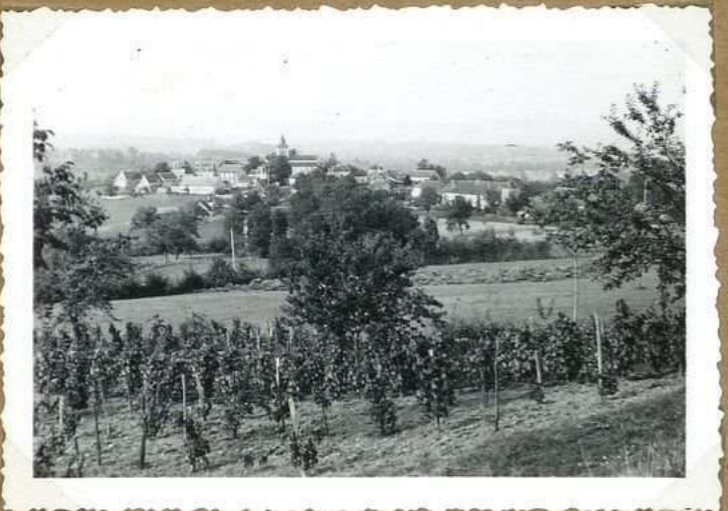
12296 - Vue générale ouest
