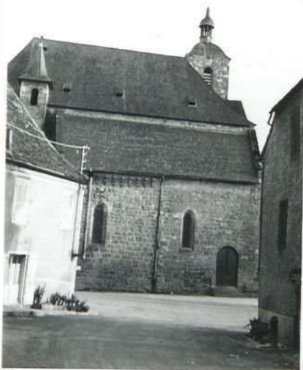
12206 Eglise de Vayrac vue nord
