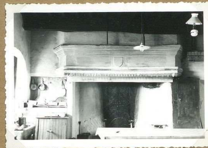
12.173 Cheminée XVII de la Tourelle
