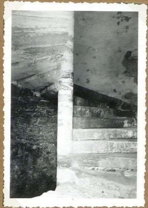
12237 Chateau de Sarrazac escalier a vis tour Sud est
