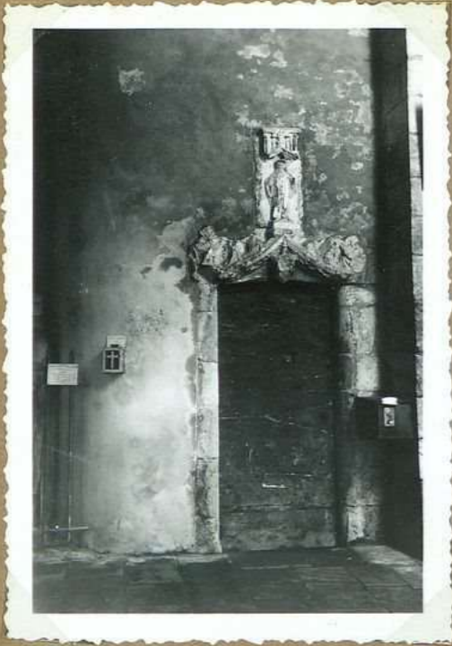
12.150 Porte accès au cloître
