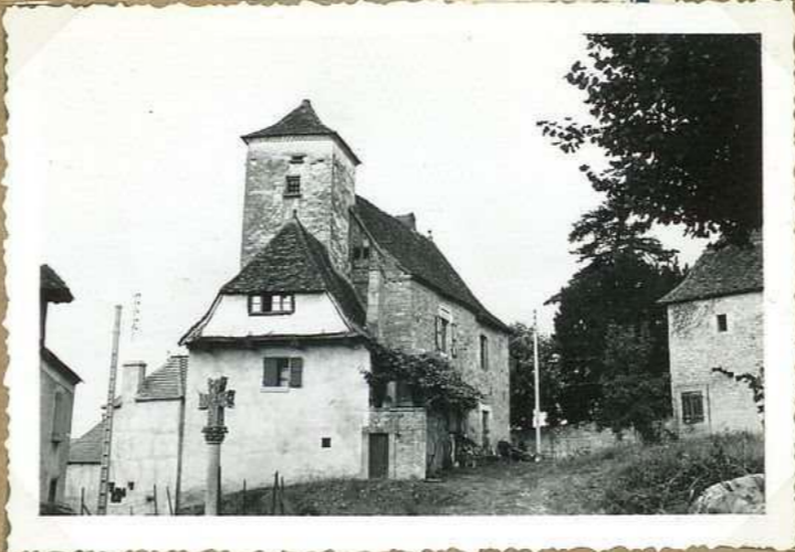
12.163 Hétraire de la Tourelle. Façade Est
