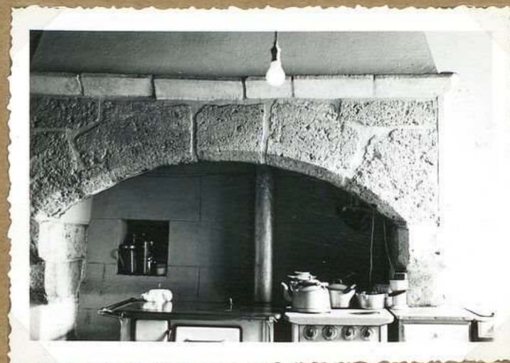
12.145 Cheminée Maison Tourmé
