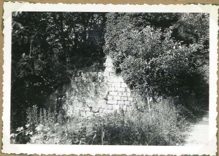
11462 Puits du moine de Limon ouest
