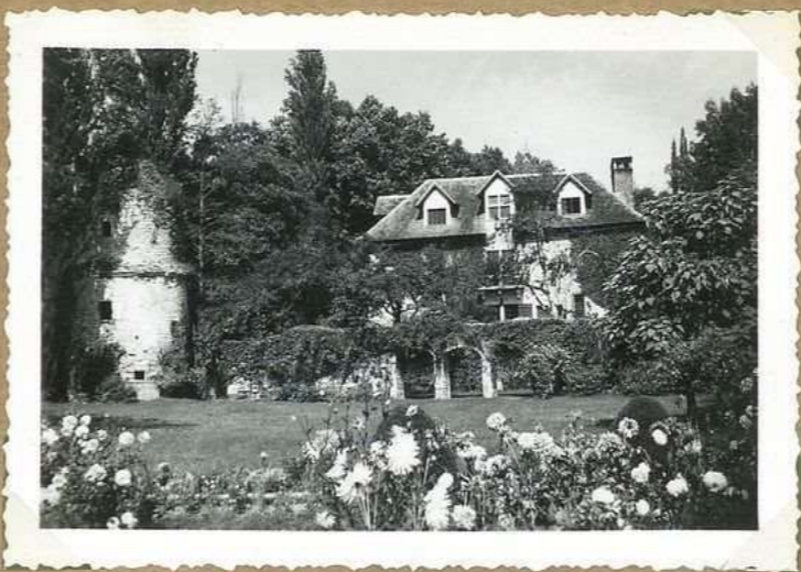
11292 Château de Bourzollès vue est
