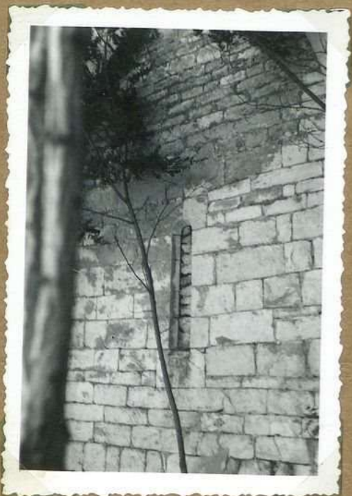
11312 Eglise St Etienne fenêtre étroite abside
