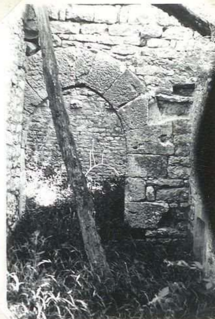
11347 Château du Bastid Double porte, vue côté nord
