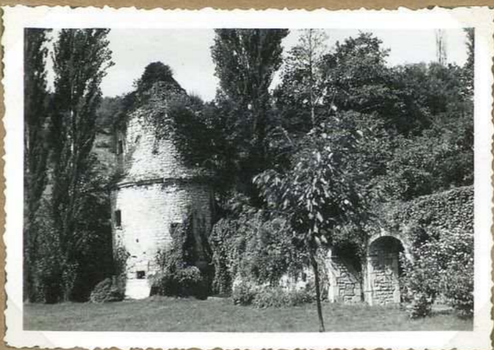
11295 Château de Bourzollès vue est
