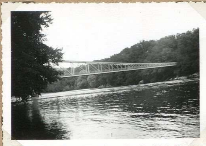
2987 Pont de la Trepne
