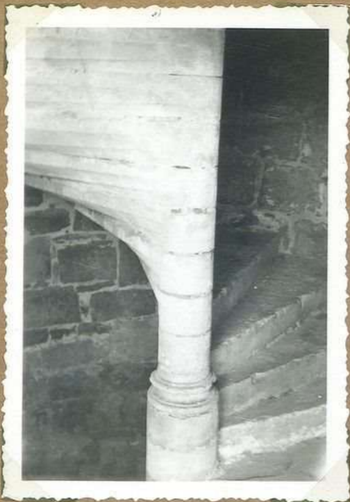
11453 Tour 500 m de Meyronne, côté est escalier à vis
