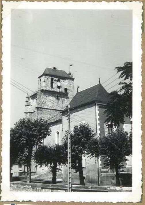
11275 Eglise St. Martin vue est
