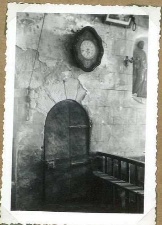
11313 Eglise St Etienne porte intérieure
