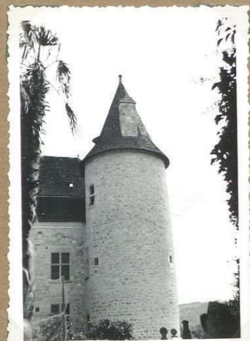
11394 Château de la Treigne tour sud, est
