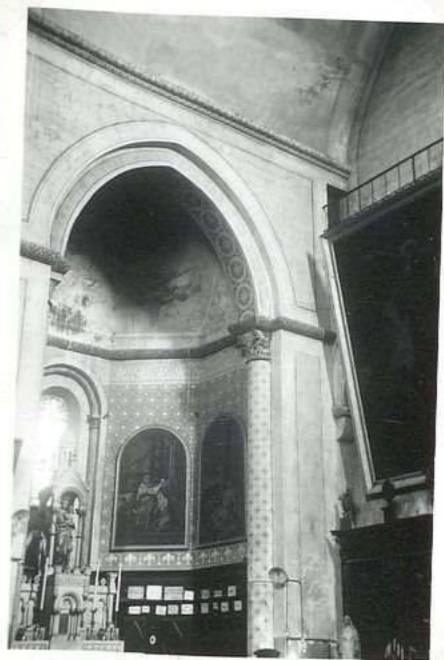
11261 Eglise de Souillac abside, côté' chœur
