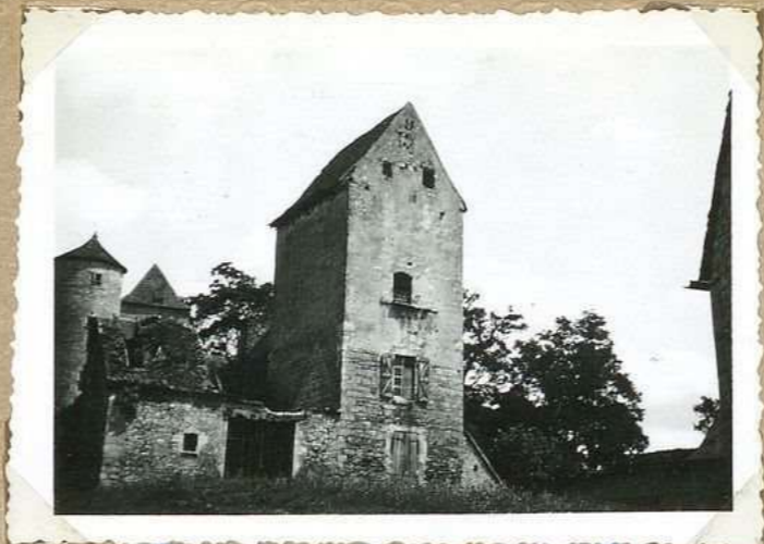
4024 Ensemble des dames de Mirepoix (ensemble)
