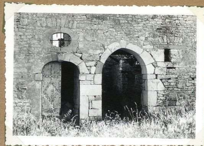
1357 Château de Bastid porte d'escalier
