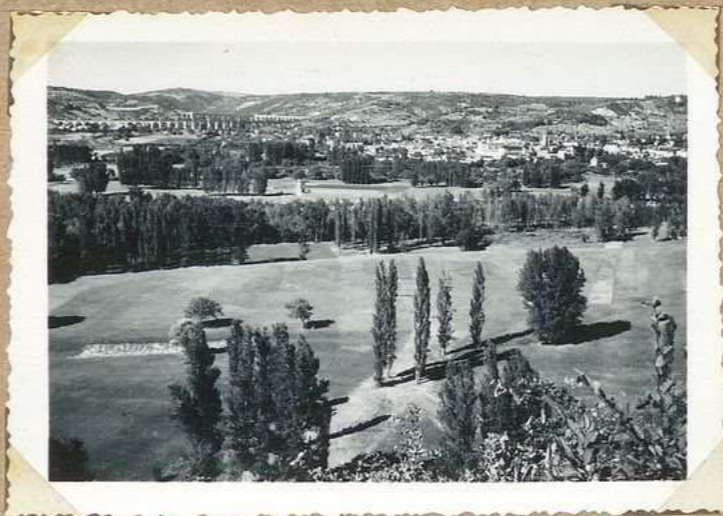
3507. Vue générale (de la route du Roc)
