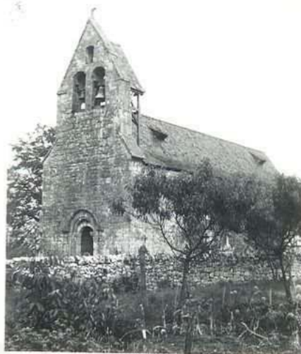
11326 Eglise de Meyraguet côté ouest
