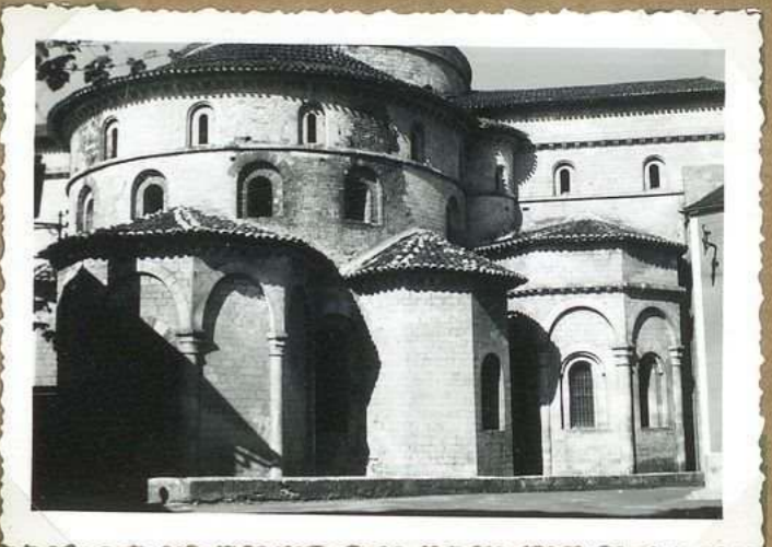
11267 Eglise de Souillac abside vue est
