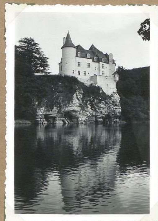
11396 Château de la Treigne, vu ouest
