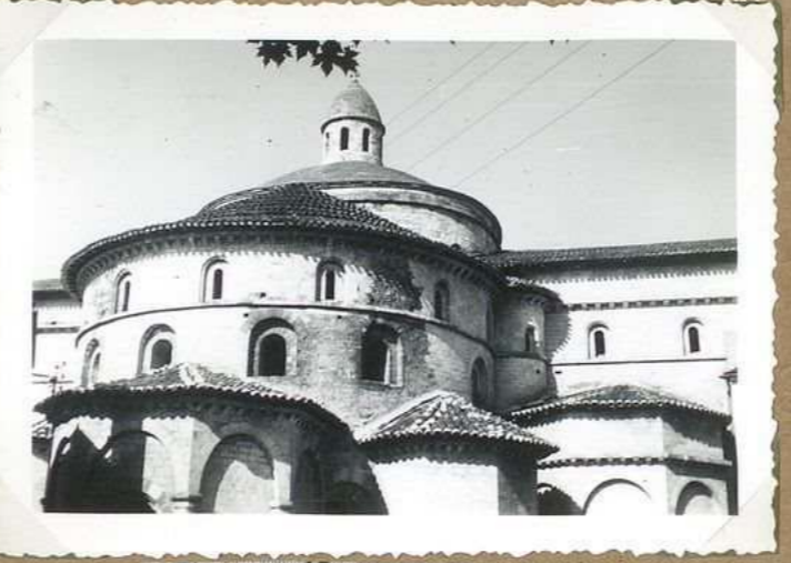
11277 Eglise de Souillac abside vue est
