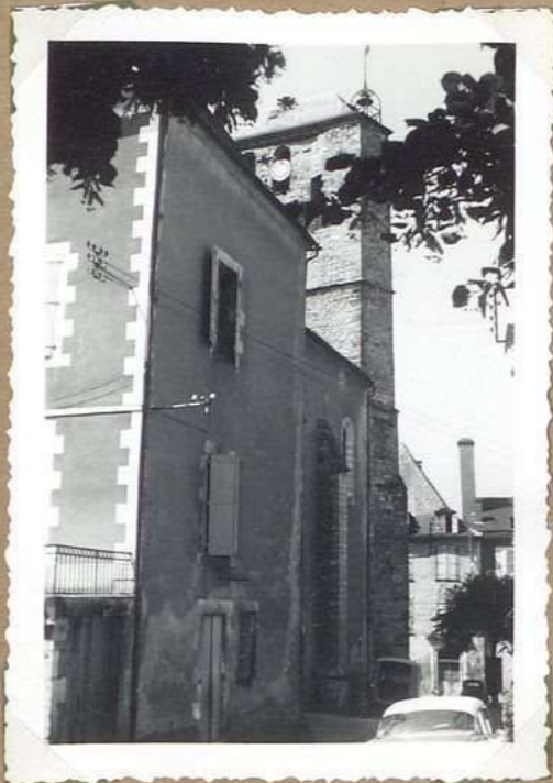
11283 Eglise St. Martin vue est
