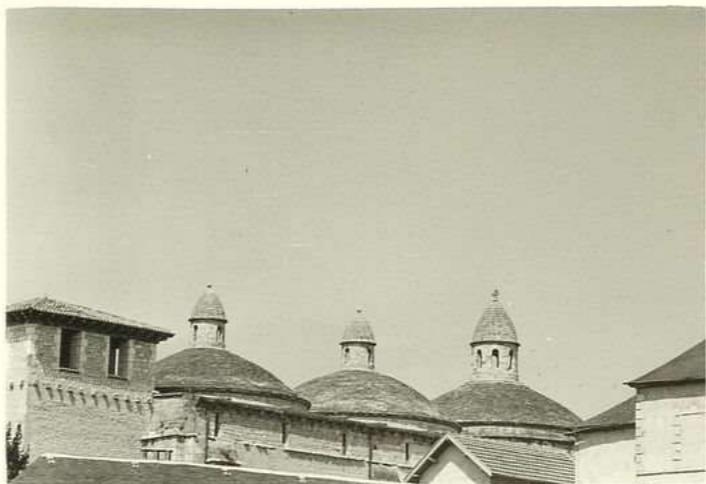
12335 Eglise de Souillac façade ouest, (télé)
