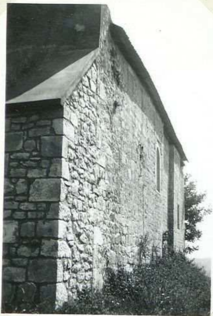
11303 Eglise de St. Etienne La Combe vue sud
