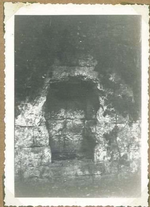
11463 Puits de Limon Rocard dans le moulin
