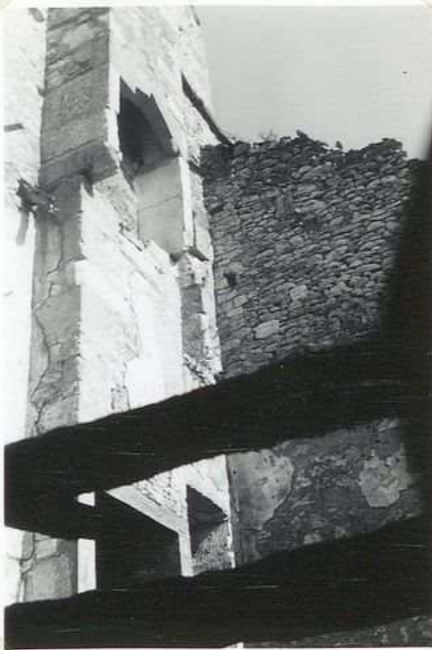
11346 Château du Bastid 2 cheminées ouvertes
