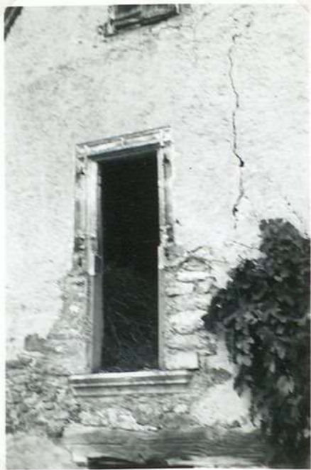
11436 Maison Delbreil fenetre gotique
