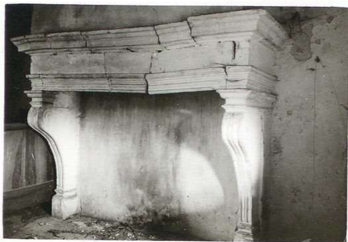
11453 Tour de Meyronne cheminée, 2 e étage
