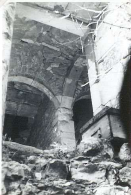
11349 Château du Bastid escalier
