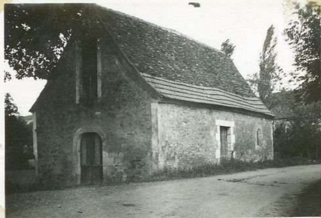
3498. Restes de l'ancienne église de Bourzalles
