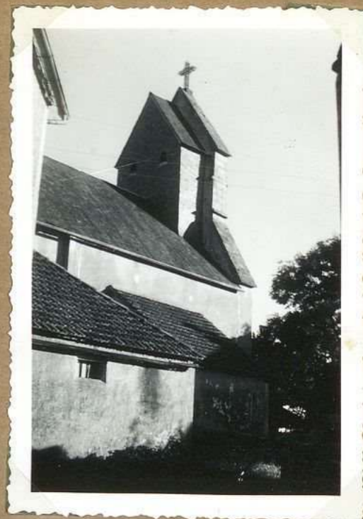
11230 Eglise de Lachapelle vue nord
