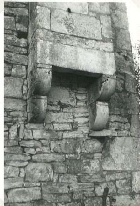
11 197 Maison Delbos Latrine, extérieur
