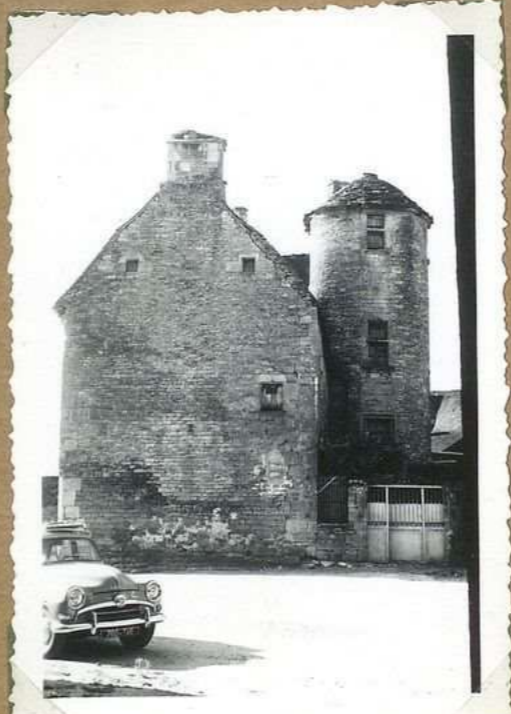
11762 Maison Lasfargues La terre, rue nord
