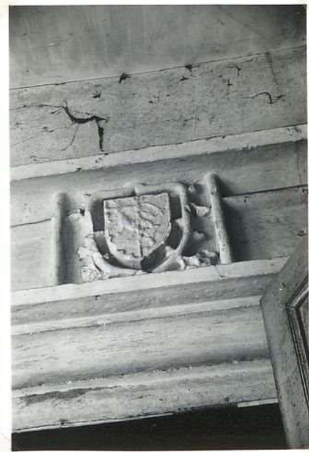
11488 Chateau de Mayrac cheminée, 3 e étage
