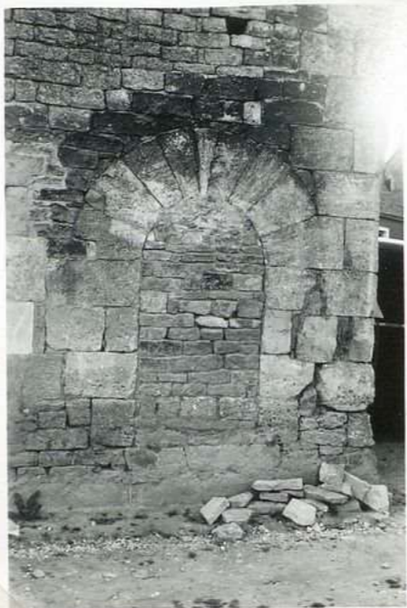
11168 Maison Lasfargues Porte ogivale murée
