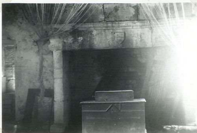
11 196 Maison Delbos Cheminée
