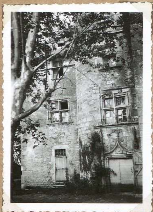
2650. Chateau de Mayrac façade
