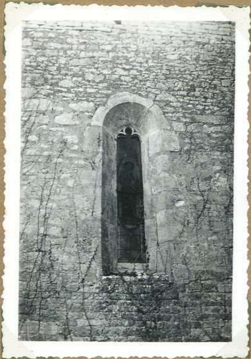
11234 Eglise de Rognes fenêtre chapelle entre
