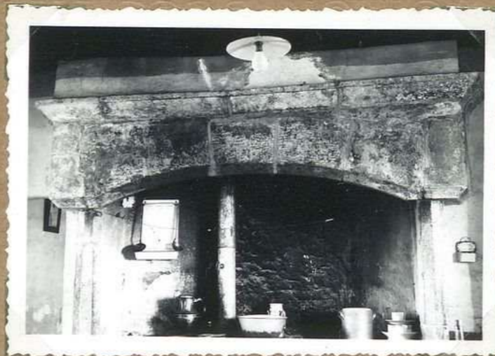
11411. Maison d'ancien cheminée
