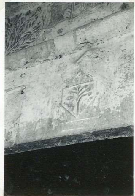
11759 Maison Faurel cheminée (détail)
