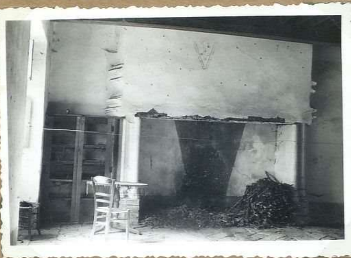
11481 Château de Mayrac cheminée 2 e étage
