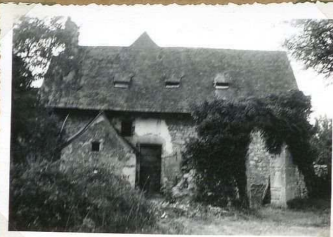
11246 Maison Limal ensemble de la maison
