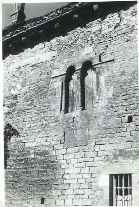
11761 Maison Lasfargues fenêtres gemées
