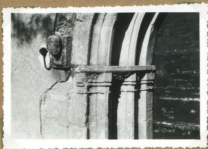
11479 Eglise de Mayrac détail du portal
