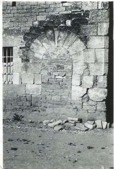
11763 Maison Lasfargues Porte ogivale murée
