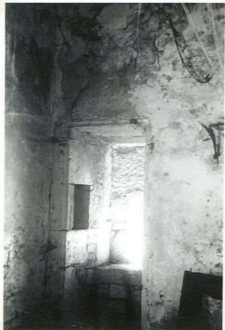
11 192 Maison Delbos Latrine
