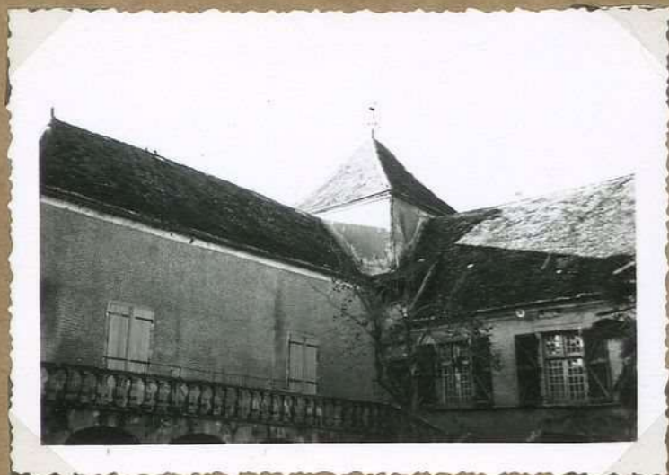
9.600. Chât. de Lacoste Cour intérieure
