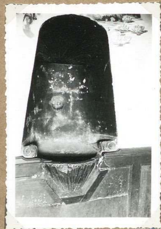
9515 Ch eau de Lavercantieri Fontaine de salle à manger
