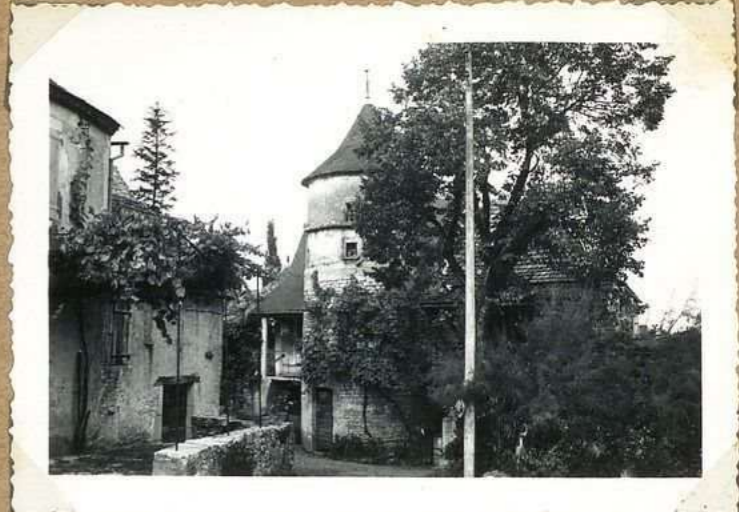
9371 Mon Hospital Tour Ligonniere S.E
