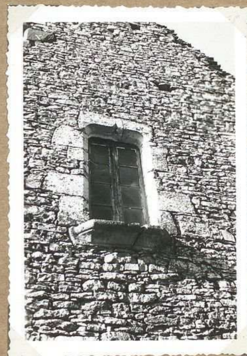
9540 Moy Floirac Fenêtre avec accolade et appui mouluré
