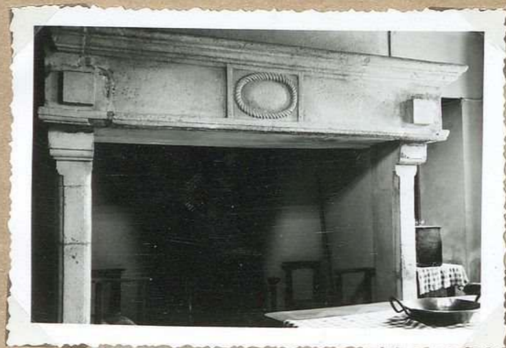
6086 Cheminée. Maison Hazières
