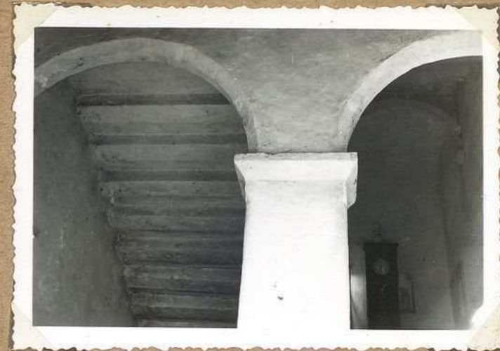
9475 Chateau de S t Avit Arcs et pilastre. 1 er palier
