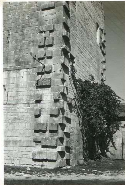
9507 Ch teau de Lavercantieri pierrres d'attente
