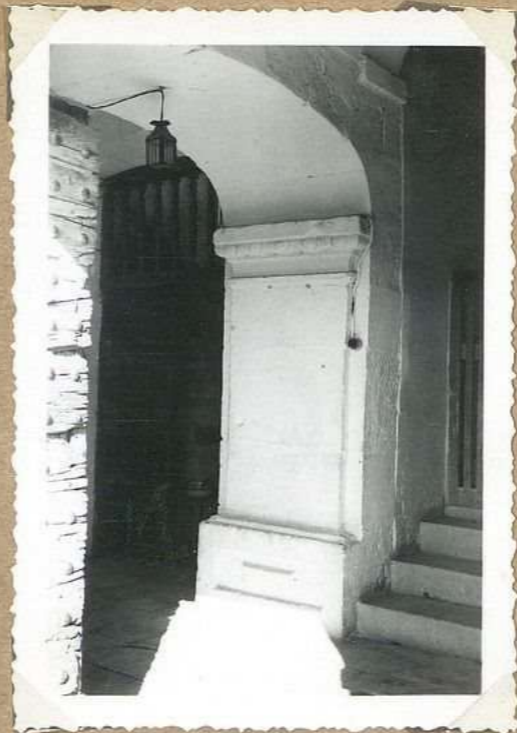
9512 Ch eau de Lavercantieri Défaut enalier
