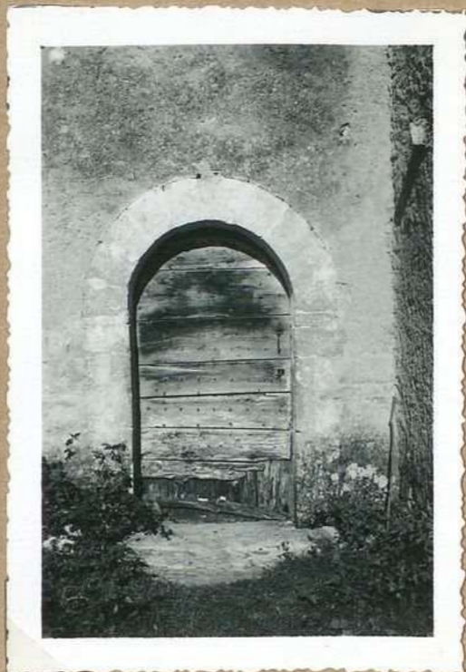
9498. Eglise de St. Martin Porte d'entrée
