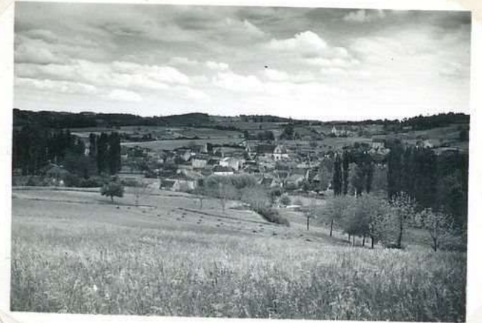
3349 Vue générale (N)
