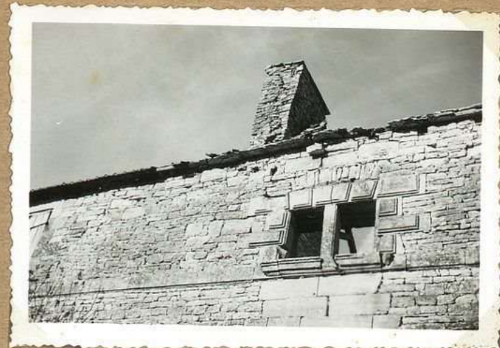
9487. Château de Lantès Fenêtre XVII e
