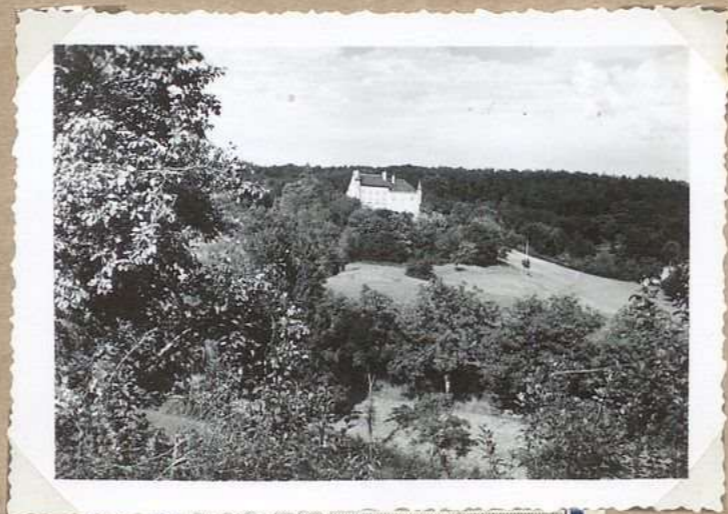
3864 Ch eau de la Boisse
