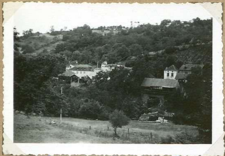
2237 Vue générale de Latouille
