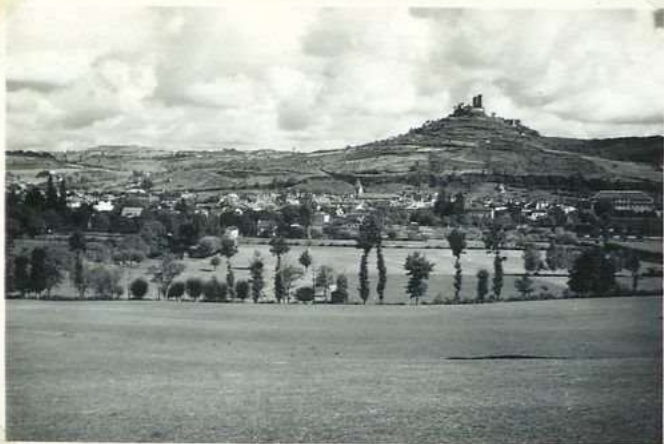
3597 Vue générale S
