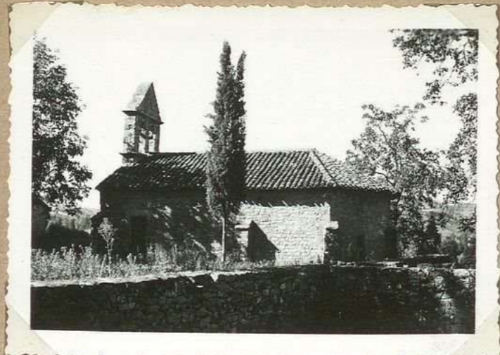
3834 Chapelle du Mortal
