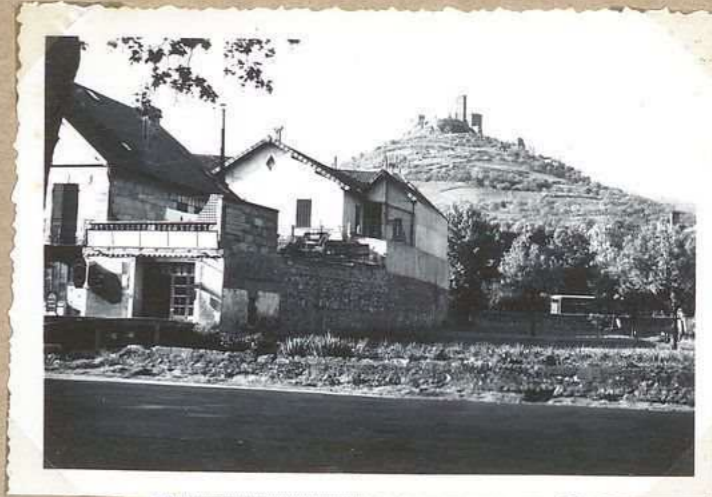
4404. Vue générale (de St-Céré)
