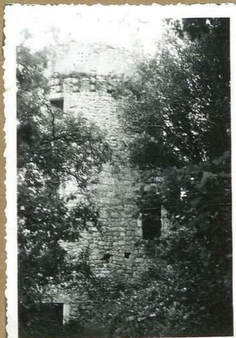
10697 Tour de Mareuil vue sud
