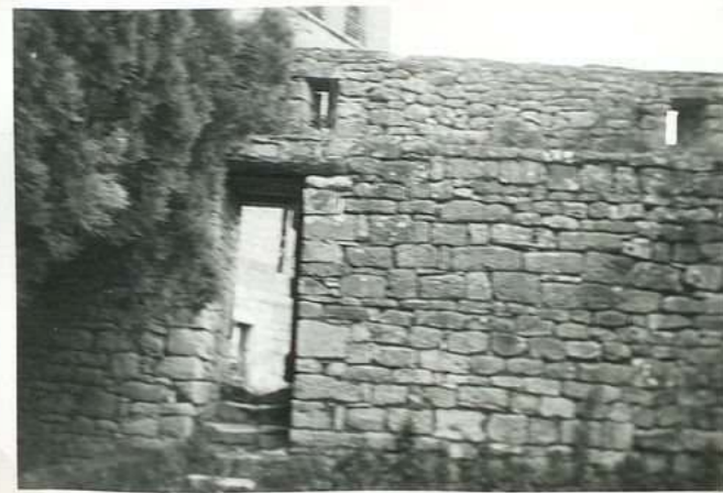
10648 Chateau de Masclat Mestrières sur le mur de ronde.
