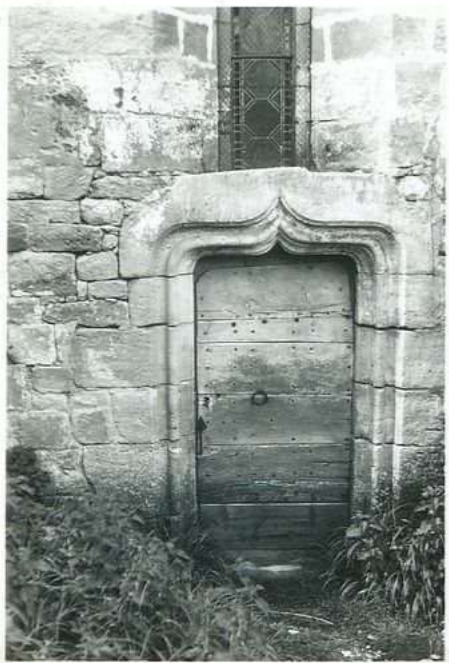
10655 Église de Lamothe Porte sud avec accolade
