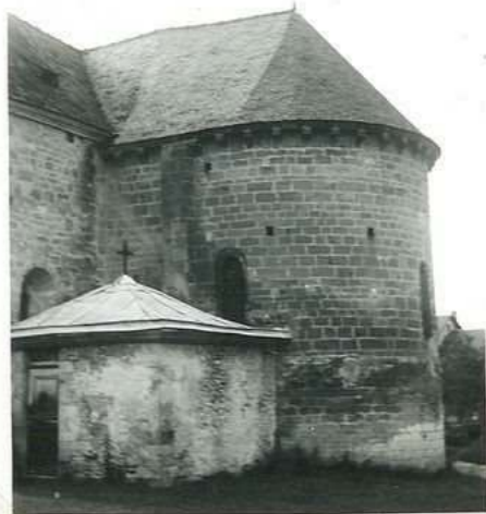
10657 Église de Lamothe abside rue sud
