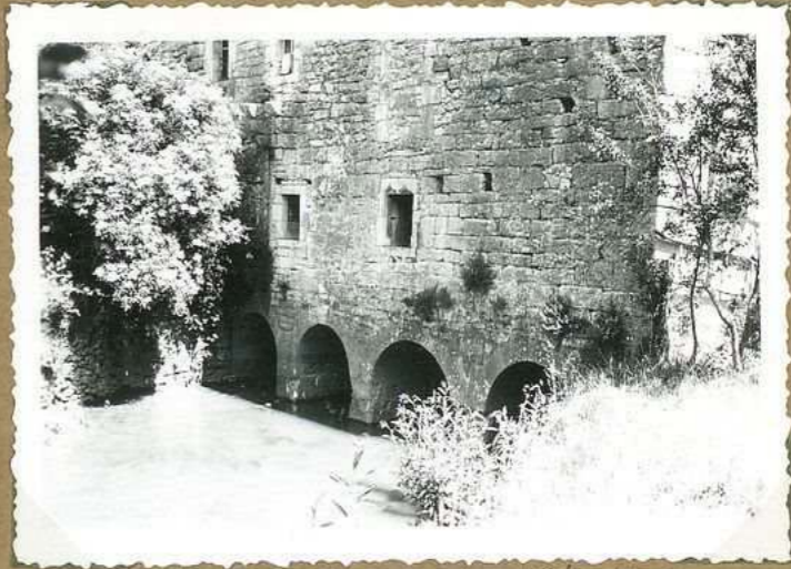
10757 Moulin de Cagnagnat Nord
