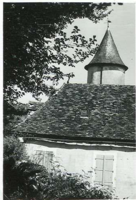
10773 Château de Loupiac côté ouest
