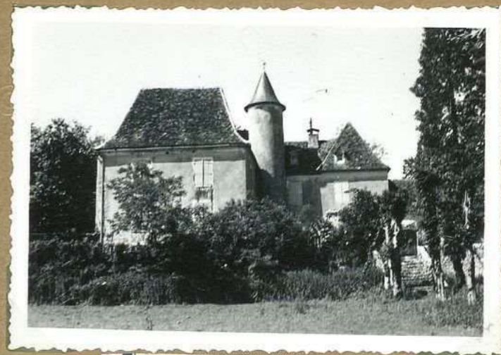
10774 Château de Loupiac côté sud
