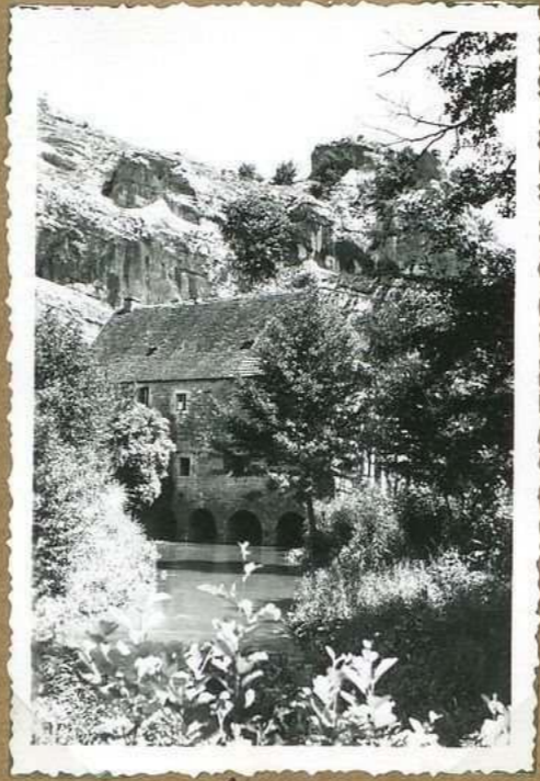
10759 Moulin de Cagnagnat Nord
