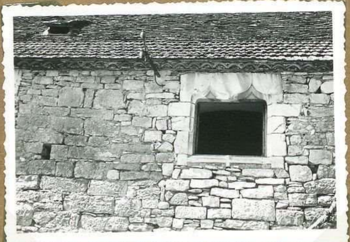
10760 Moulin de Cagnagnat Nord
