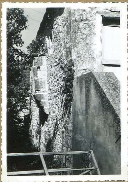
10714 Maison Episcopale Les Letrinas
