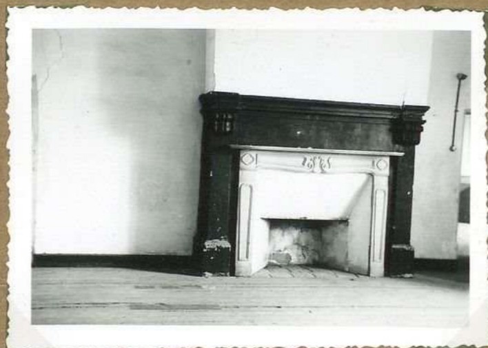
10.792 Château de Payrac 2e et 3e. cheminée pierre doublée en bois
