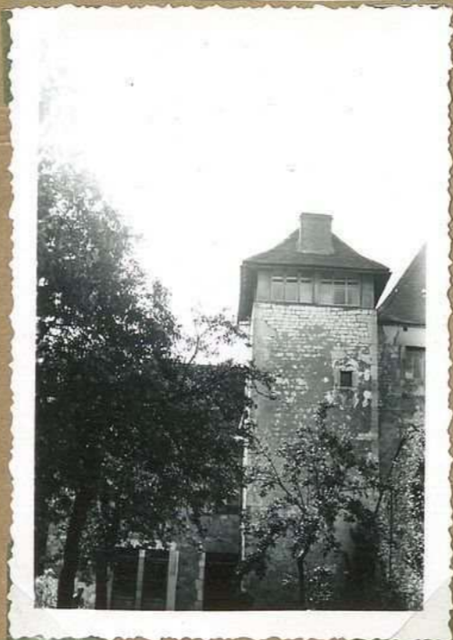
10.801 Maison Crubillén - Tour - facade Est
