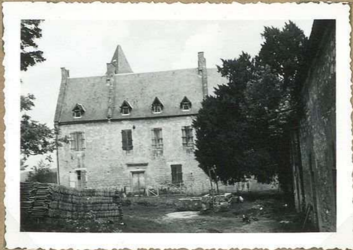
10689 Chateau de Nadaillac façade sud
