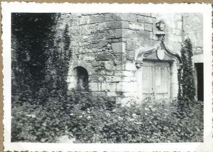
10692 Chateau de Nadaillac porte tour d'escalier
