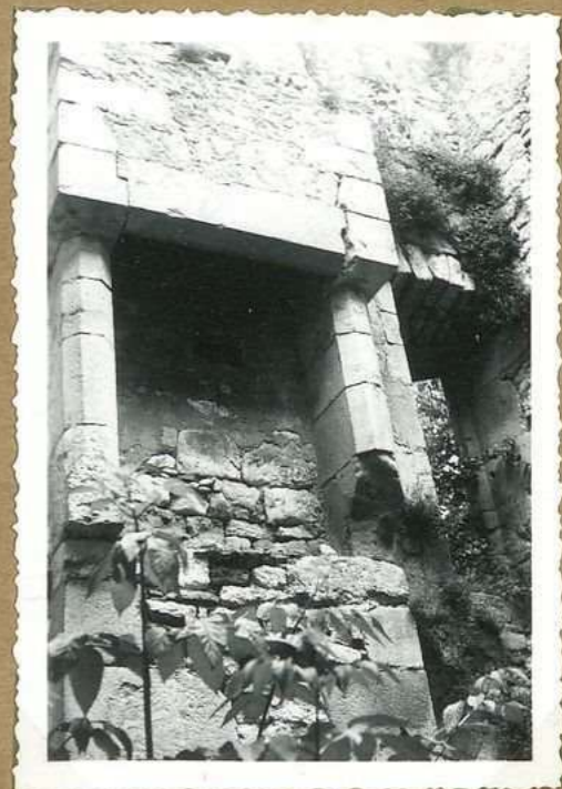
10698 Tour de Mareuil cheminée 2 e étage
