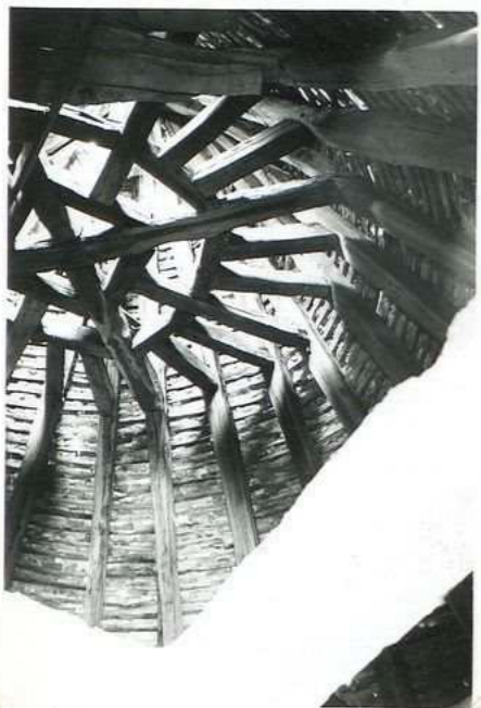
10.797 Charpente de la Four châtean de Payrac
