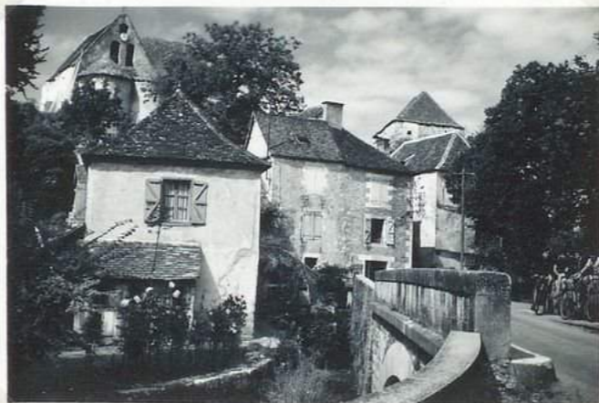
1203. Vue générale, le pont
