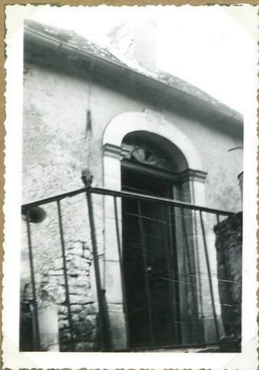
11513. Maison Gayel porte et escalier
