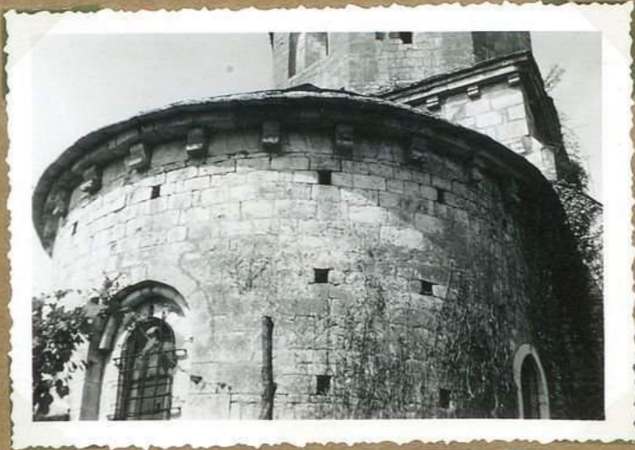
11532. Eglise de Rignac abside, modillons
