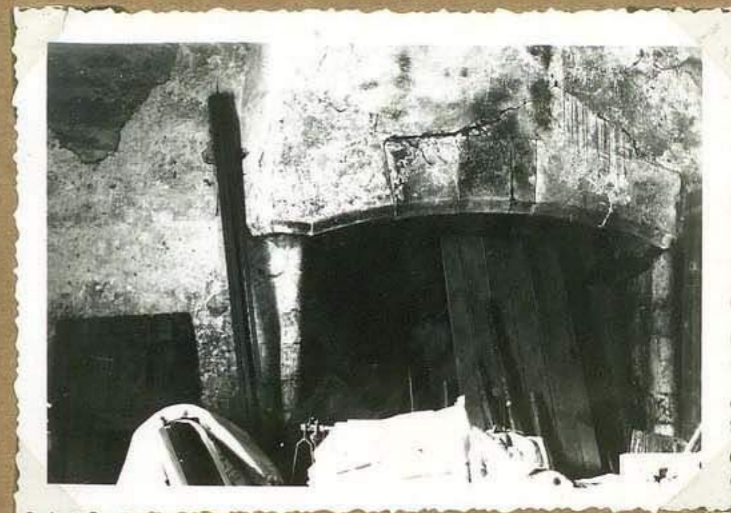
11946 Chateau de Besse, Cheminée (2e photo)
