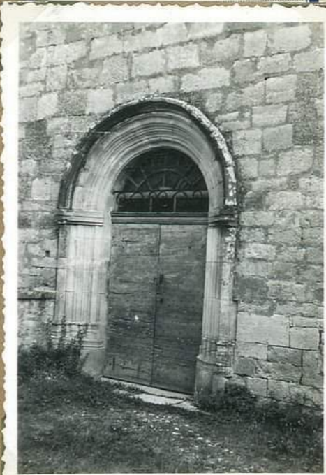
11559 Eglise de Cuzance Portail ouest
