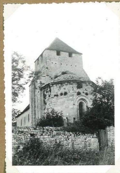
11758 Eglise de Murel abside vue est
