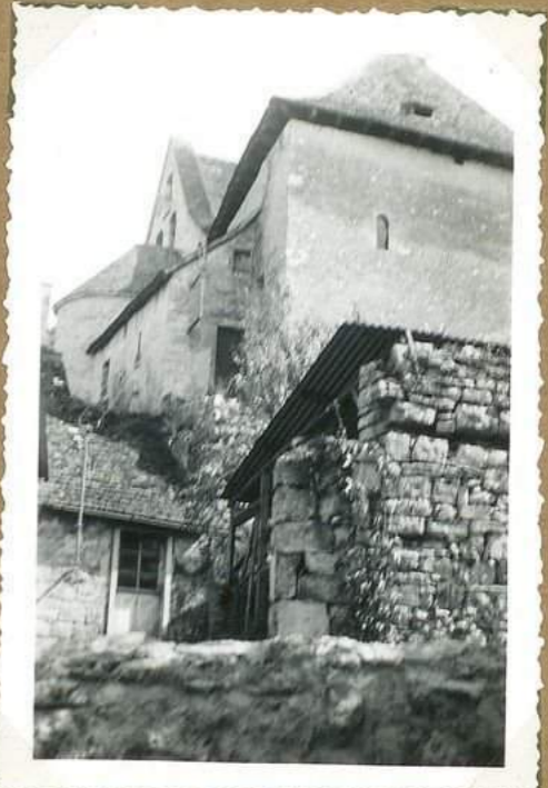
11746 Eglise de Creysse vue ouest près du fort.
