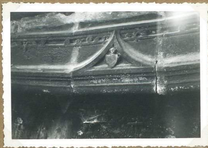
11700 Maison Castanet cheminée, détail
