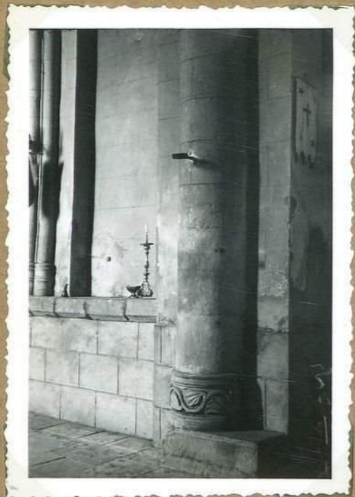
11540 Eglise de Rignac Base, côté épître, chœur
