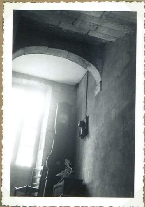
11673 Château de Pommier escalier
