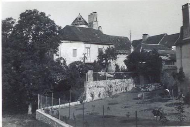
11584 Maison Lavardet ensemble vue est
