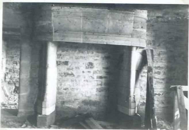
71803 Maison X cheminée gothique
