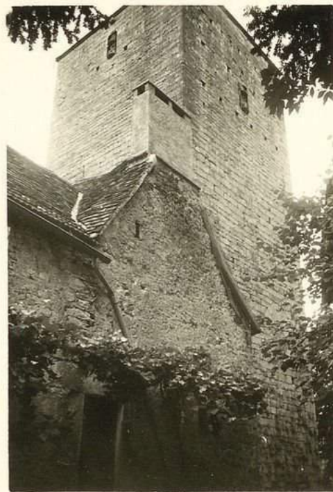
12065 Donjon de Floirac, vue sud-ouest
