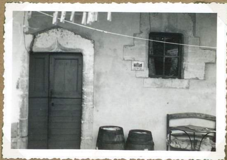
11580 Maison Lavergne Entrée 2 accolades
