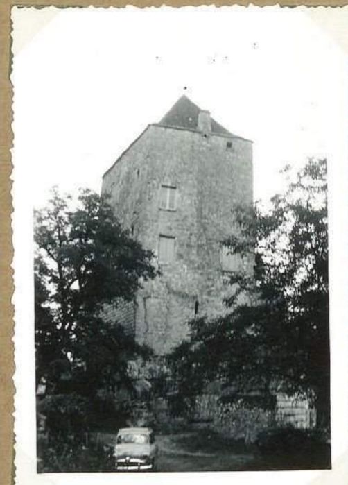
11737 Le Fort (vue Sud)
