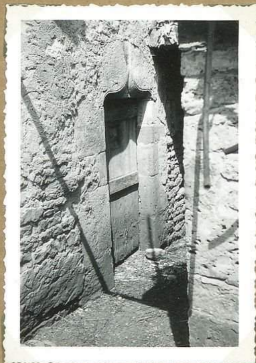
11791 Maison Chapelle accolade et fleur de lys
