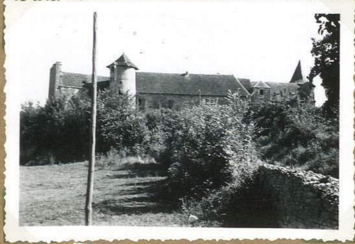
#1507 Château de Tarsac ensemble sud
