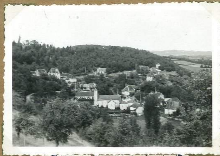
11705 Vue générale de Lantouan, sud
