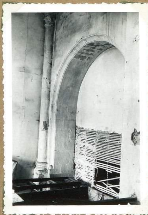
11813 Eglise de Gluges arc et colonne ancienne
