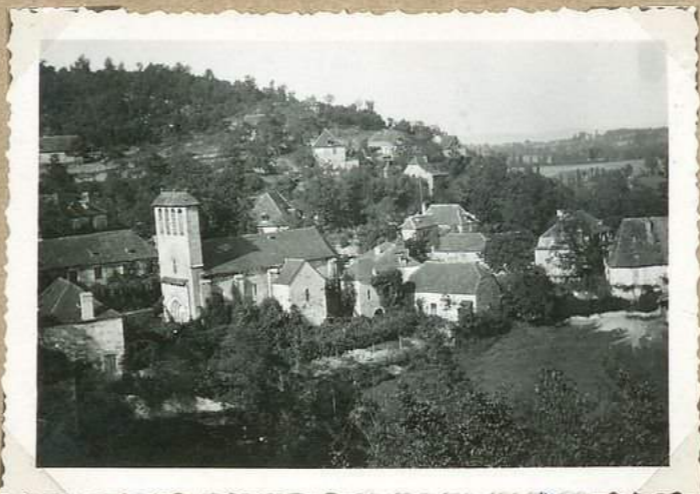
1013 Vue générale de Lasvaux
