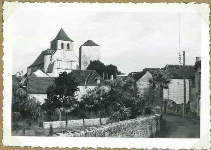
12072 vue générale est
