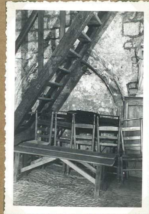
11740 Eglise de Creysse l'enfeu (vue sud)
