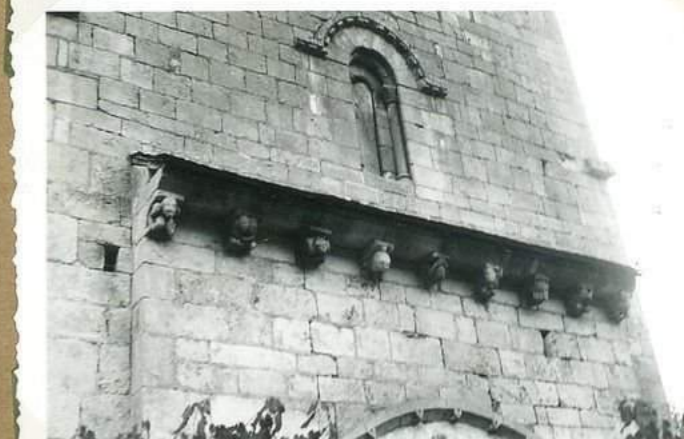
11685 Eglise de Lasserre Modillons, ouest
