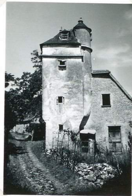
1226 bis. Pigeonnier. tour de l'eau de Rignac
