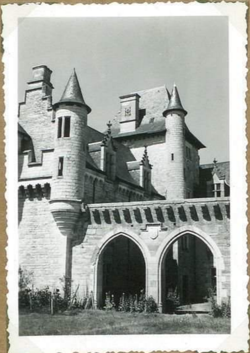
11511 Château de Chaussegny détail sud
