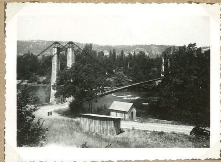
1505 Pont suspendu de Mayre
