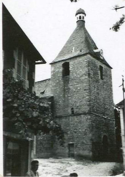
1202 Eglise de Cressensac le clocher
