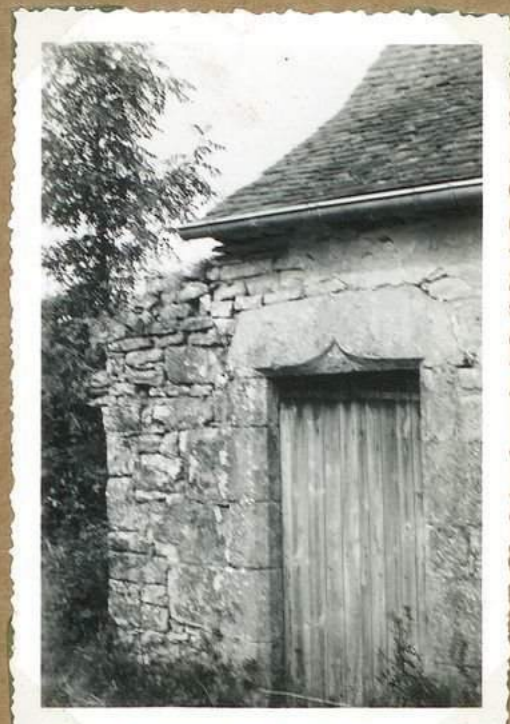
11581 Maison Lavergne accolade, fleur de lys
