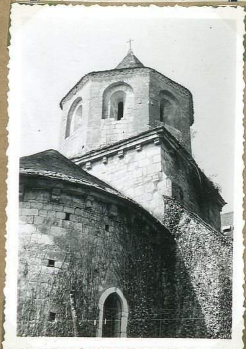
11529 Eglise de Rignac clocher plus orné et abside
