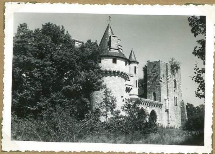
11510 Château de Chaussegny Nord ouest
