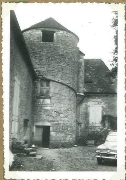
11701 Château de Paumac Porte d'escalier
