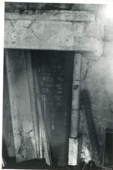
12054 Cheminée (Maison li Sanson)
