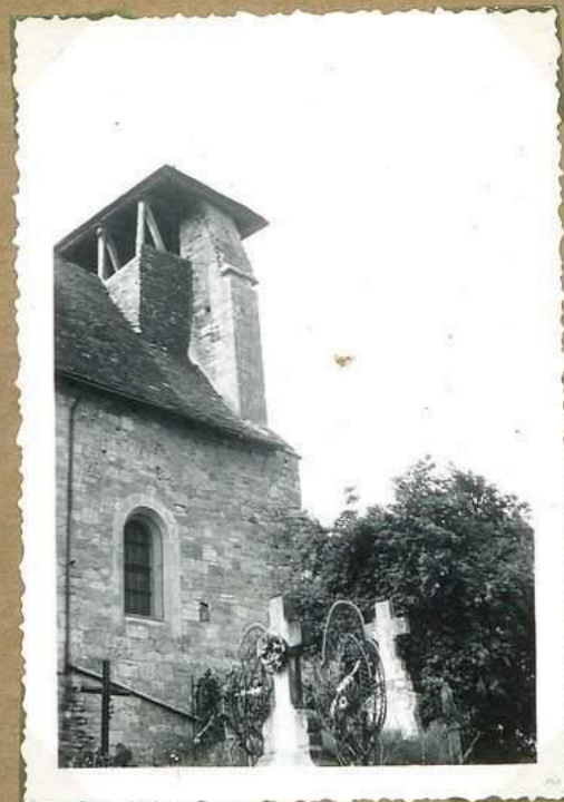
11718 Eglise de Cazillac clocher vue ouest
