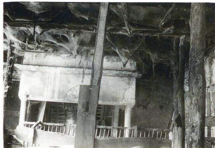
11571 Maison Vergne cheminée (2 e main)
