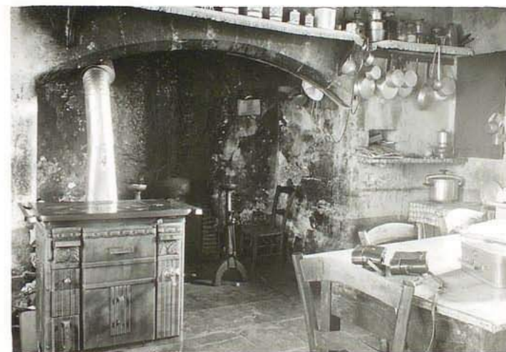
11573 Maison Laverde cheminée cuisine
