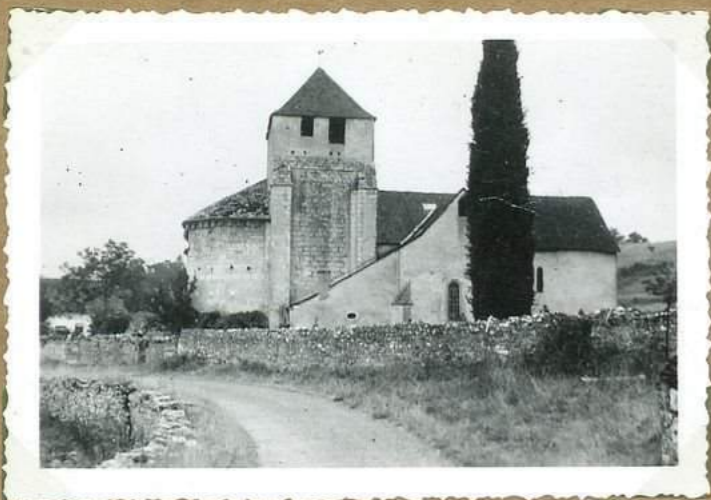
11753 Eglise de Murel ensemble nord
