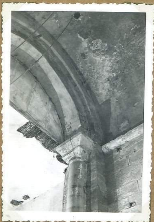
11759 Eglise de Murel Chapiteau, côté évangile
