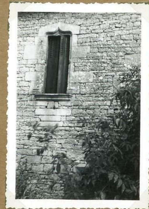
11605 le Château du Jayle fenêtre ouest avec accolade
