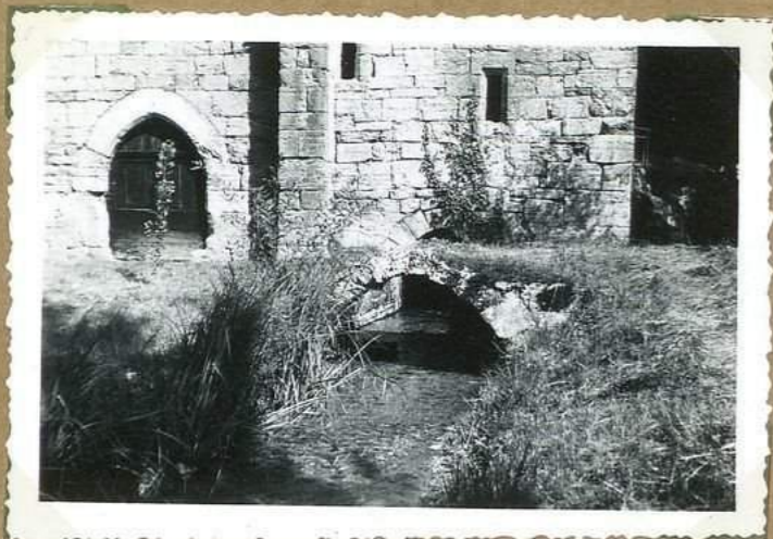
11725 Moulin de Caercis les montels
