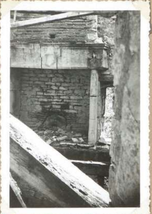
7505. Le "Castelan" Cheminée en pierre
