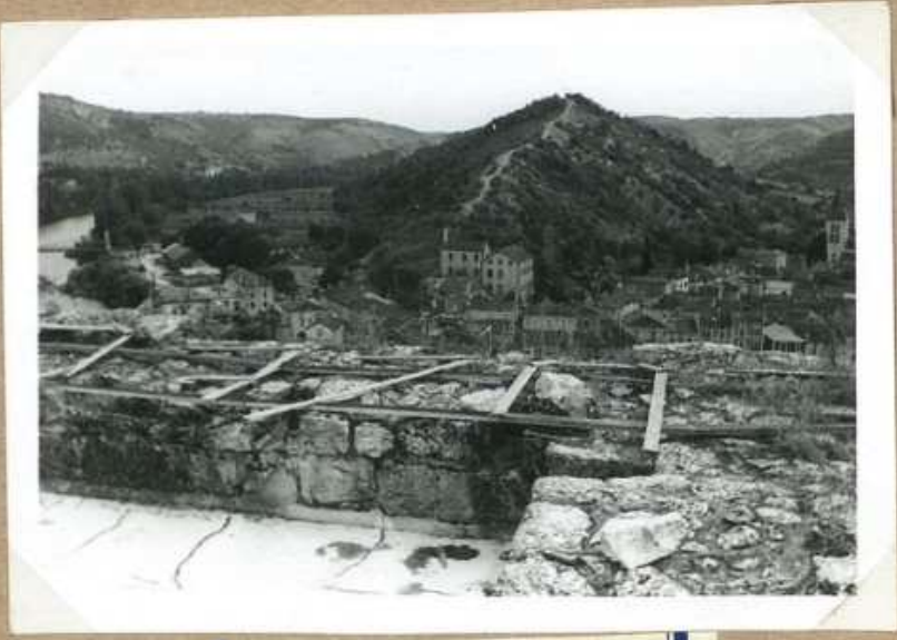
7619 La Pistoule 21-9/54 mur du Nord de la Fort
