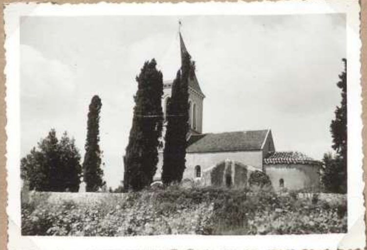
7677 Eglise de Cels Vue d'ensemble S
