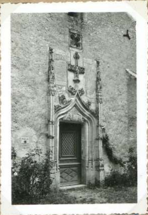
7653. Eglise N.D. de l'Isle. La porte d'entrée
