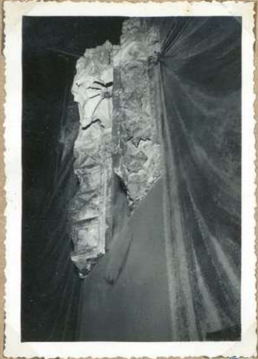
7603 Eglise: Vestiges XIV's. derrière l'autel
