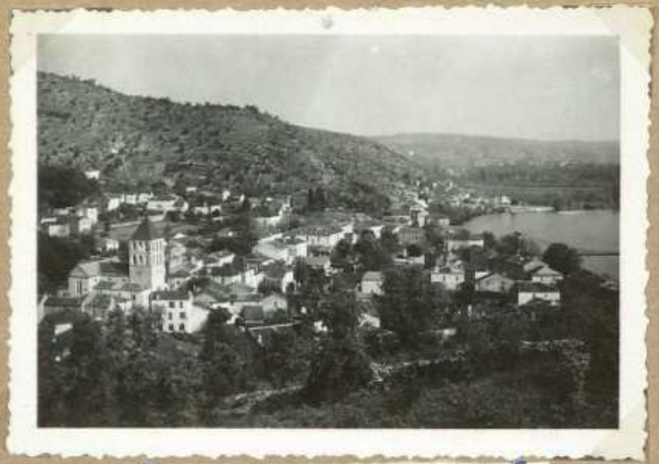
1249. Vue générale de la r. de Douelle
