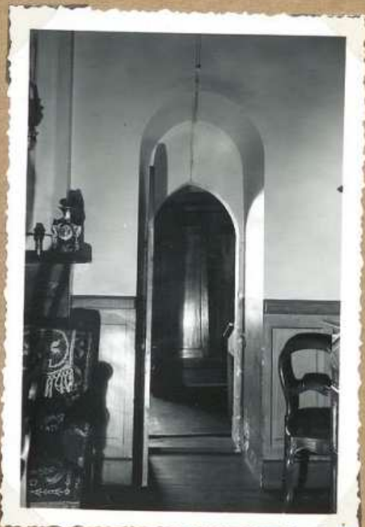
7320 Chateau d'Albas Trimmable Lafon: salle capit: porte d'entree avec bois
