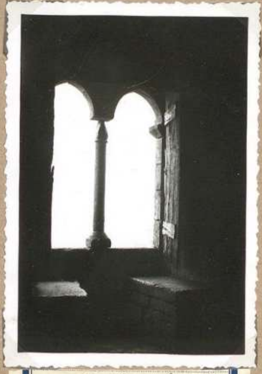
7468 M on Raynaly. Fenêtre général N. vue de l'int'
