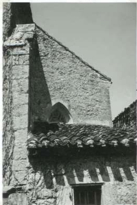
7485 Vestige fenêtre E Eglise
