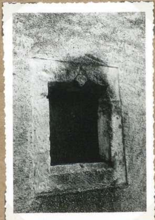
9006 Immeuble Bourg Gaston. Baie xv's
