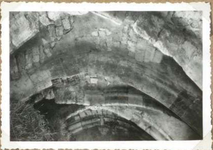
9431 Chateau de Trebaix Voûtes de la chapelle
