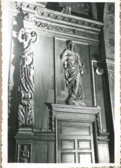
7671 Eglise: Boiseries au haut détail, côté épître.
