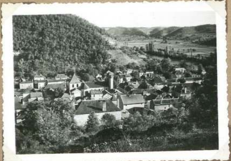
882. Vue générale N
