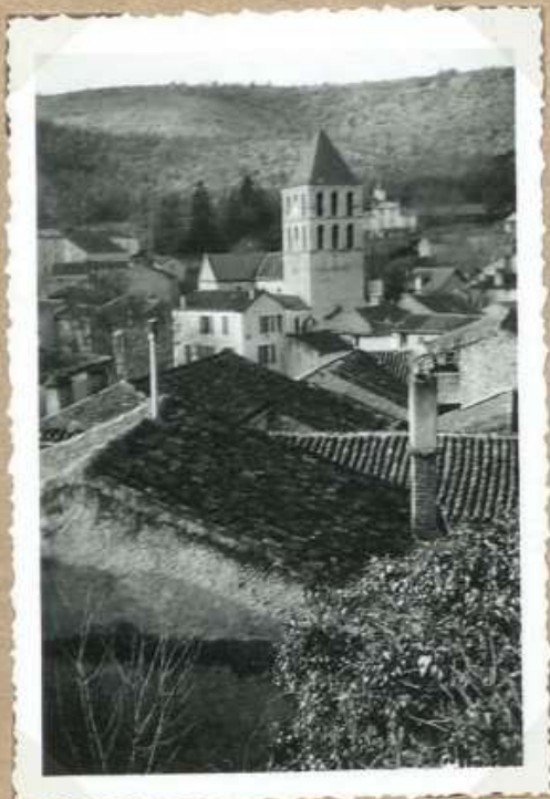
4910 L'église. Vue d'ensemble S.E.
