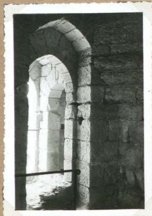
7623 La Tour . Façade N . porte sur le 4 e étage
