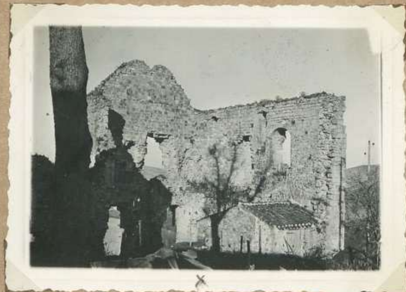
264 Ruines du ch âteau de Belaye
