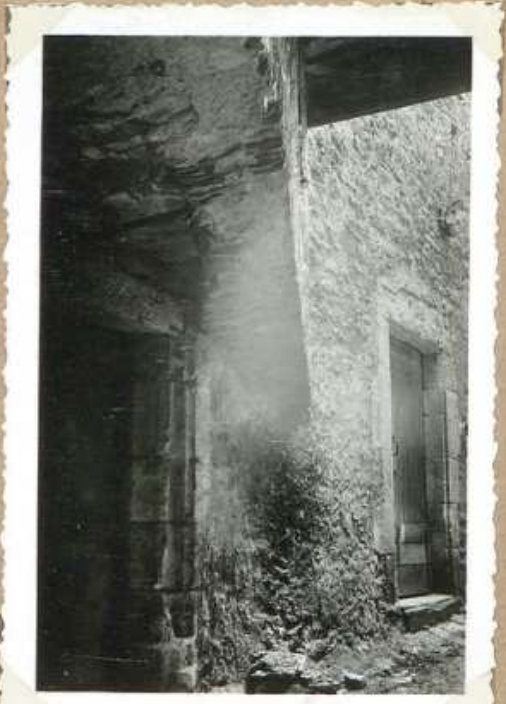
7292 Passage voûte' Maison Lizouret
