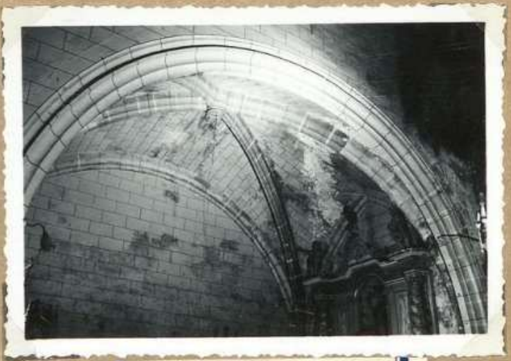
7330 Eglise d'Anglars - de arcade et voûte chap. e voûte
