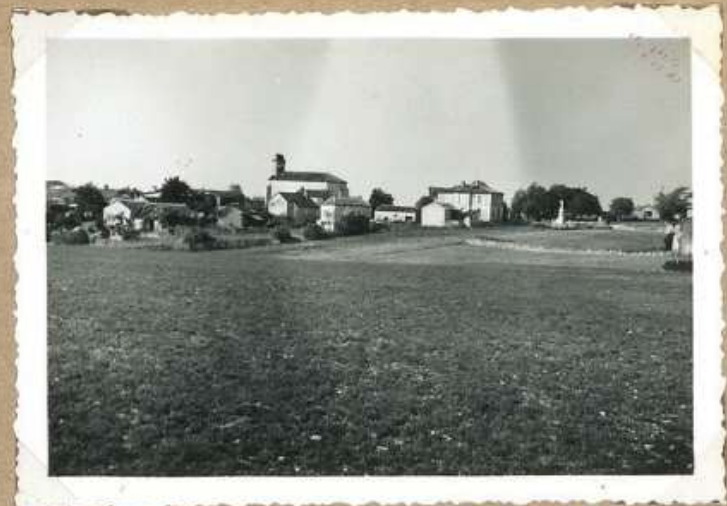
5900 Vue générale N.
