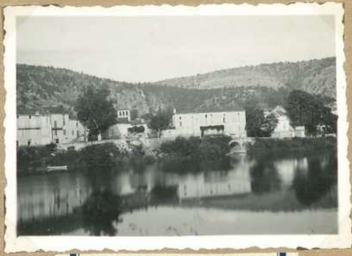
1248. Vue générale de la r. de Douelle
