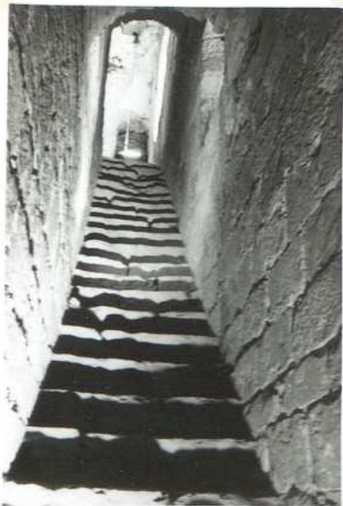
7405 Eglise: escalier du clocher. 27-8/54
