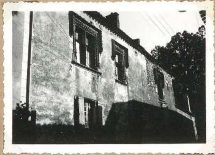
5898 trois fenêtres Renaissance
