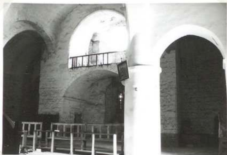
26-8/54 Eglise: int r - Vue sur la tribune 7409
