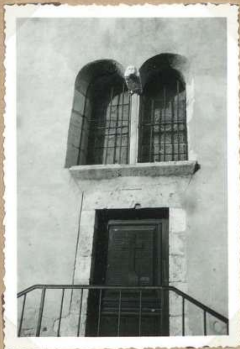
4915. L'église Fenêtre et porte (façade sud)
