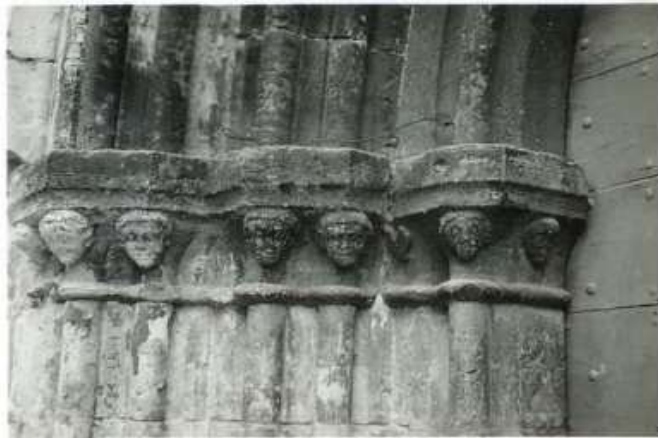
7546. Eglise: le portail, détails.
