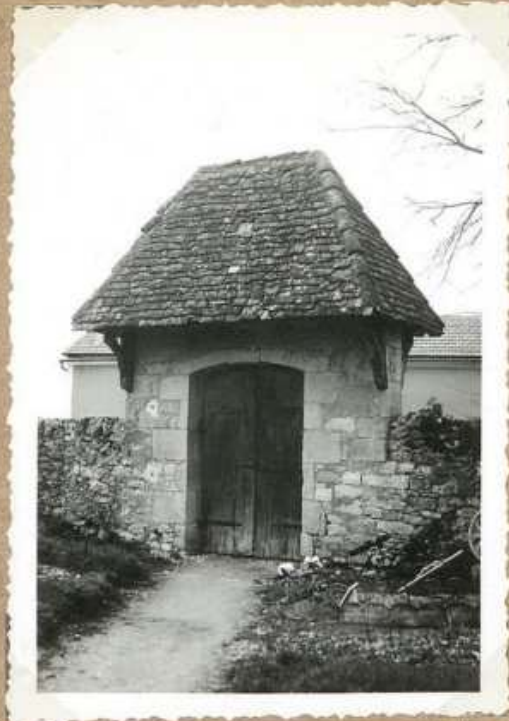
9401. Eglise de Villeseque. Porche d'entree, construction
