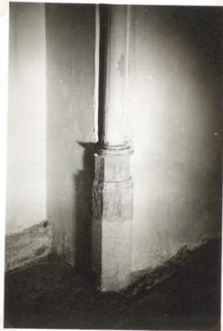
7410. Eglise: base d'une colonnnette du choeur
