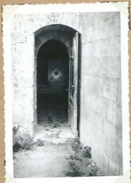
7411 Eglise de Latour porte N.
