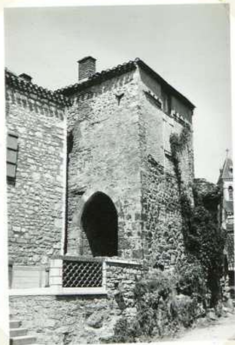
7297 Porte de la ville - E Vue d'ensemble
