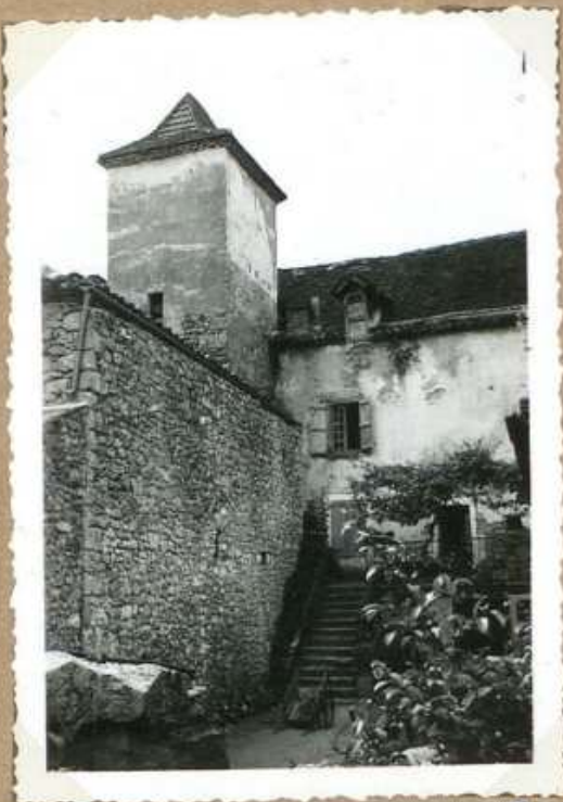
7694 M ons Guilhou Jervais Tour d'escalier
