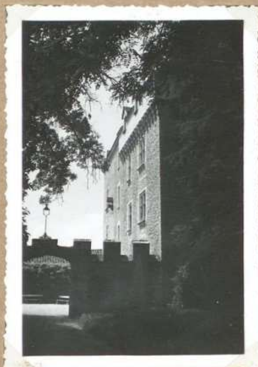
7502 Ch teau de Saugle - Porte entree et mur crenelle'
