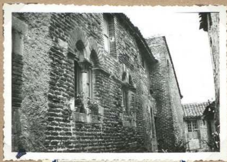
7624. Deux fenêtres adossées. jusqu'à des Olnades
