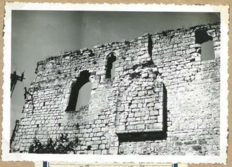
7453 Chateau de Belaye Détails facade est
