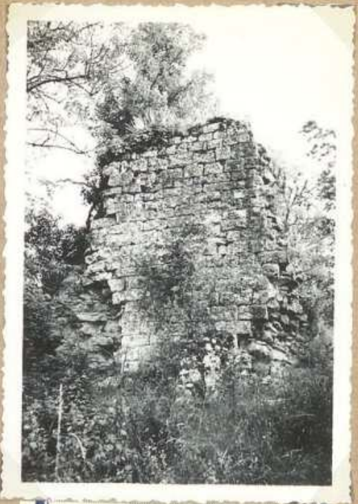
2459. Fortifications de Belaye Lutte N. du mur 0
