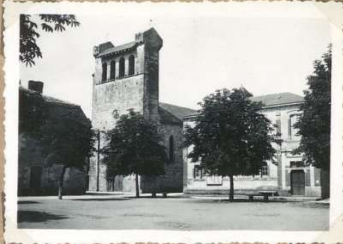
881. Eglise de Castelfranc ensemble
