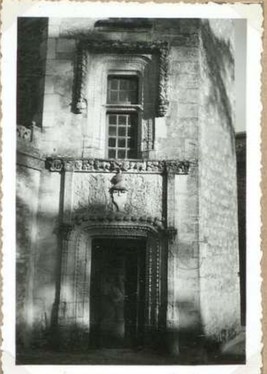
7470 Cheax de la Guezette Façade a. porte d'entree et fenestres
