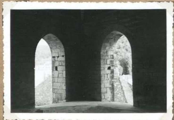
7556. Eglise: Base de la tour
