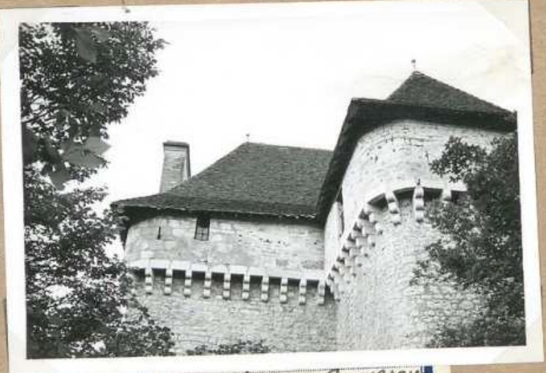
7427 Chateau de Cousseran 7424 Partie facade sud
