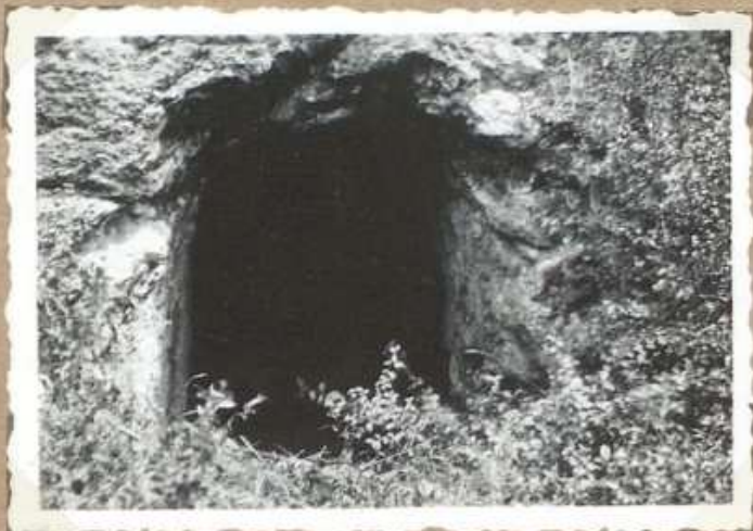
3 Tunnel de la "Manganèse"
