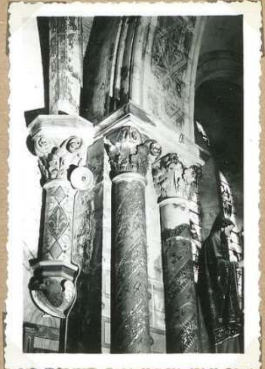
7555. Eglise: Colonnes et chap. de l'œuvre
