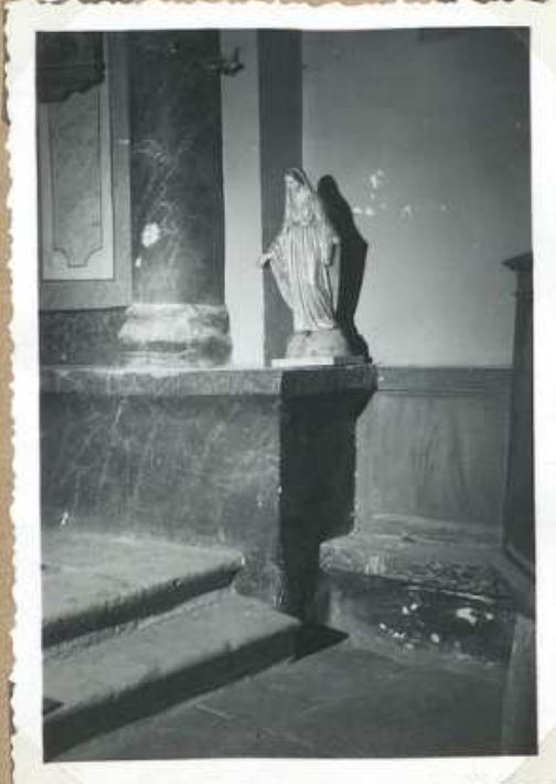
7642. Eglise de Caix Detail, au chœur
