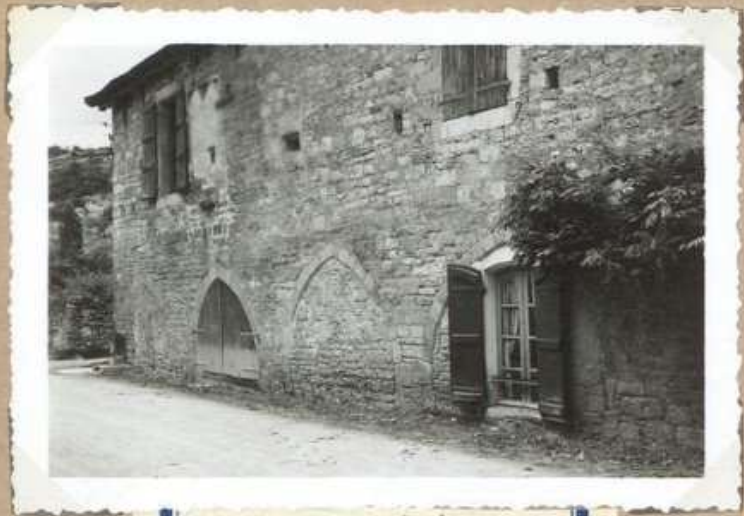
7568 Mon Aldobert facade ouest
