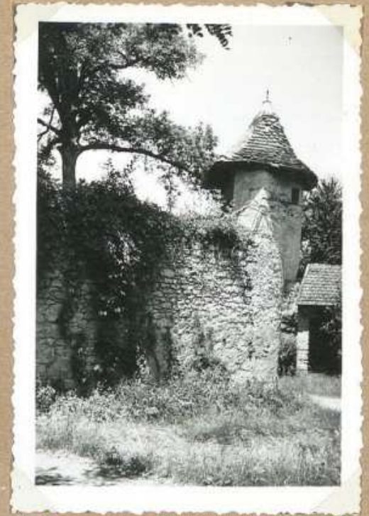
7510 Ch teau de Laugle Echauguette d'angle et partie de mur d'enceinte
