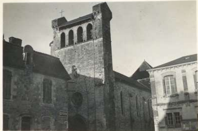
5868 Eglise de Castelfranc le clocher
