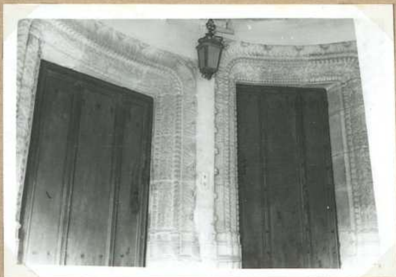
6-9/54 Ch eau de la Grézette 7477 Dans portes filmées 1 er étage.
