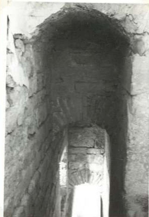
28-8/54 Escalier du clocher 7406 vu d'en haut
