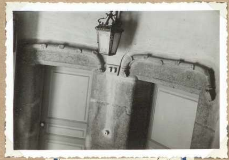
7451 Cheau de la Grezette Linteaux portes salon et salle à manger
