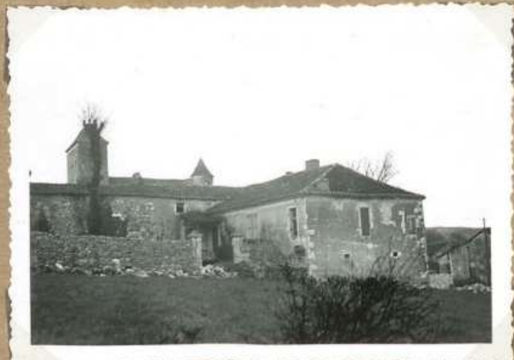
9019 - Presbytère de Carnac
