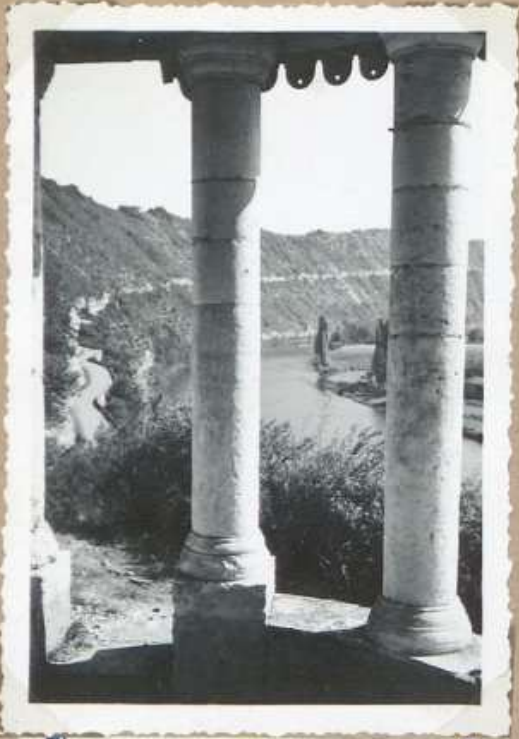
7643 Belvedere de Caix Vue vers l'amont
