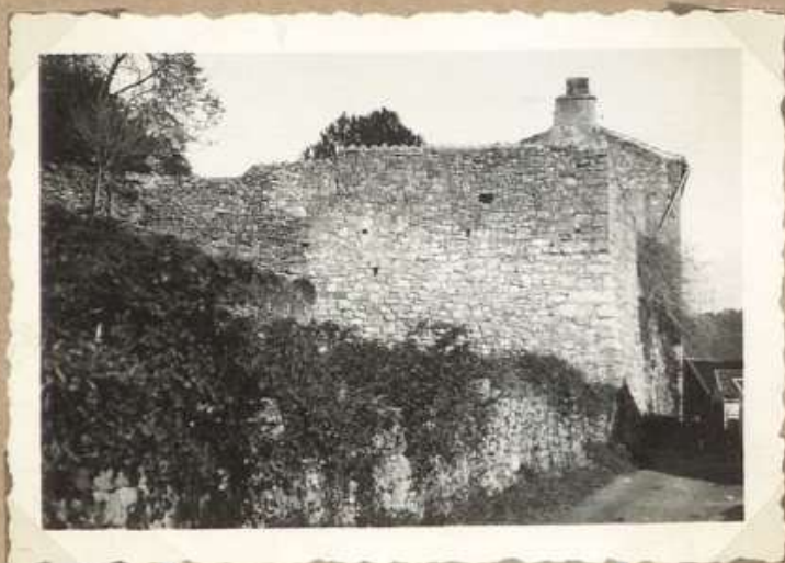
876. Vestiges de fortification de l'ancien "Château-franc"
