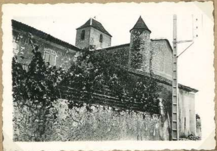
5831 Eglise, f. ouest.
