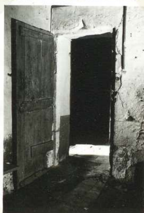
7358 M on presbytérale Porte entre le cloître et l'abbatiale
