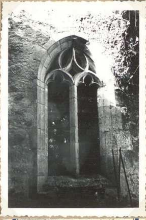
7452 Cheau de la Grezette Chapelle : fenetre, côté N.
