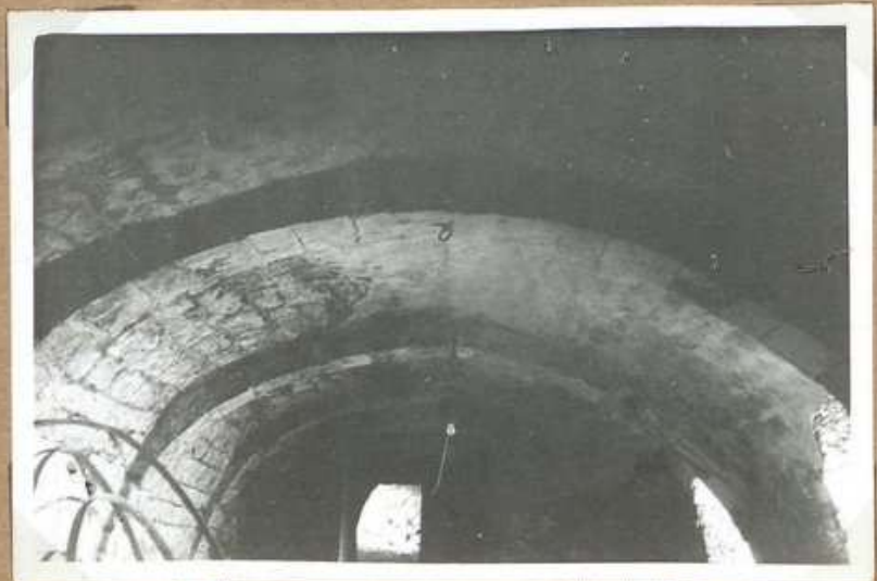
7319 Chateau d'Albas 19-7/54 Trimmable Lafon Voûte de la salle d'armes
