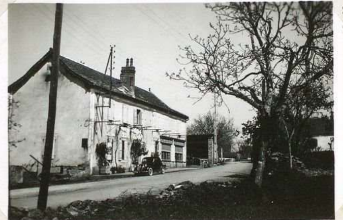
3190. Route de la gare
