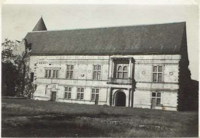
126. Le chateau: façade E
