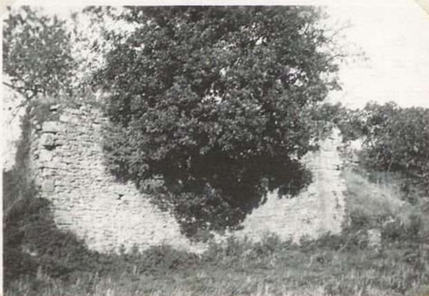
3451. Vestiges du ch âteau de Sonac
