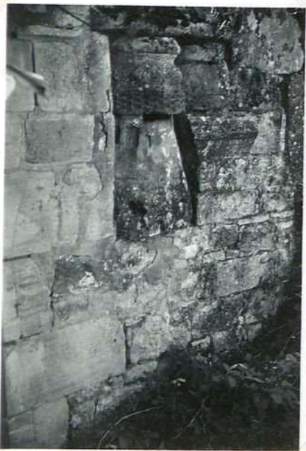
3193 Mur de clôture de la maison presbytériale
