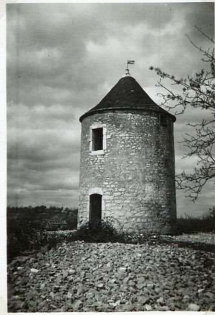
1302 Serruelin à vent
