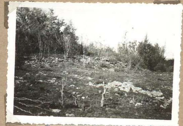
2917. Vestiges de l'ancien M in à vent de Placab
