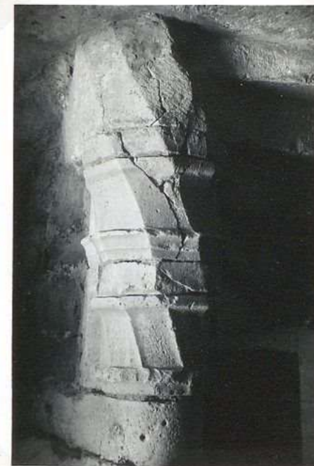
8946 Ch teau de Cabrerets Départ escalier à vis
