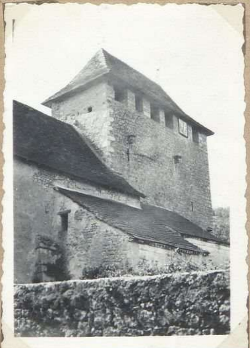
3876 Eglise de St Martin de Vers
