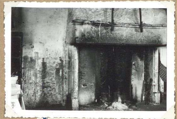
9272. Ch teau de Senaillac Cheminée 1 er étage XVII e
