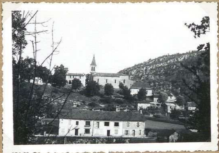
8963 Eglise de Cabrerets Vue lointaine S
