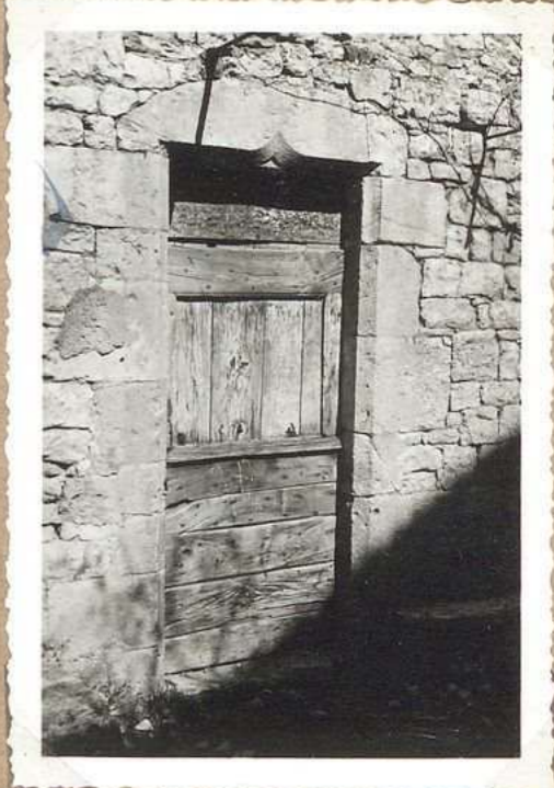
9276 - Immeuble Harceux Maison - Linteau accolé
