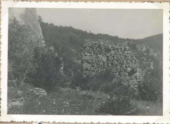
5987. Terrasse de Roquefort muret et porte d'accès
