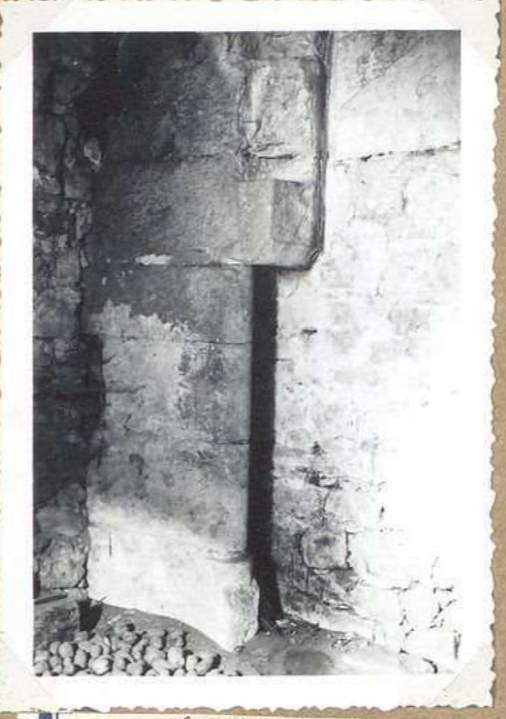
9324 Cl eau dit des Templiers - cheminée gothique 23. de chaunée
