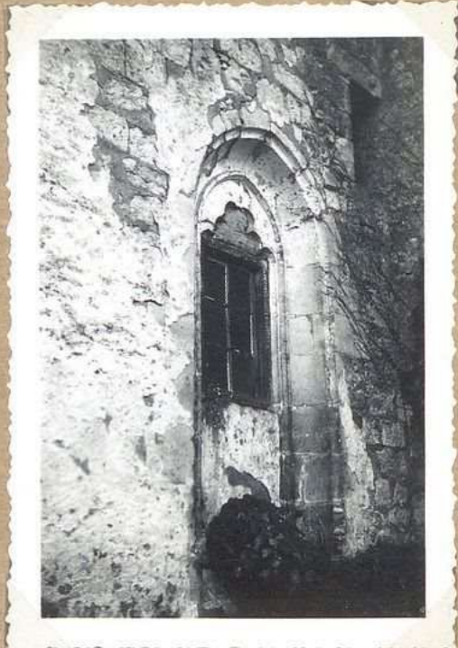
9310 Eglise de St Martin Fenêtre gothique O
