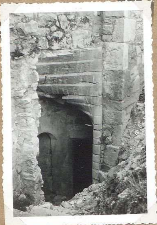
9283 - Ancien château Reste escalier à vis
