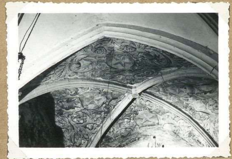
9316 Eglise de S t Martin voûtes du chœur
