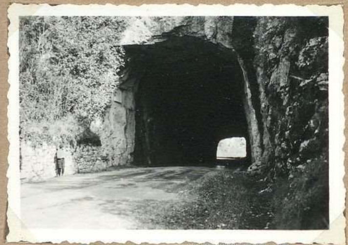
443 Tunnel de la Pescalerie
