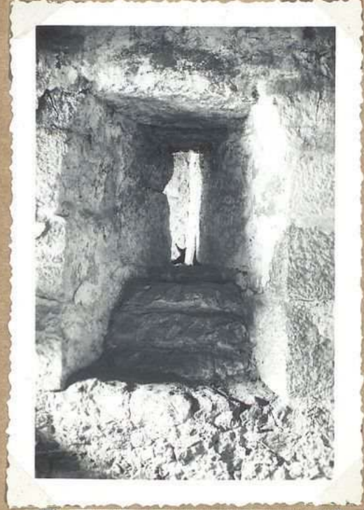
9325 Cl eau dit des Templiers - cheminée tournée vers le sud
