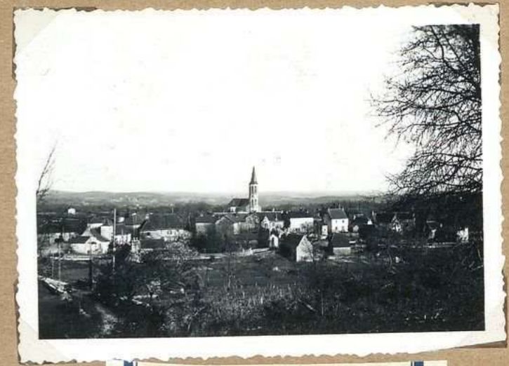
2249 Vue générale N
