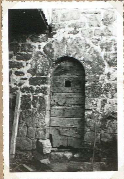
8001 Tour des Templiers porte du rez-de-chaussée
