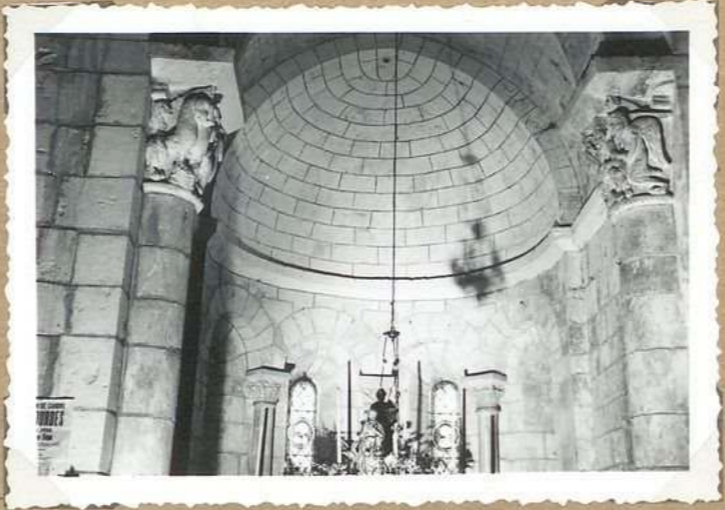
8915. Eglise de Blars Absidielle sud. vue d'ensemble
