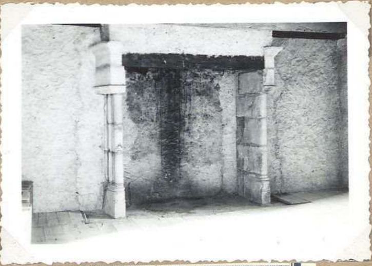
9321 Cl eau dit des Templiers Cheminée gothique 1 er et.
