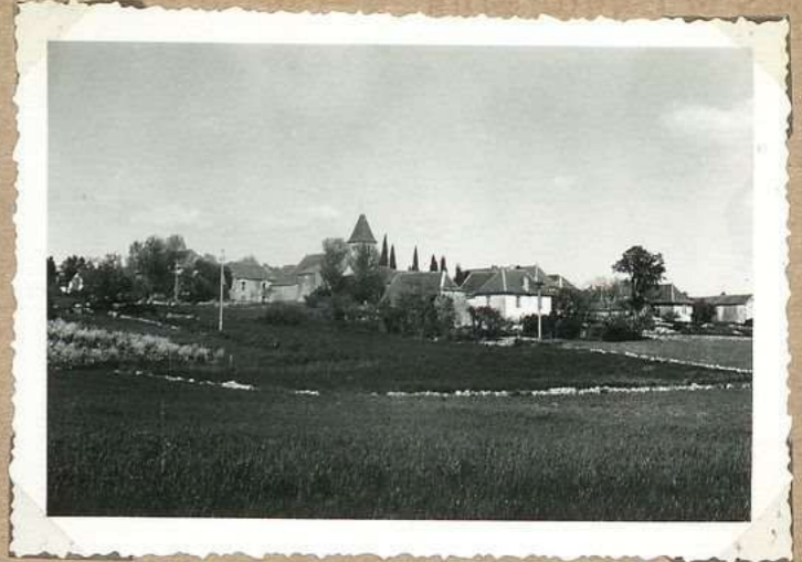
2909 b Vue générale
