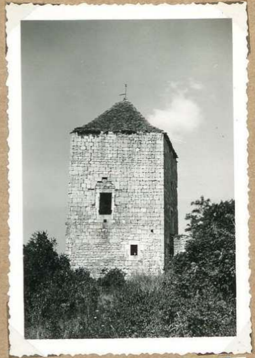
5425. Ch eu de Belfort Tour S.E.
