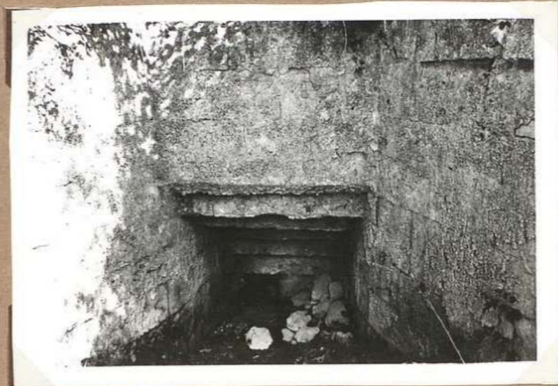
17-6-53 Moulin Haut. 5325. Conduit terminal de l'eau vers route à arbes
