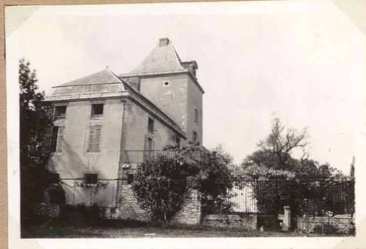
1061. Chateau d'Haute-Serre S.E.
