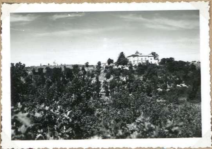
5323. Ch teau de Cieurac et moulin à vent E
