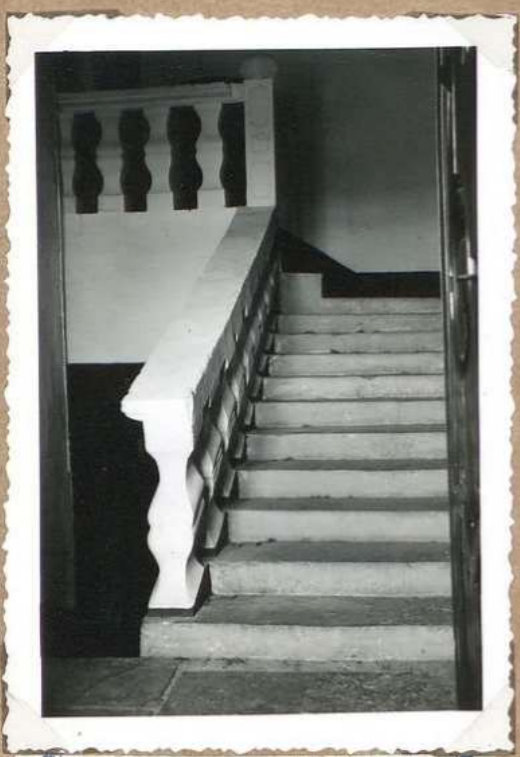
5431 Chateau de Belmont escalier 1 er étage
