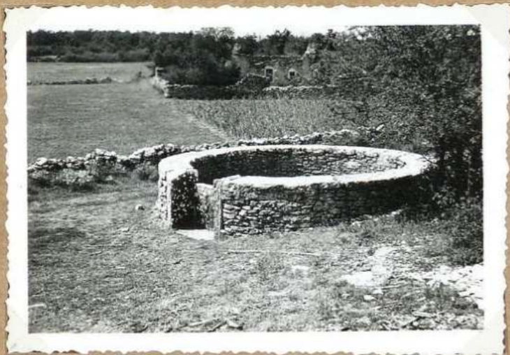
5387. Puits Crouzac (2 e puits) cylindrique
