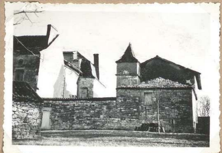
1480. Ch eau de Flaujac N. (ancien et nouveau chateau)
