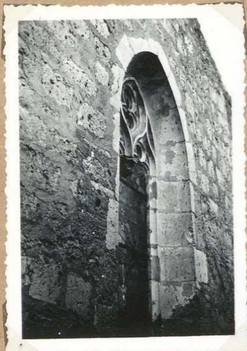
5498 Eglise. fenestra remplissage flambeaux
