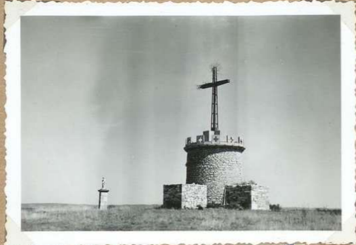
7913 M in à vent de Vaylats 1954 A été utilisé comme piédestal d'une grosse croix
