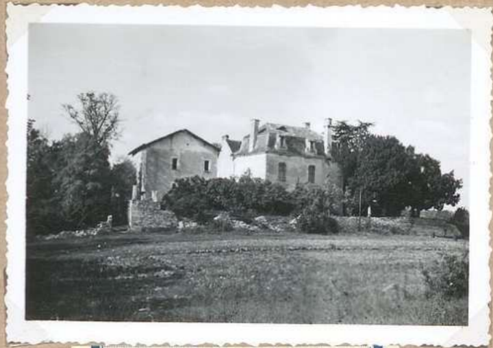
5467 Ch eau de Flaujac S.
