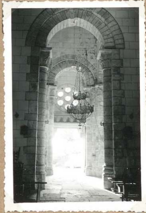
3348. Eglise d'Aujols Travée romane, vue de l'intérieur
