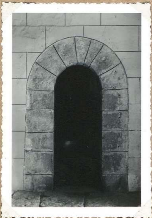
5340 Eglise d'Aujols, porte accès escalier tour du clocher
