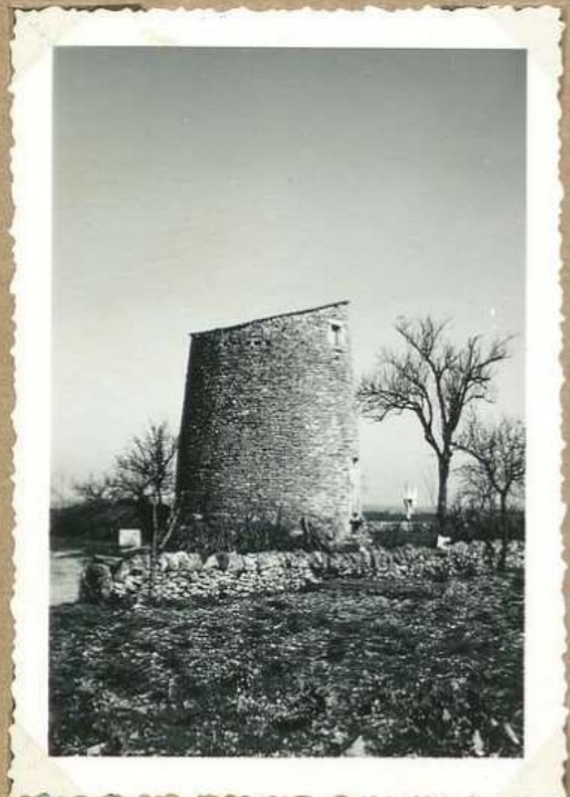
168 M un à vent de Bach
