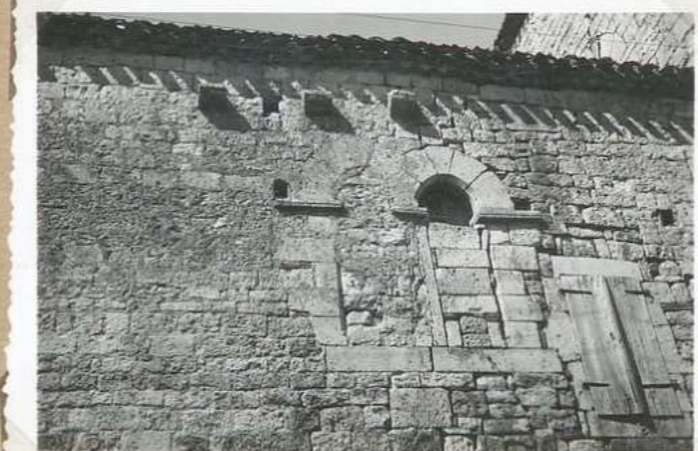
5549 Ch teau de Montdoumerc fenêtre terminée XIII e s.
