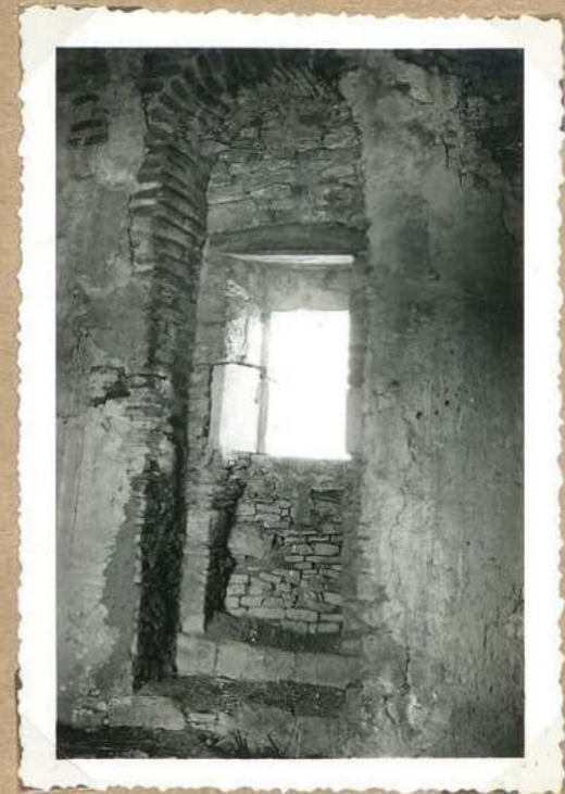
5490. Tour de Vayrols base 1 er étage
