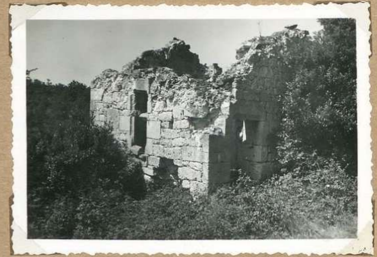
5422 Chateau de Belfort Mur du garde N
