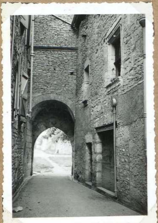
5544 Porte du Bolat vue de l'int r .
