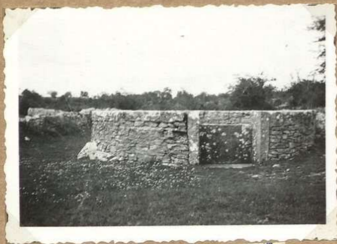
5388. Puits Crouzac: 2 e puits cylindrique 1939
