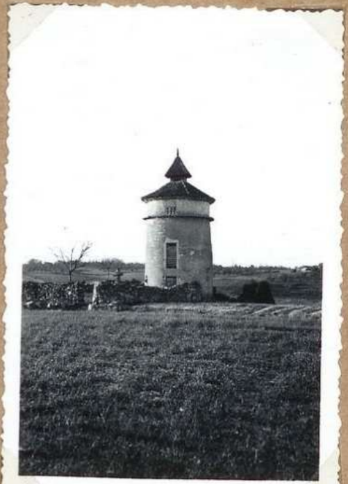
4372 - Pigeonnier, côté ouest de l'agglomération
