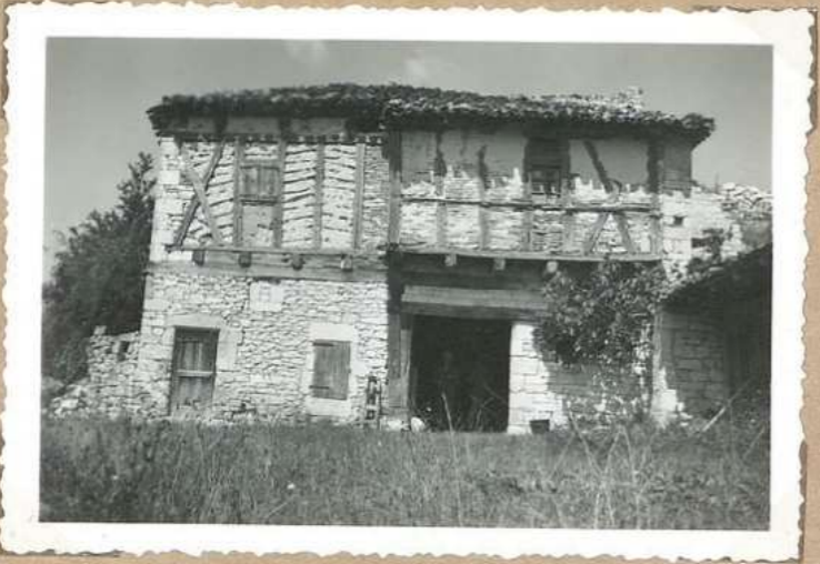
5416. Moulin à farine de bois. Pounau.
