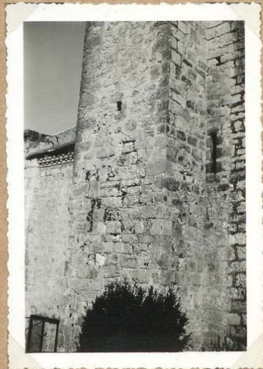
5342 Eglise d'Aujols. tour d'escalier
