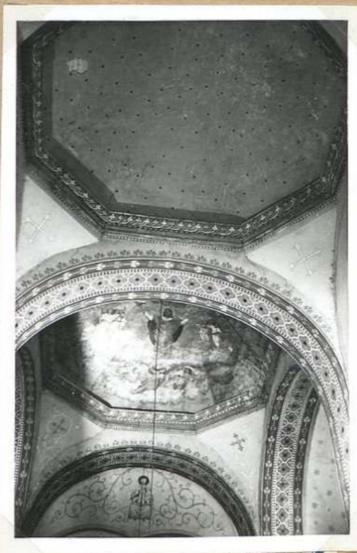
52-5-537 Eglise: vue partielle 5499 } des voûtes
