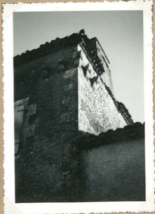
169 La Caminade: Console de maçonnerie
