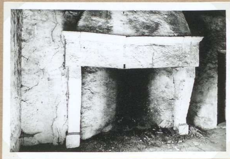
6-10/54 Tour de Bach 7897. Cheminée du 1 er étage XVII e .
