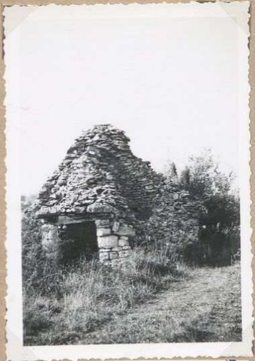
3319 "Gariotte" de Pradelles (structure)
