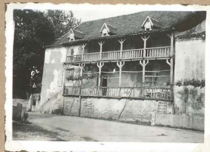
182 M on aux balcons de bois 3 e cl.
