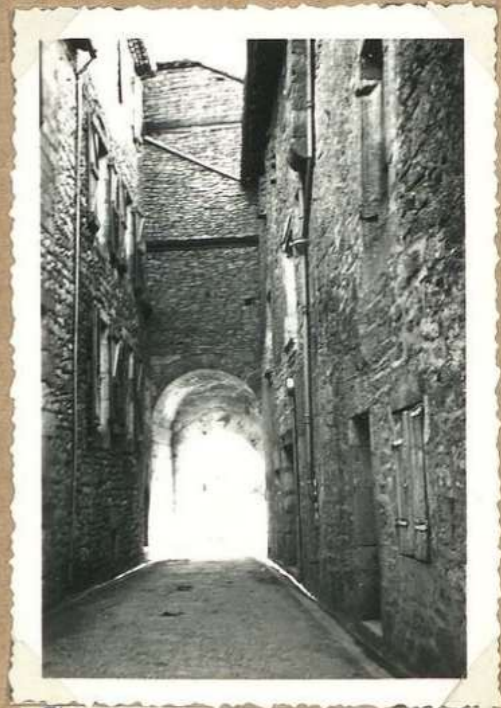
5545. Porte du Bolat vue de l'int r .
