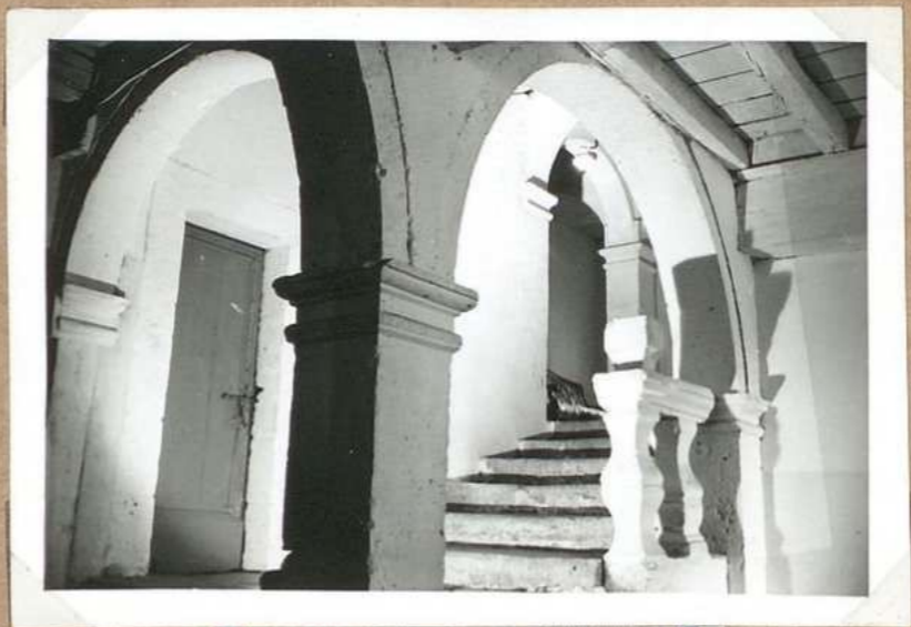
5435-5437 Chateau de Belmont 5432 Escalier rez. de chateau
