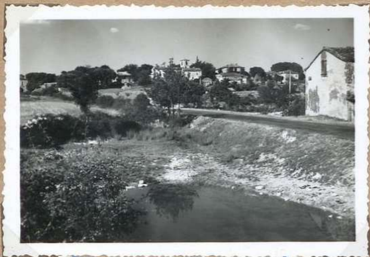
5428. Vue générale de la rivière
