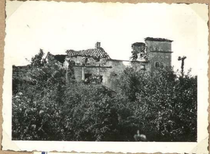
1184. Restes du ch eau de Cremps 1939(S)
