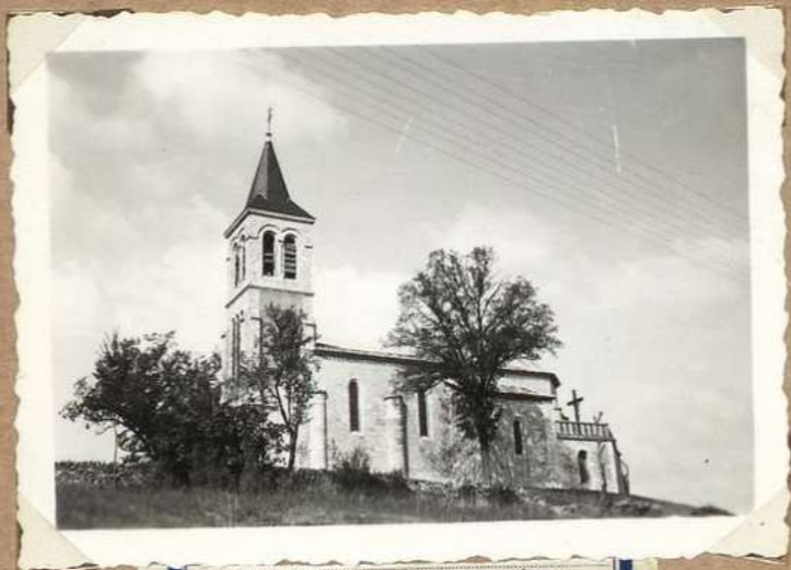
1544. Eglise de St Sever
