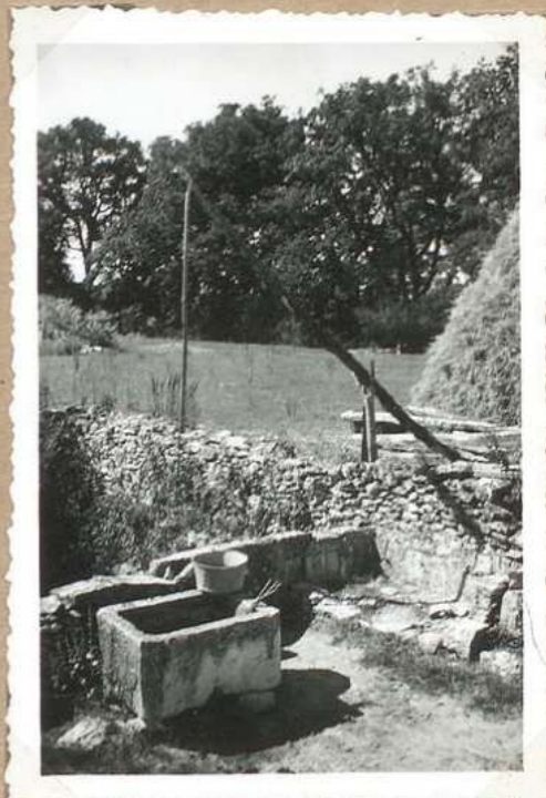
345. Loubejac: la "capleve"
