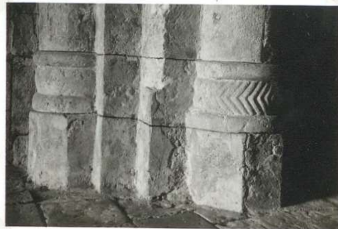
8893. Eglise d'Aujols Bases de colonnes
