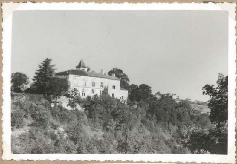
5-11/54 Chemin de Cieunac 7903 E. telle'
