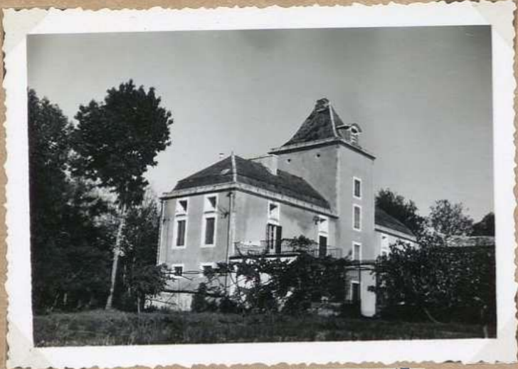
5327. Chateau d'Haute-Serre S.E.
