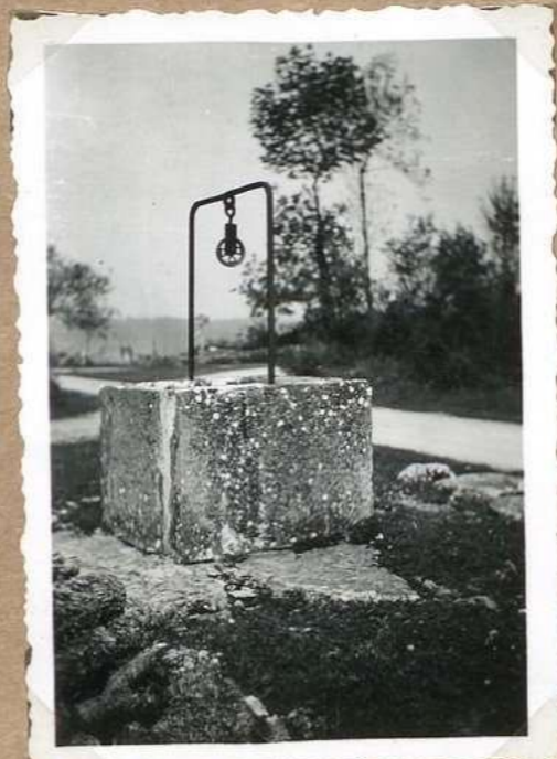
1193. Puits des Pouzeraques
