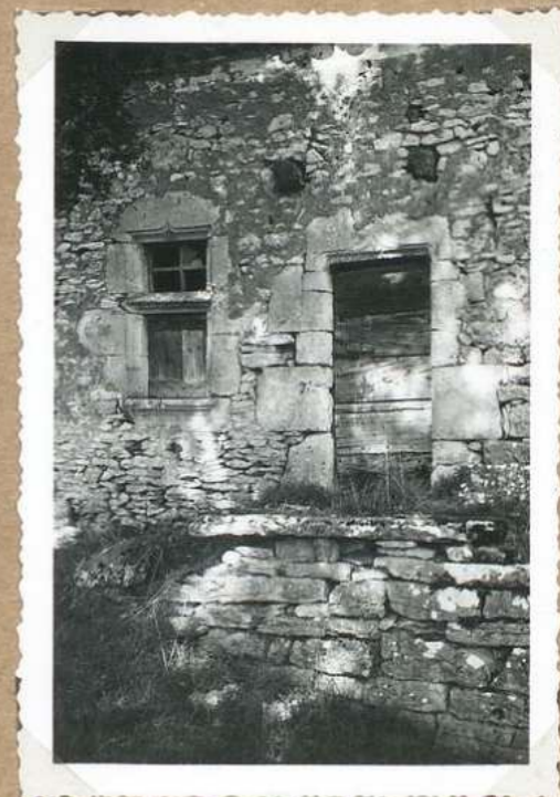
5488. Man V ue Riols. Detail porte et fenêtre
