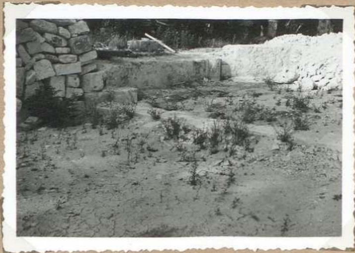
5412 Eglise de St. Fleurien destructions (1953)
