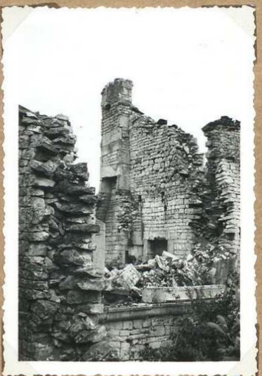
5449. Ruines de Cremps détail S.E.
