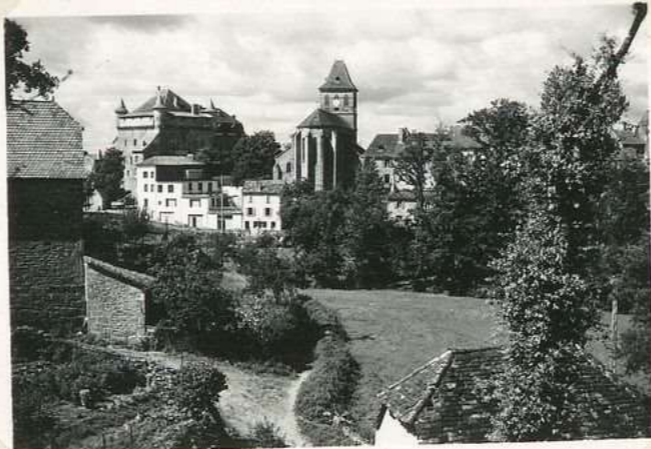
2019 Vue générale N.E
