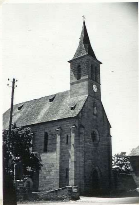
2312 Eglise de Leyme. (côté façade)
