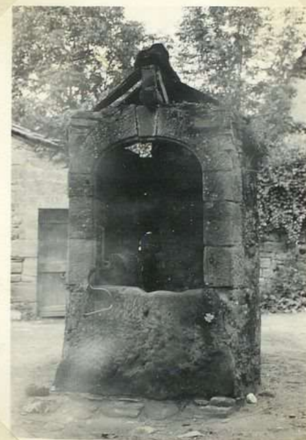
6132 Ancien puits du Fort
