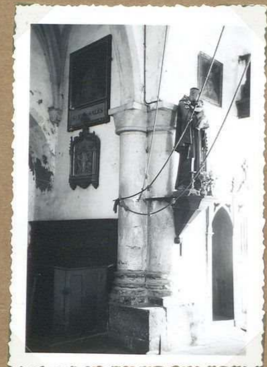
10.833 Eglise Colonnes du transept
