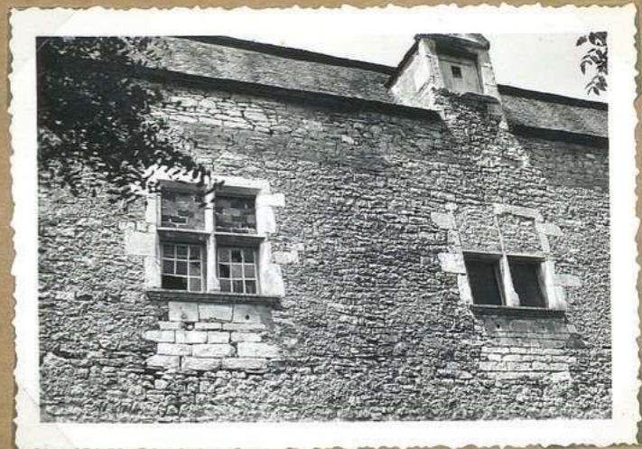
10.864. Façade Est baies à meneaux
