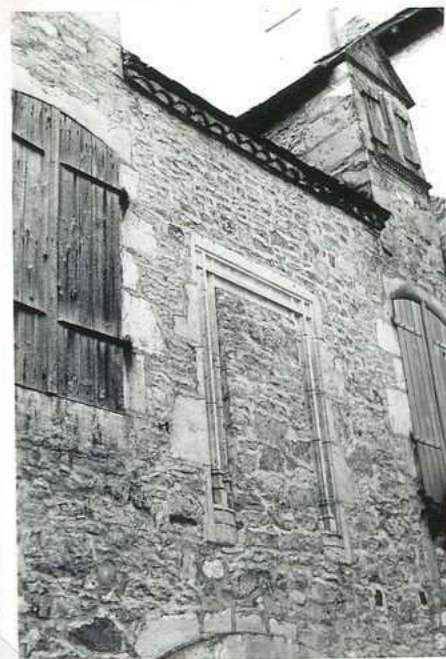
10.814 Mairie Fenêtre gothique
