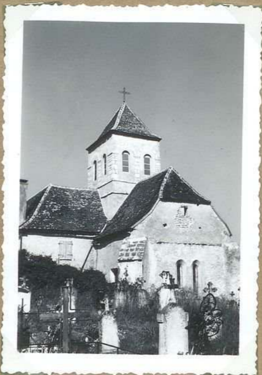
10.828 Abside Vue Est
