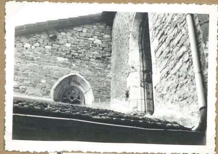
No. 943 Fenêtre flamboyant côté est
