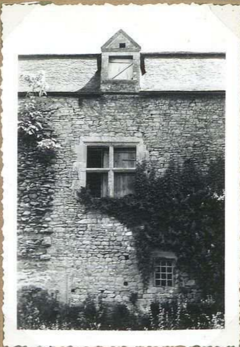
10.863. Fenêtrage à Meneaux. À l'est (cours interne)
