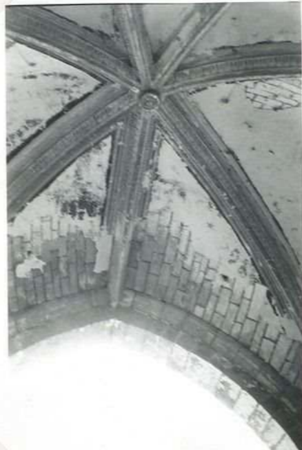
M.095 Chœur voûte
