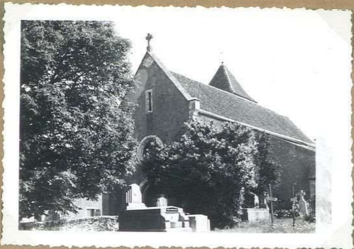
10853 Eglise Rue Sud
