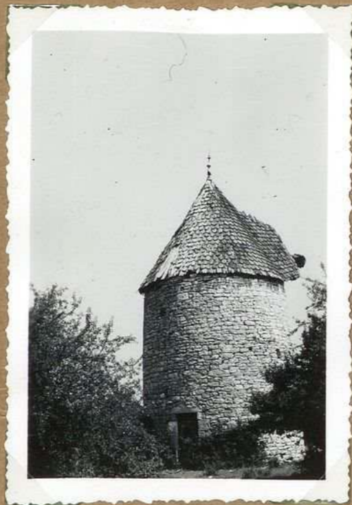
10.823 Moulin à vent de la P... la P...
