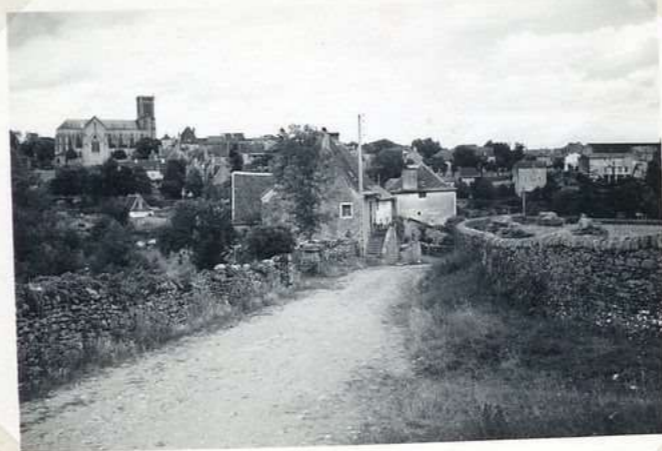
1753 ter Vue générale
