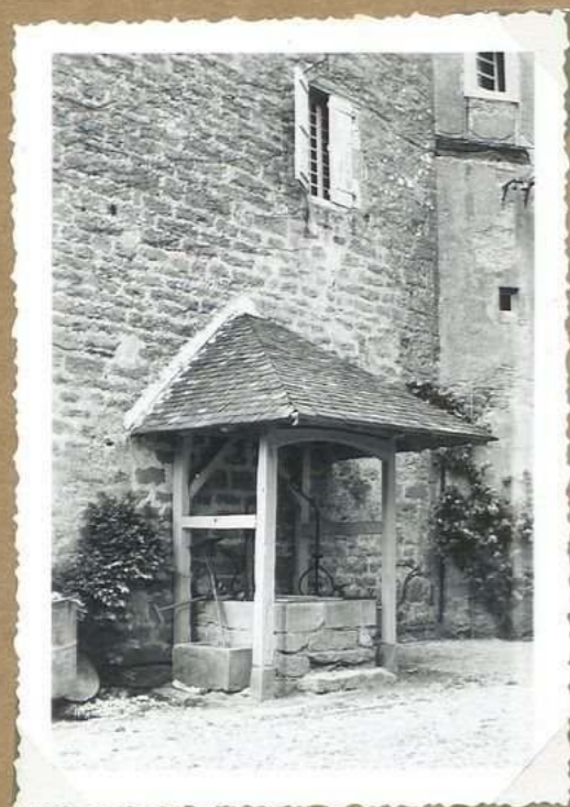
10.946 Puits du château de Salgues
