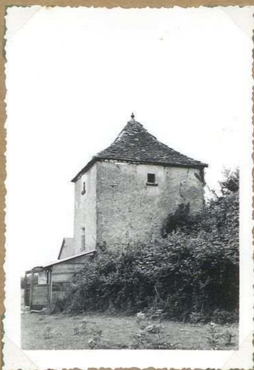
10.947. Pavillon F. Coppée
