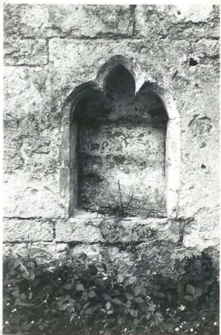
M.096 Crêdençe de l'au cirume ref. (Ruines de St Pierre)
