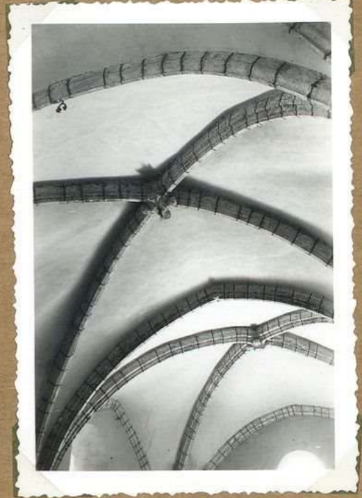
M.106. Voûtes d'ogives de la nef. chœur
