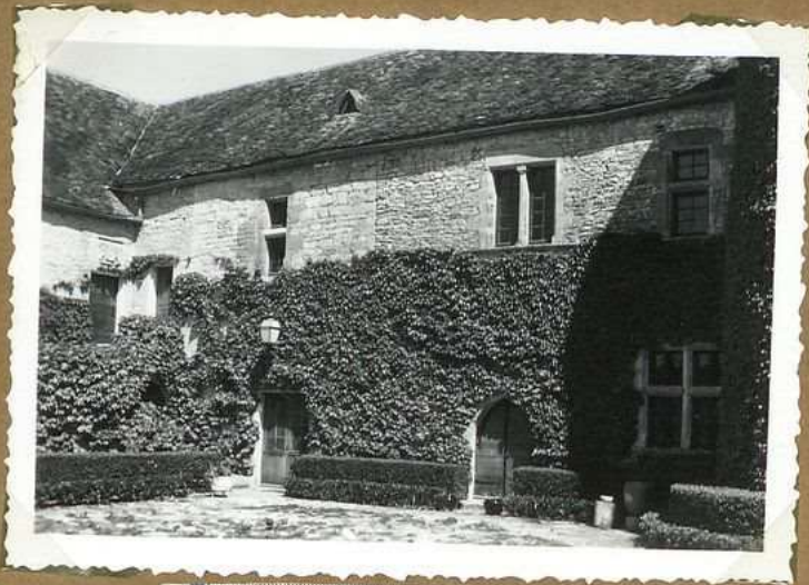
10399 Château de Pédriegal Cour vue sud
