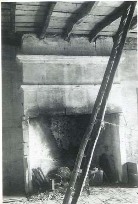
10553 Petit château de Milhac, cheminée 2 e étage
