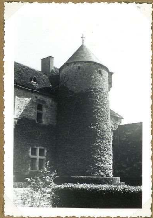
10400 Château de Pédriegal tour d'escalier (sud)
