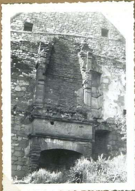
12358 Maison rue Filleol cheminée intérieure no 9
