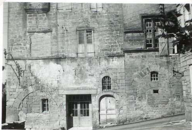
10479 Maison de l'archiprêtre est 4, Rue Cardinal Farina
