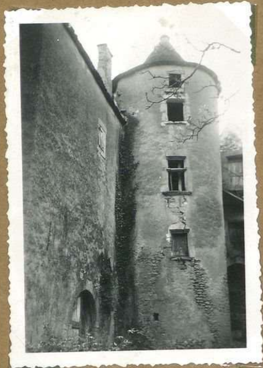
10575 Château XVI e la tour vue nord
