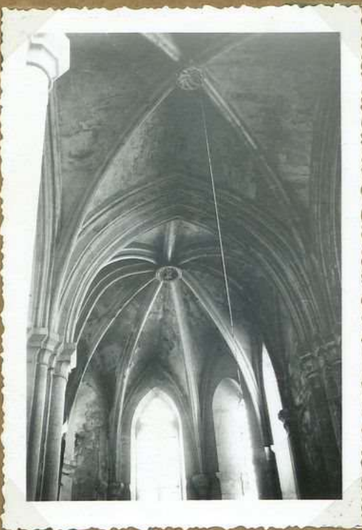
10615 Eglise du Vigan abside
