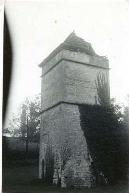
10501 Tour d'Alfort vue nord-ouest
