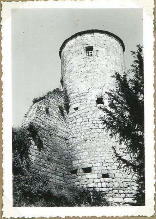
10549 Château de Milhac Tour Ramette (Sud)
