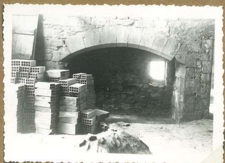
12351 Maison Frey cheminée
