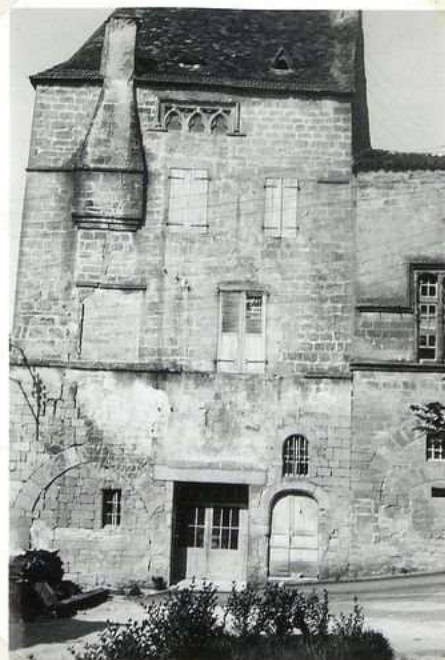
10477 Maison de l'archiprêtre facade est
