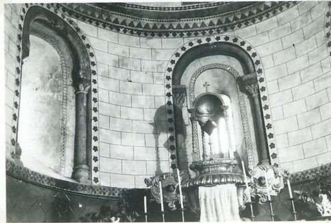
10390 Deux fenêtres du chœur
