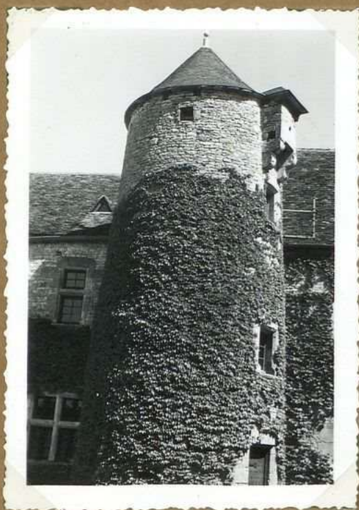
10398 Château de Pédriegal tour d'escalier (sud)
