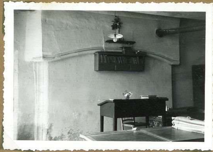
10467 Pension du Sacré-Coeur Cheminée rez-de-chaussée
