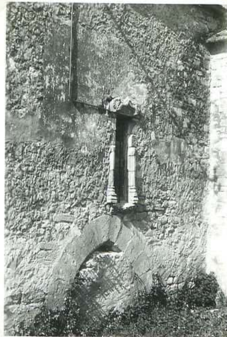
10586 Eglise de Rouffilhac arcade (sud)
