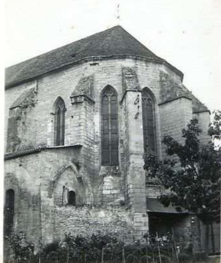
10428 Eglise des Cordeliers abside
