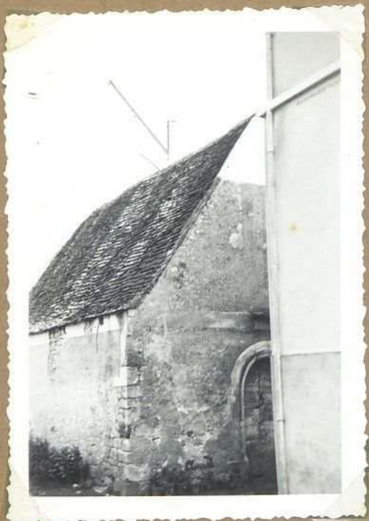
10608 Chapelle S te Radegonde, vue ouest
