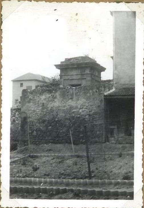
10507 Puits - Rue Colonel Taillade
