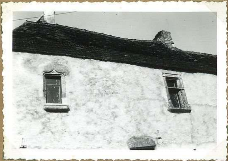
10590 Maison Cassagnes 2 fenêtres gothiques
