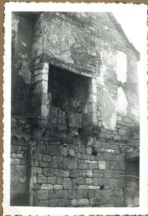
12369 Maison 8 rue du Majou cheminée intérieure
