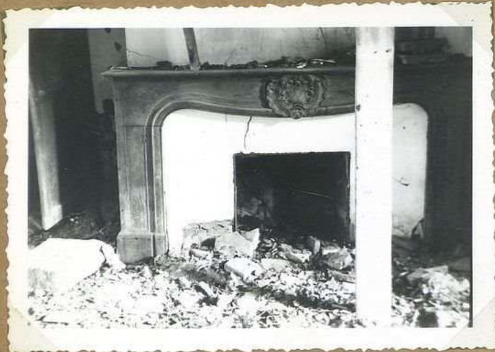
10563 Presbytère de Milhac cheminée en bois
