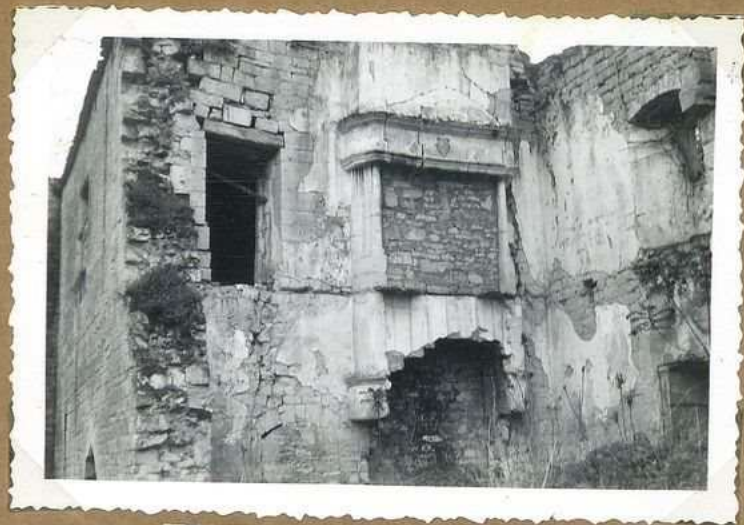
10423 Château de Coupiac cheminée double
