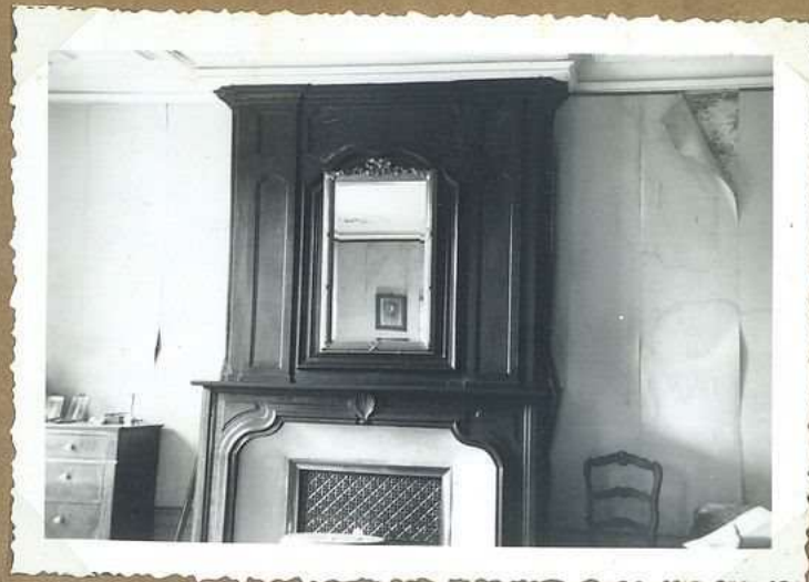
10494 Cheminée de Cham- bre (Maison Malleville)
