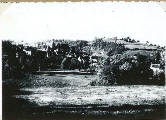
4274. Vue générale N.
