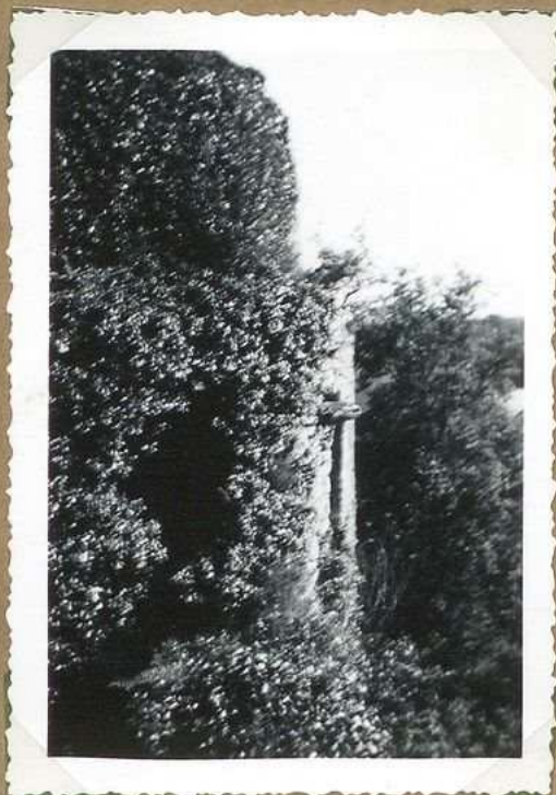
10545 Château de Milhac Cour, tour est
