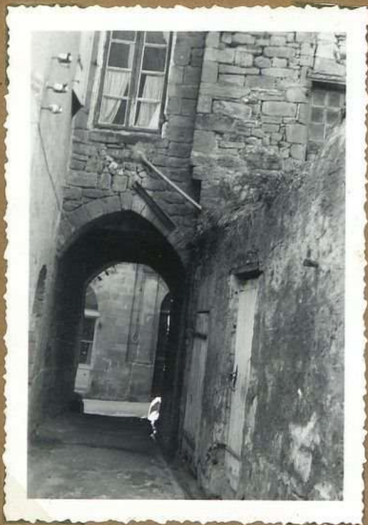
12364 Passage voûté. Rue de la Mairie l'enc de l'intérieur de la rue
