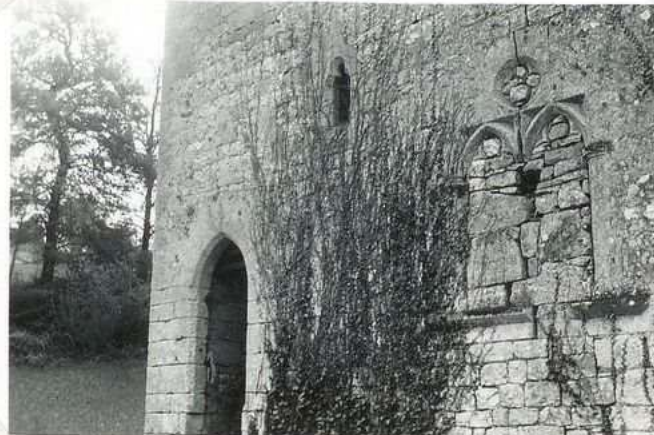
10505 Tour d'Alfort détail côté nord
