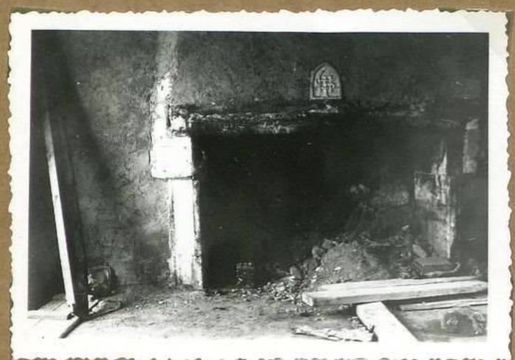
12349 Maison Frey cheminée
