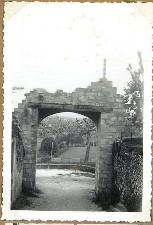
10508 Portail, rue petit château sud entre rue Marin
