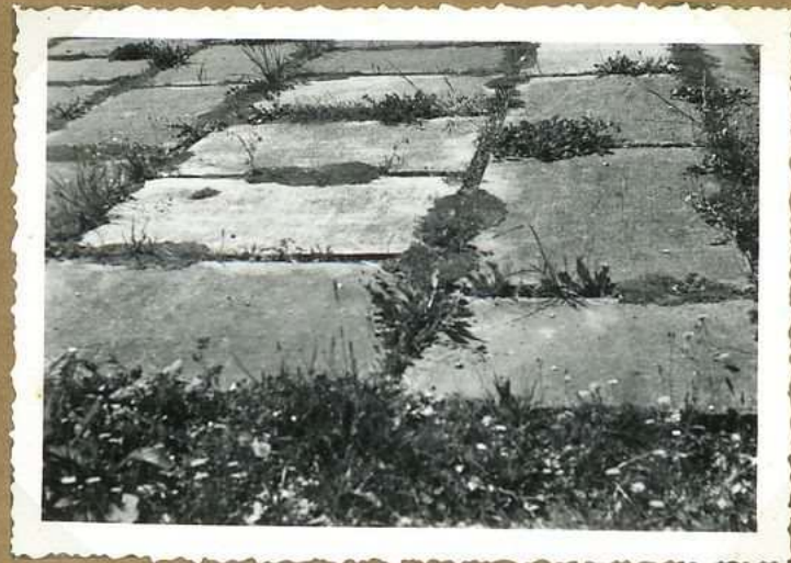
10347 Château de Pédriegal escaliers de la cour
