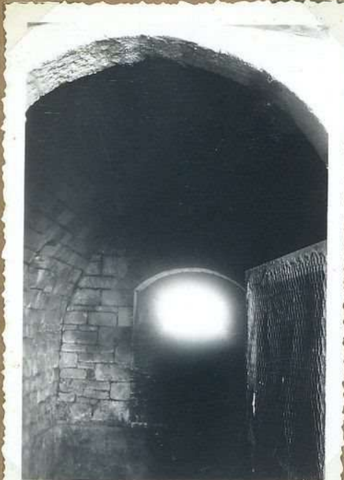
10493 Maison Malleville Cave voûtée
