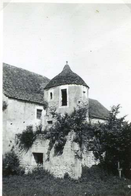
10558 Petit château de Milhac vue sud
