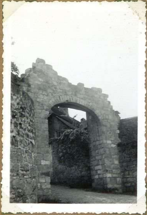
10506 Portail, rue petit château Nord
