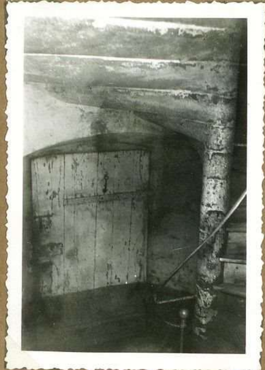
10471 Pension du Sacré-Coeur Escalier de la tour
