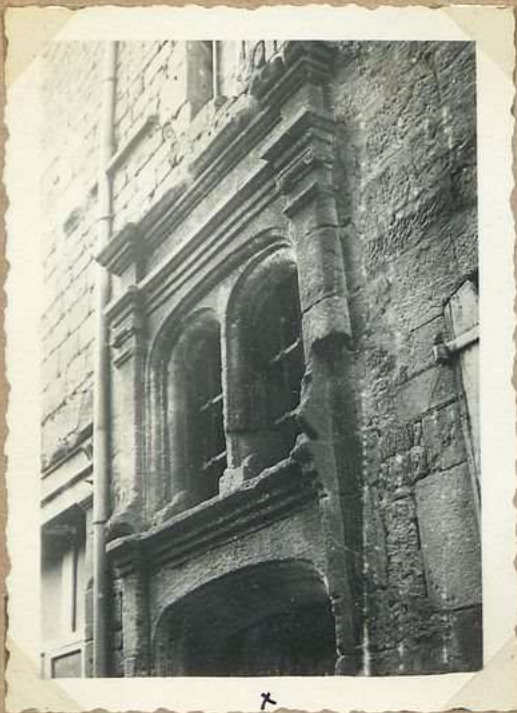
1709 Fenêtre géminée XVI e Rue Zig-Zag
