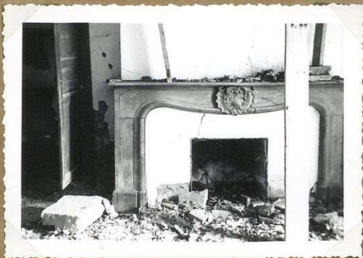
10567 Presbytère de Milhac cheminée en bois
