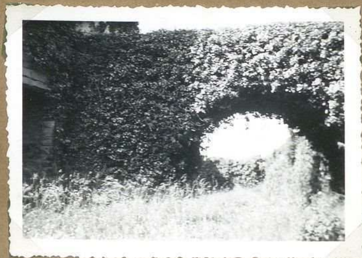
10546 Château de Milhac Pont et fosses
