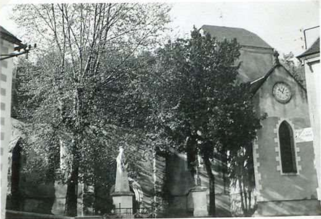
10392 Eglise vue Sud
