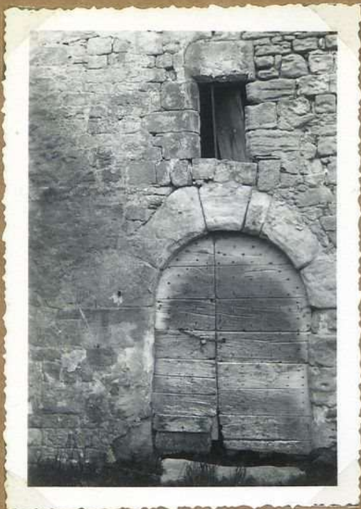
10486 Maison de la ville Rue d'agnone. facade sud
