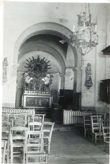
10515 Eglise de Payrignac ensemble du chœur
