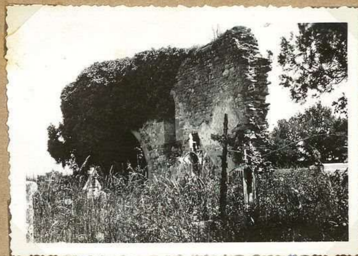
1354 Vestiges de l'église de Rigant
