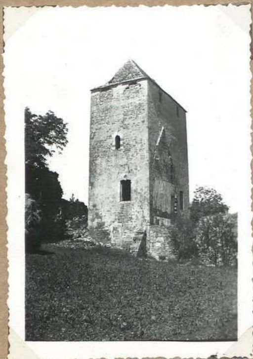
728 bis Ch teau de Camboulit
