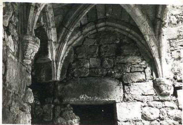
725. Ch teau de Camboulit Vestiges. v. d'ogives.
