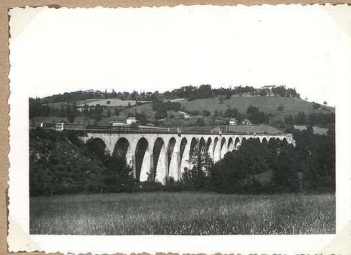
724 Viaduc du Drauzou
