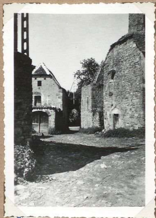
730 Ancienne porte fortifiée vue latérale
