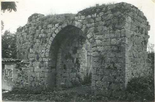
764 - Première porte Côté nord.
