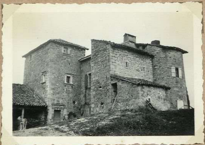
737 Ch eau de Favard vue d'ensemble
