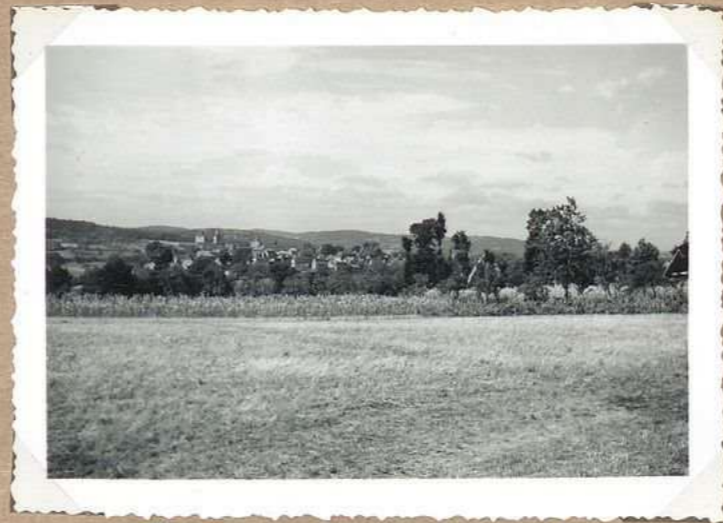
733. Vue générale - est
