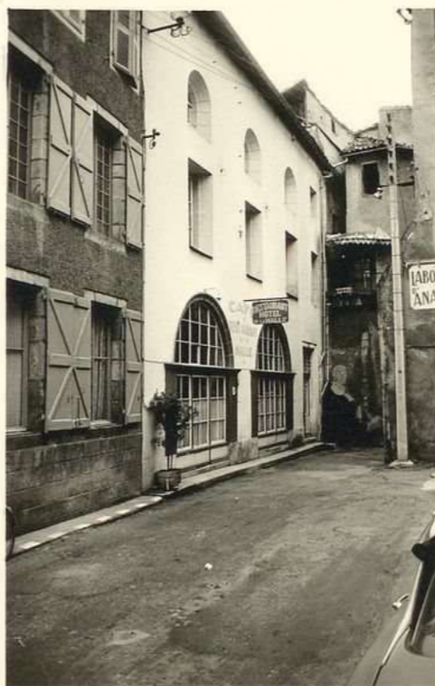
12.647 Immeuble Hauticlet 11, rue de la Courneillette
