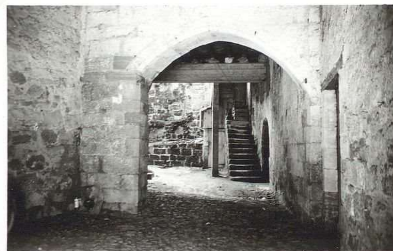
12.824 Immeuble Solery 20, Rue de Colomb
