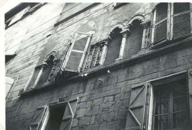
1441 Anciennes fenêtres Rue E. Lola
