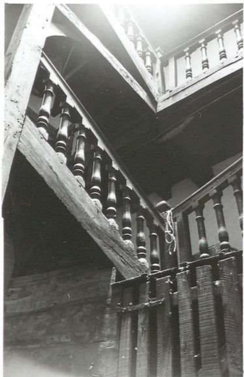
12.661 Immeuble Rogues 13, place Carnot
