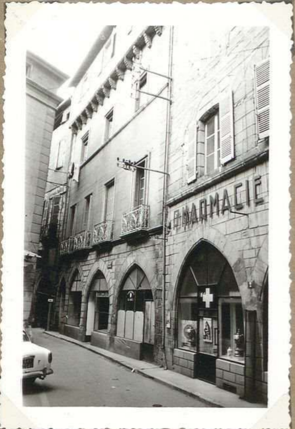
12669 4, rue Séguier Maison Lafabrie
