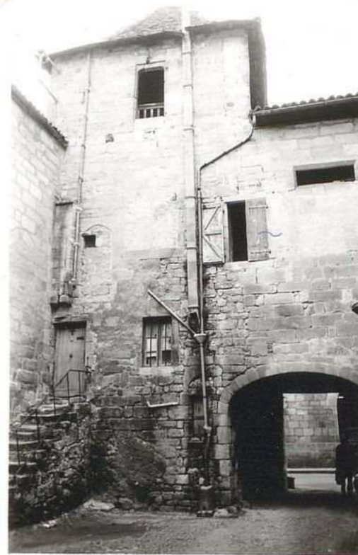
12.642 Maison Cipier 3, rue du 11 Novembre (cour)
