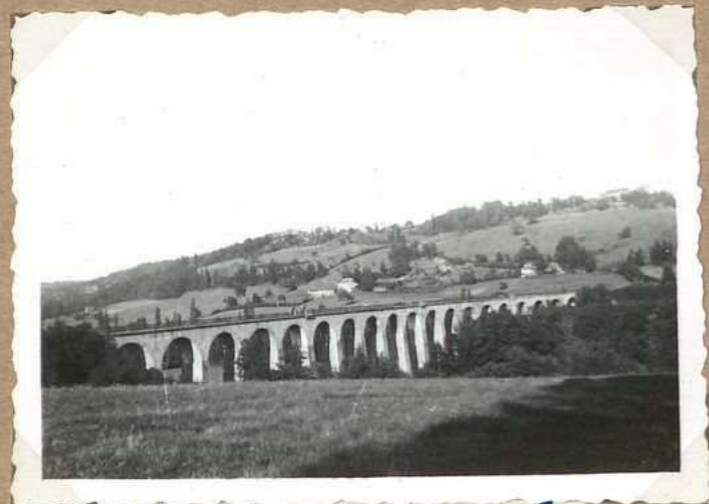
1394 bis. Viaduc de Drauzou
