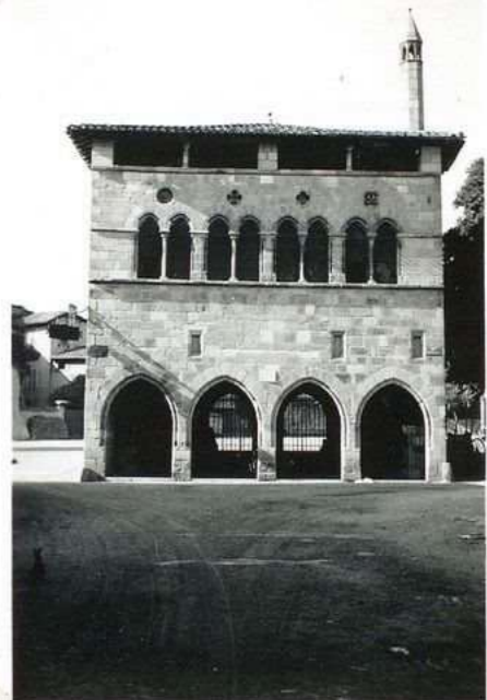
1424 Hôtel de la Monnaie façade sud - 2 cl.
