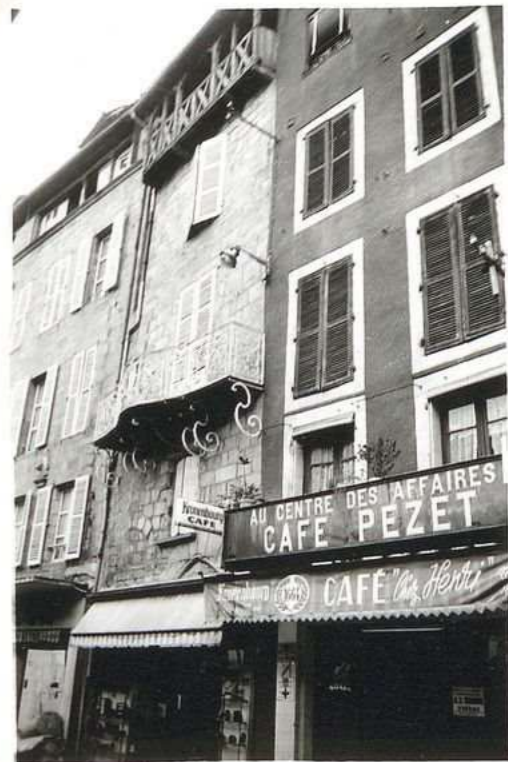
12.663 Immeuble Tourner 14, place Carnot
