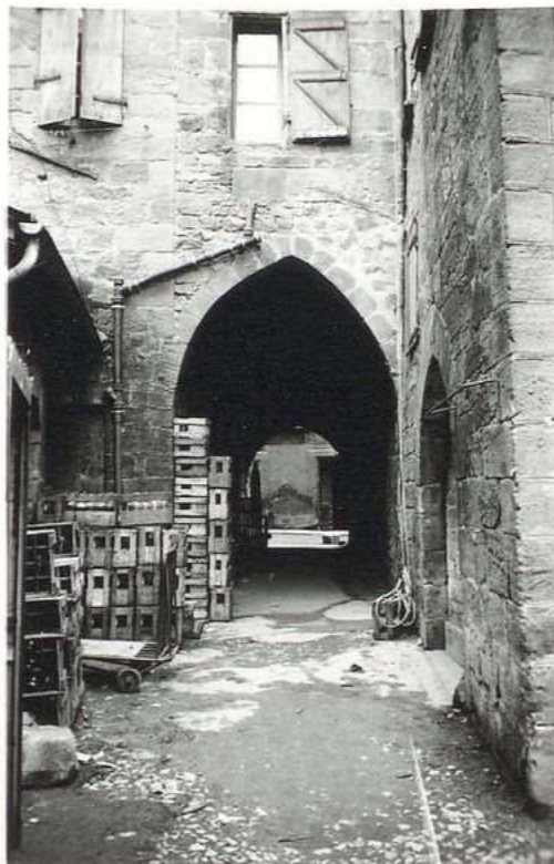
12.737 Immeuble Devès Porte Garin et 31, rue Caviale
