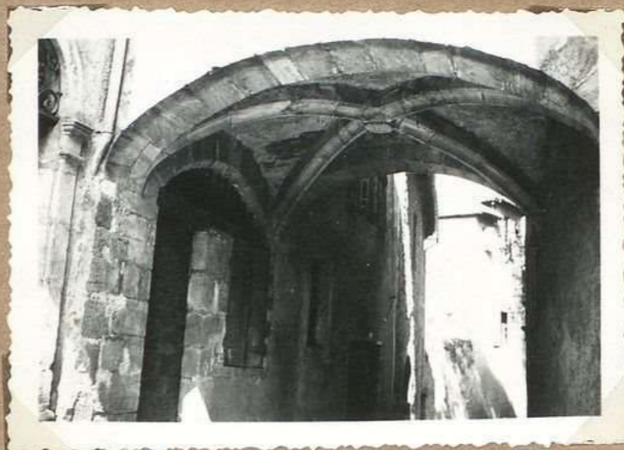
1448. Ancien hôtel de Laporte voûte d'ogives
