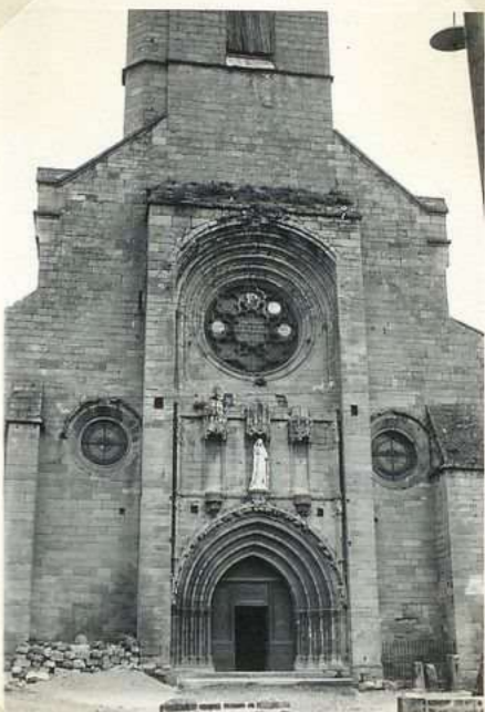
1397. Eglise N.D. des Puy la façade
