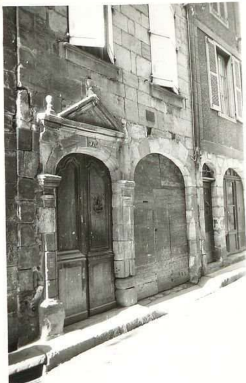
12.759 Maison Catdisti 37, rue E. Zola
