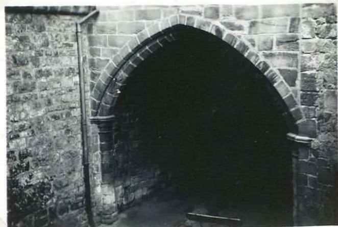
1440 Entrée de cour à l'auberge 47. Rue Sawketha
