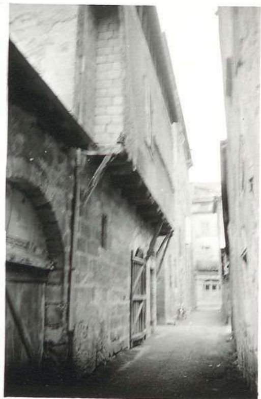
12.707 Immeuble Vayssé 5, rue Lamière
