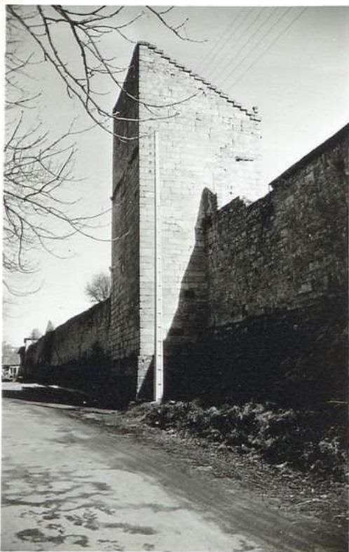
12831 Les Remparts Tour centrale
