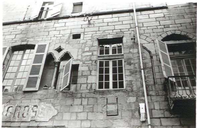
Maison Alby 12.649 17, Rue de Clermont
