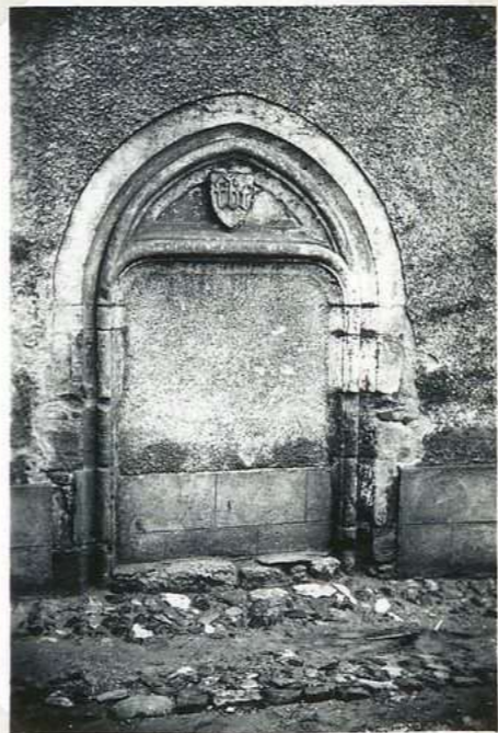
1406 Vestiges de l'ancien couvent des Carmes
