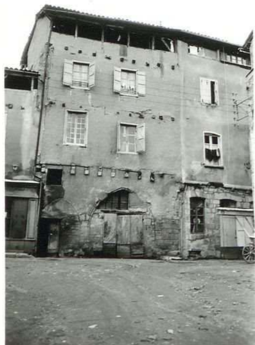
12.757 Maison Lasfargues 22, rue E. Zola
