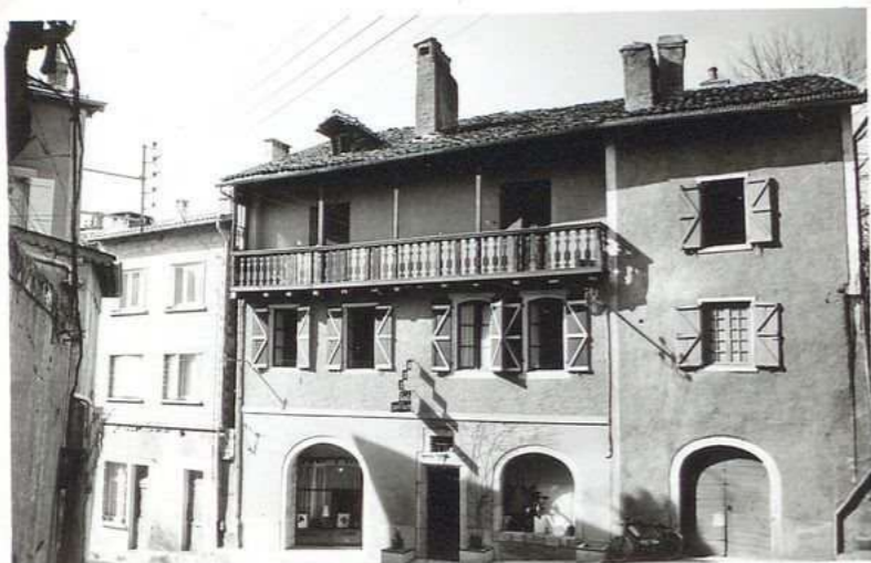
12.822 Immeuble Imit-Jary 41, Rue de Colomb
