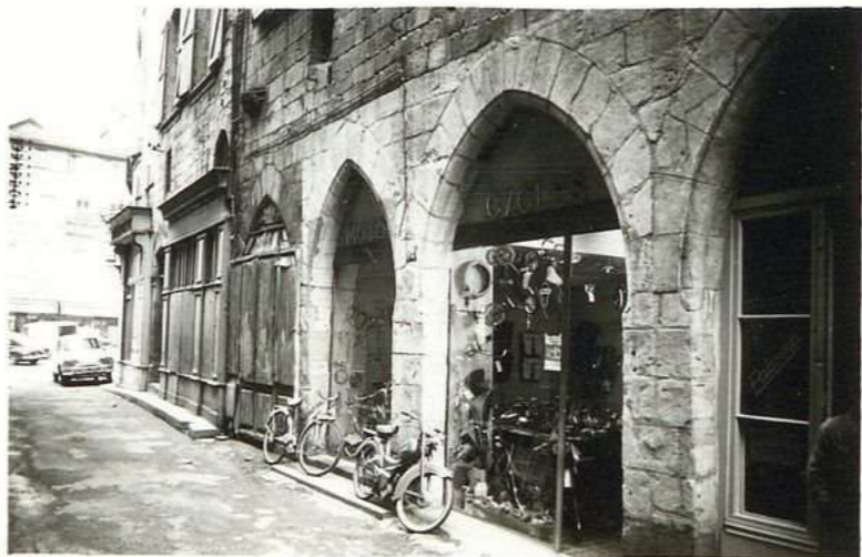
12.758 Maison Acstruit 52, Rue E. Zola
