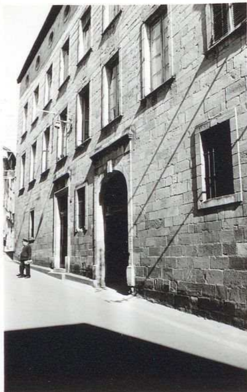
12.823 Immeuble Solery 20, Rue de Colomb
