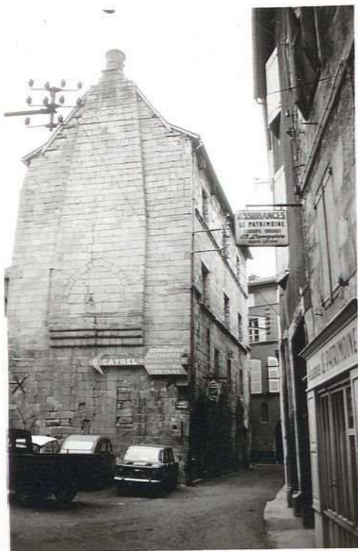
Hôtel Decant de Sorinac 12.558 2, rue Clermont
