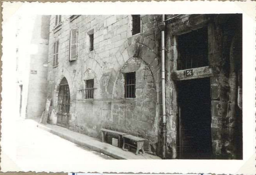
12.762 38, rue E. Zola Maison Boquet
