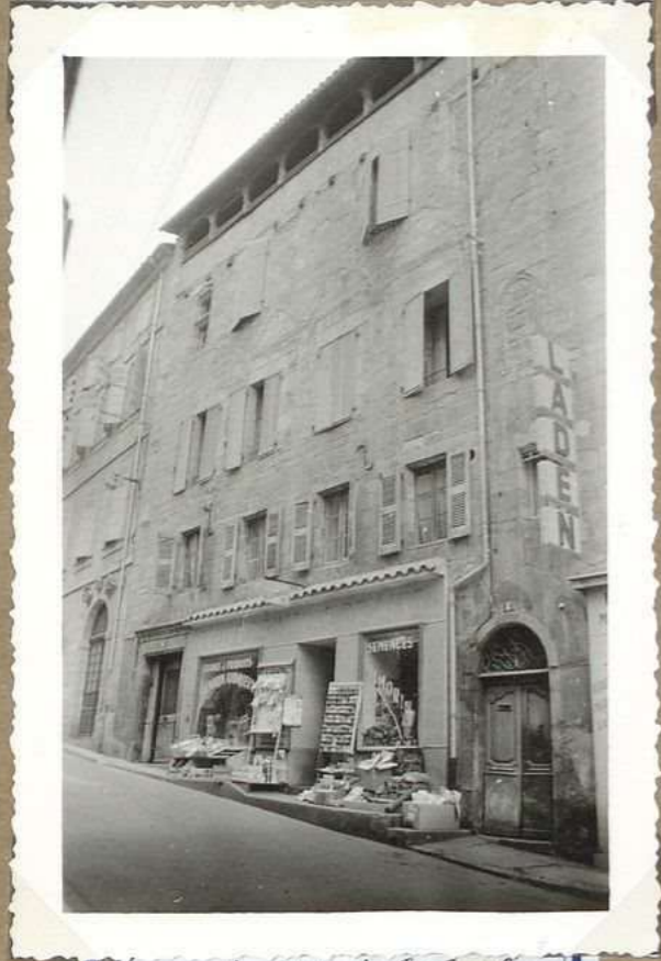
12.811 6, rue de Colomb Maison Baubil
