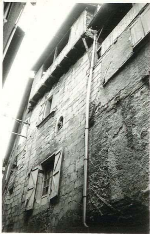
12.740 Immeuble Mir 3, rue Bonhore
