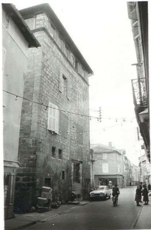
12.705 Immeuble B, N.C.I 23, rue d'Arçon
