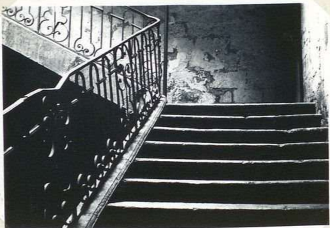
1415. Escalier: hôtel Séguier
