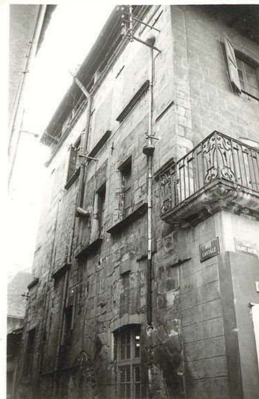
12.729 Immeuble Richard rue Caviale et 7, place Barthol
