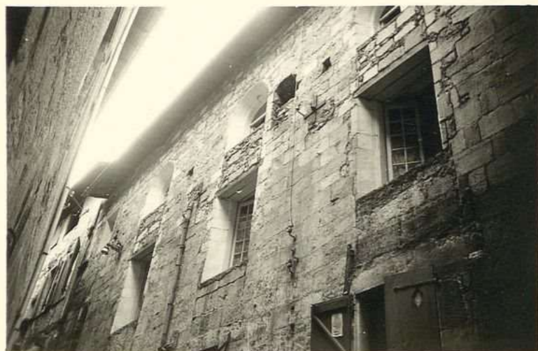
12.643 Immeuble Hauticlet chapelle des Béatitudes rue de la Courneillette
