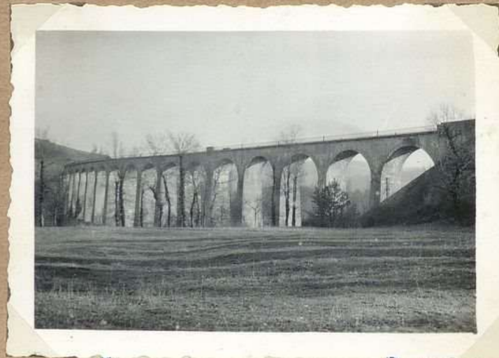
1394. Viaduc de Drauzou
