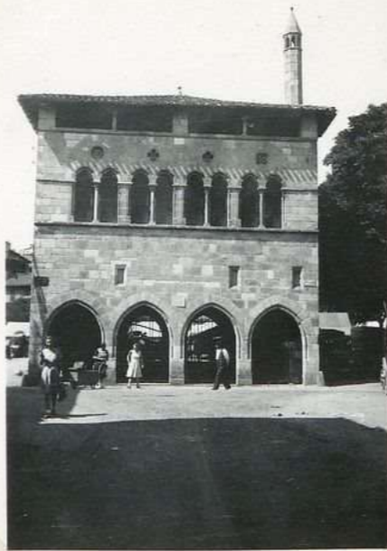
1404 Hôtel de la Monnaie façade sud : 1 cl.
