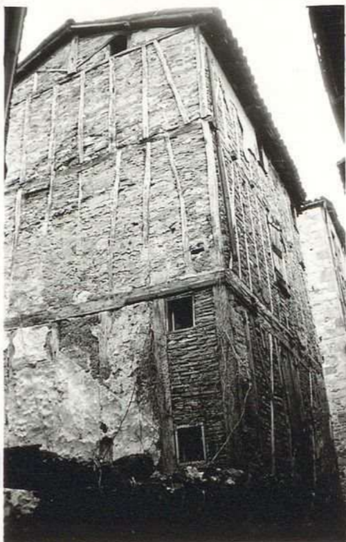
6, rue des Marquilliers 12.731 Maison Fenouil
