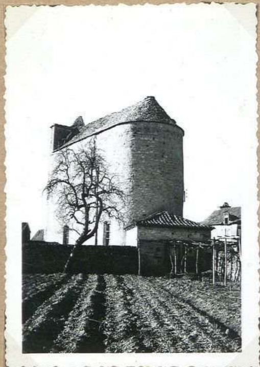
3570 Eglise de S t Caprais vue d'ensemble est
