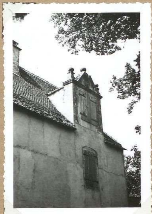
5236. Ch teau de Laboissière Lucarne, côté sud
