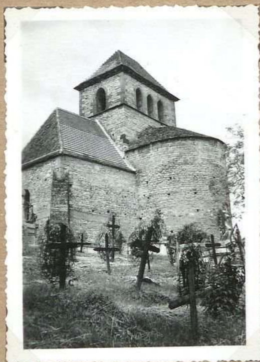
2799. Eglise de Montclera S.E
