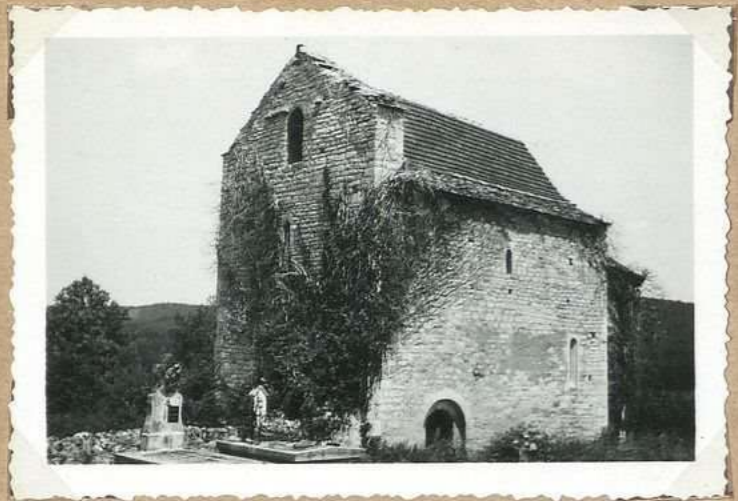
5158 - Eglise S t Andre, vue S.O.
