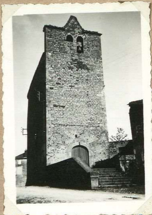
3566 Eglise de S t Caprais 3572 façade
