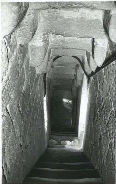
5-4/53. Eglise de Marminiac 5212 Escalier du clocher
