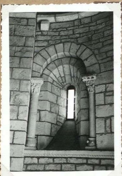
5242. Eglise de Frayssinet ancien chœur, fenêtre côté épître
