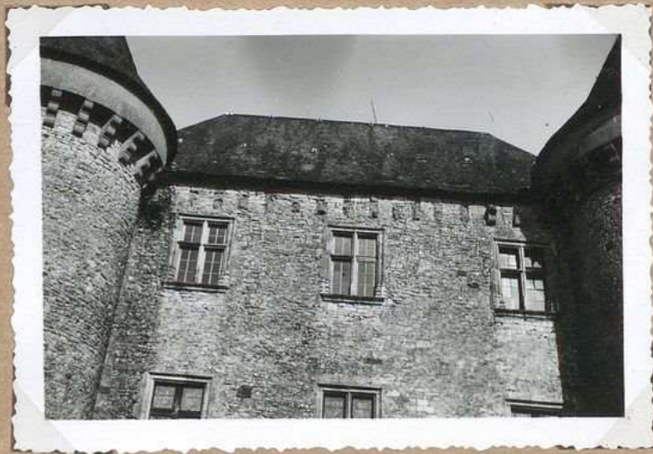
5171 Ch teau de Montclera Fenêtres de la façade
