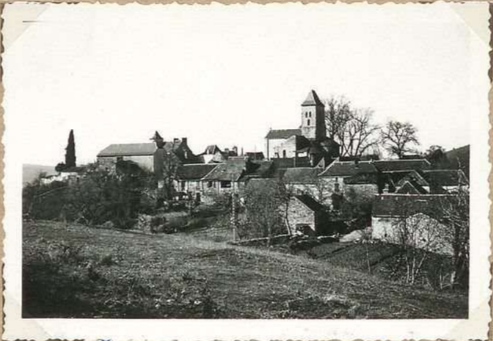
93 Les Arques, vue générale
