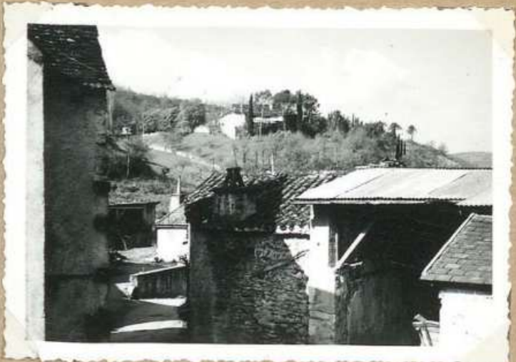
7213 Ch eaux de Marqueayrols. Vue de la partie supérieure du village.
