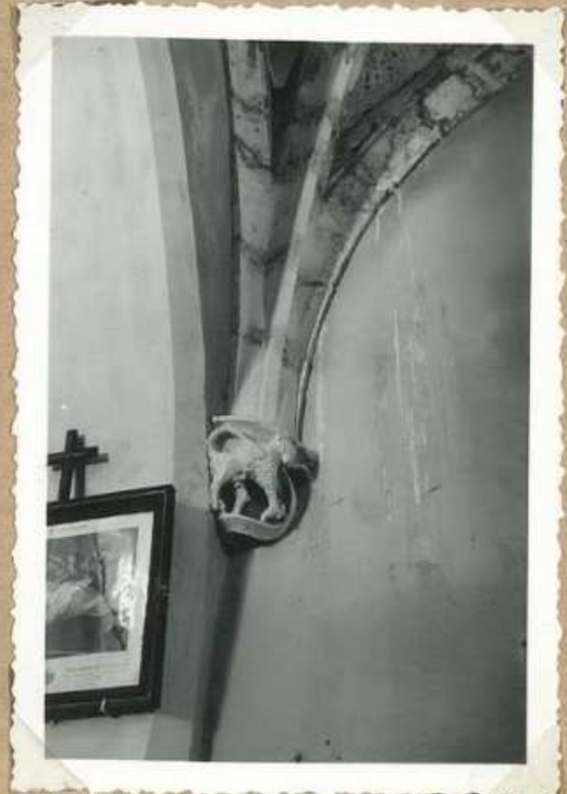
5647. Eglise de Brouelles cul. de lampe
