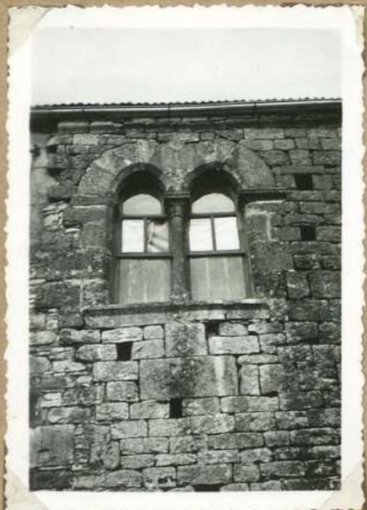
3025. Mon ancienne fenêtrage
