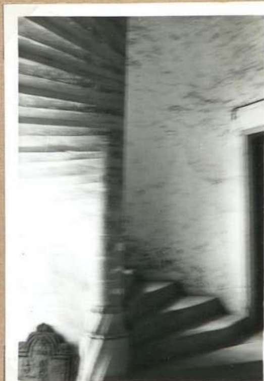
7047 Ch teau de Calamane Départ escalier à vis
