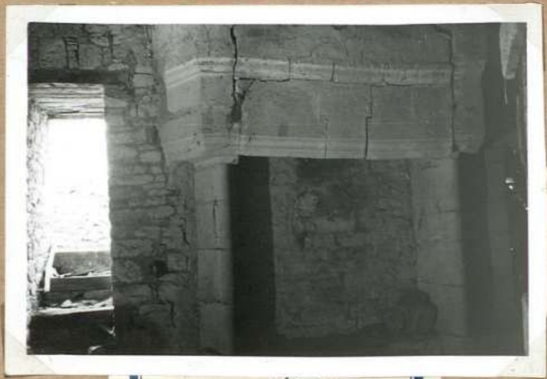
34-6-53-5625 Ch teau de Labastidette H le Cheminée de la tour 2 e étage
