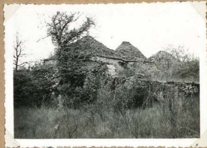
7071 Gaiottes jumelées route de Montgermy.
