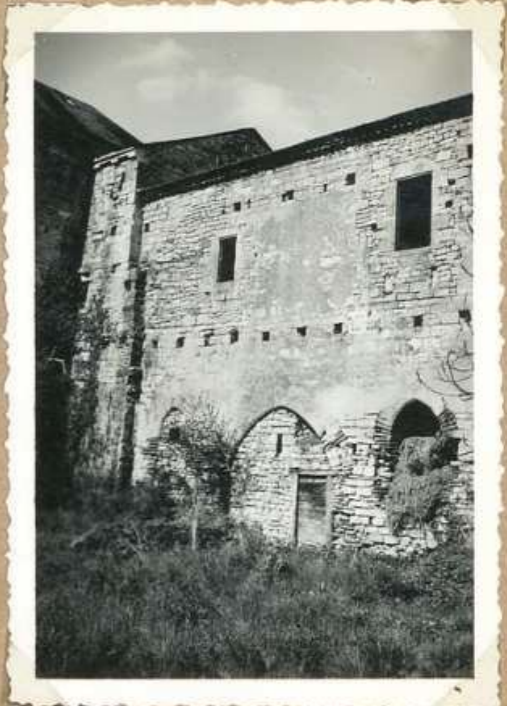
7169 Immeuble Saxe de vie Façade ouest
