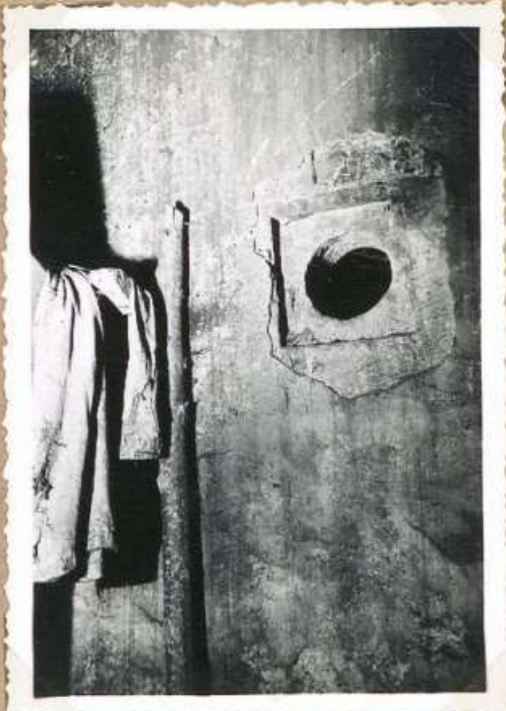
7031. Tour de l'ancien ch eau Vue int ! d'une meubrière
