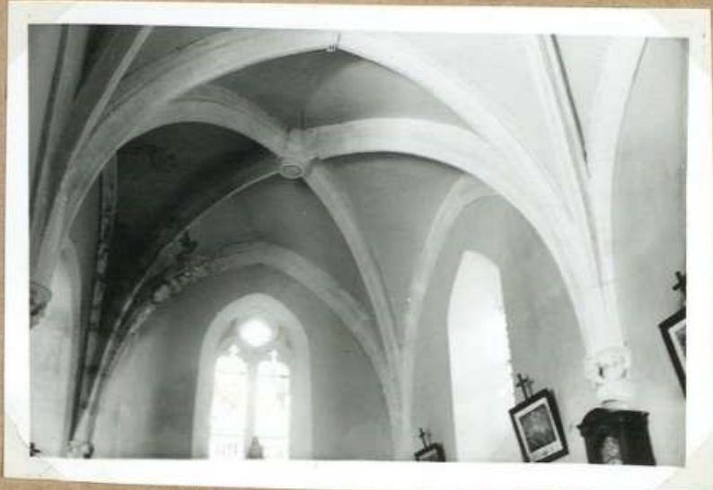
7224 Eglise de Broualles 2-7/54 voûte des chapelles
