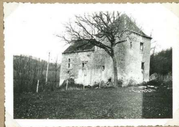
3744. Château du Lit 2 e
