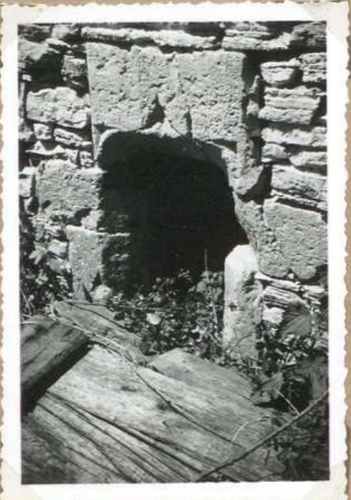
7281 Ch ateau du Pit. Petite baie accolade E
