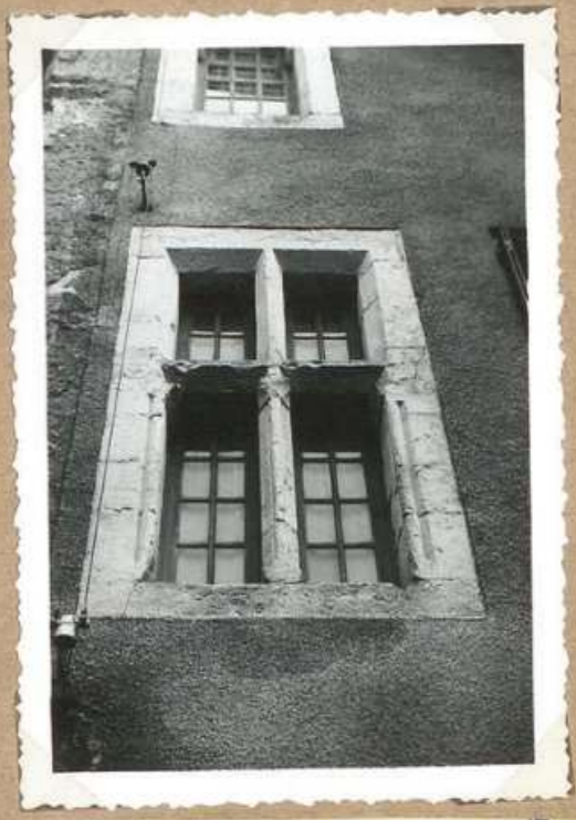
7058. Maison Lafou Fenêtre Renaissance à croisée de pierre
