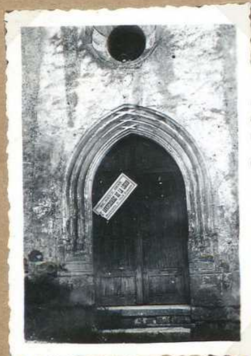
347 Portail sud de l'église
