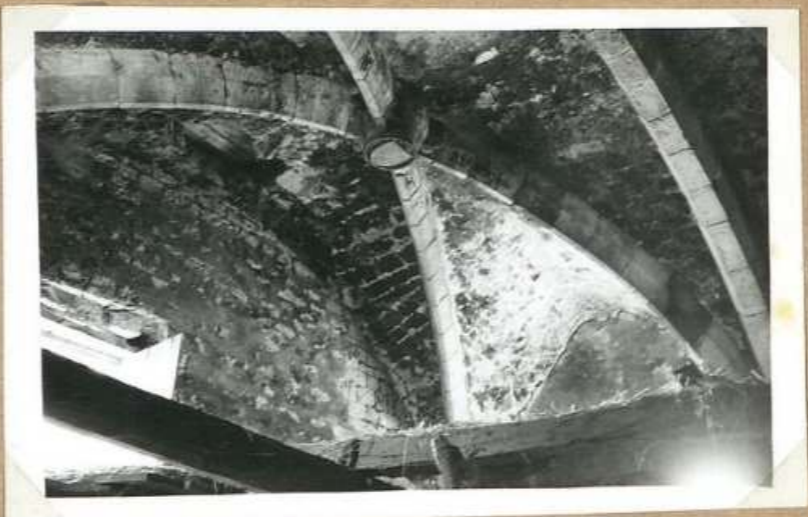
26-7/54 Immeuble Saxe de vie 7168 Voûte d'ogives
