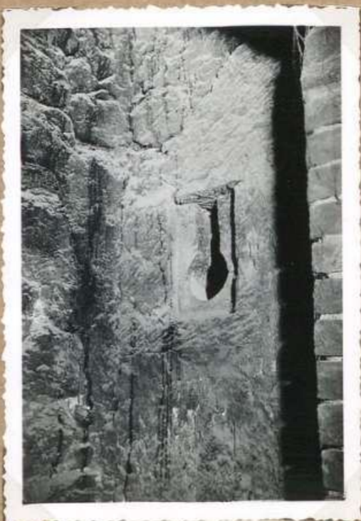
7032. Tour de l'ancien ch eau - Vue int ! d'une meubrière
