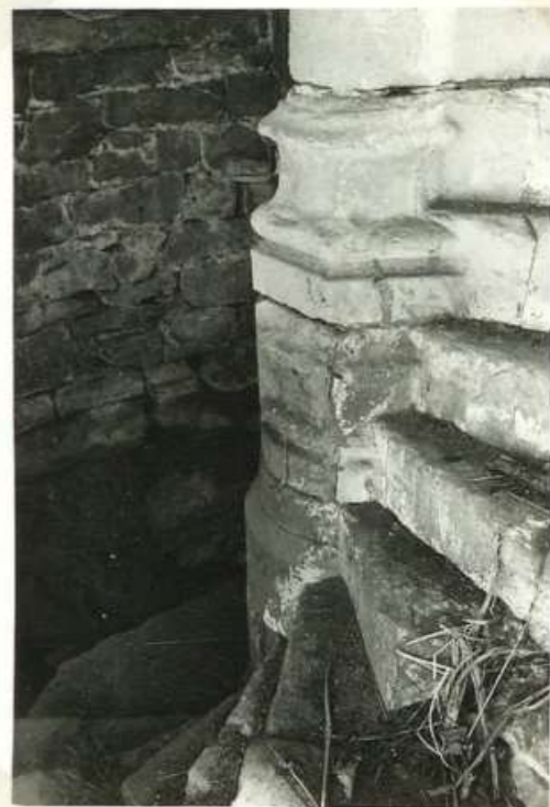
7233. Château de Lafaurie 14-754 Départ de l'escalier à vis
