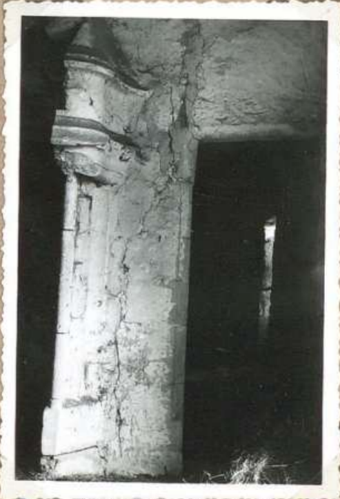
7282 M aison Raynal à Greston Pied droit cheminée
