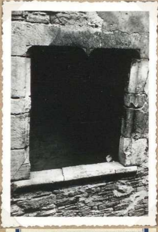
7060. Ancienne maladrerie de Catus. Fenêtre, façade S
