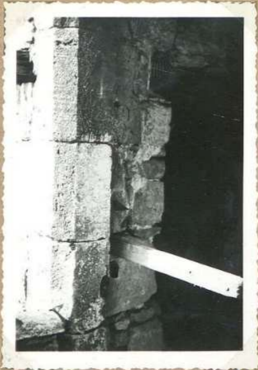
7205 Maison Mousset (vieille) Ancien système de fermeture de porte
