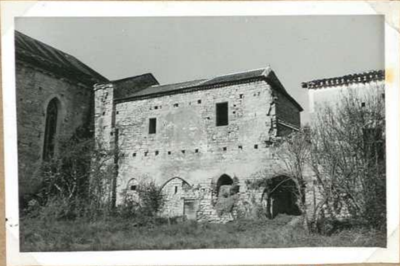
7171. Immeuble Saxe de vie façade ouest
