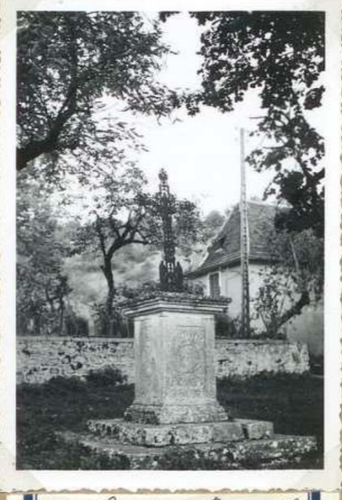
5640 Croix de Brouelles Vue d'ensemble N.O
