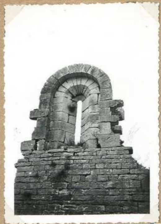
7068 Ruines de St. Martin de Grandene - Fenetre romain S.
