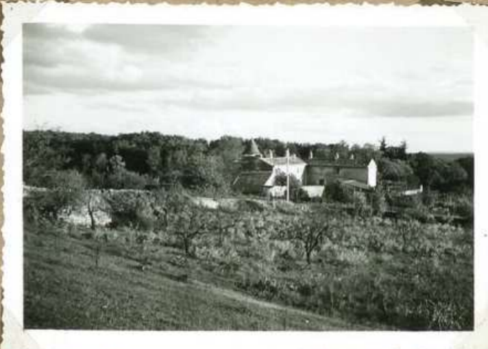
5682 Sabastidette Base vue d'ensemble N.O.
