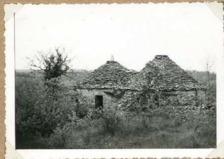
7070. Gaiottes jumelées, route de Montgermy.
