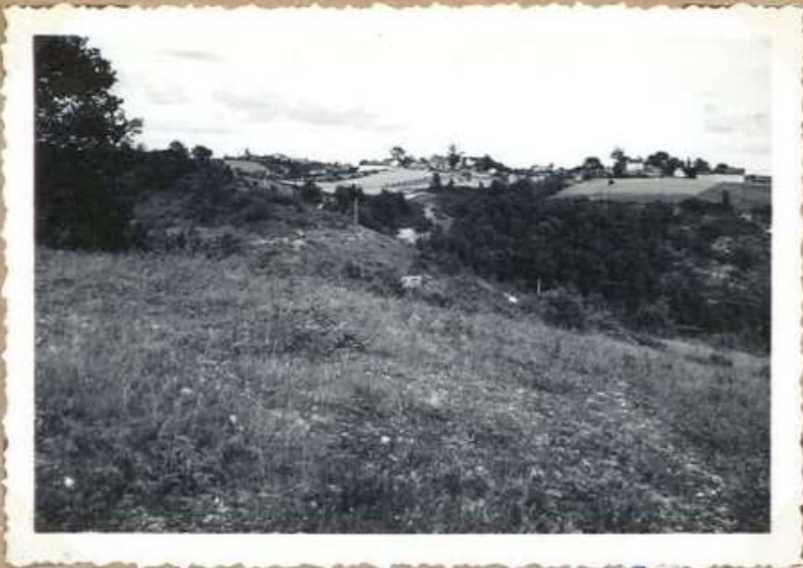
1557. Vue générale N.O.
