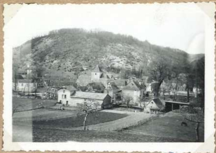
1614. Vue générale S
