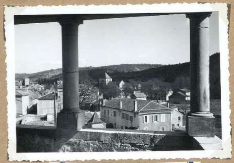
9021. Vue générale - côté ouest.
