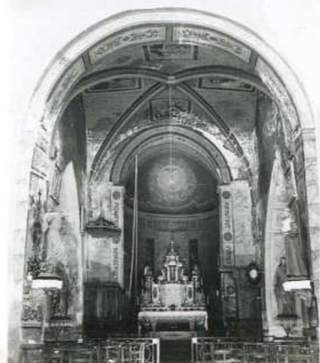
7257 Eglise: intérieur Vue d'ensemble.
