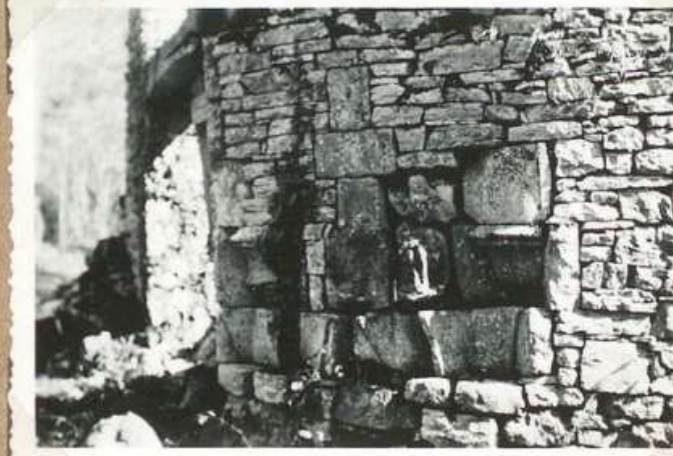
5596. Vestiges église de Vayres
