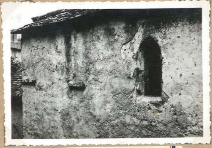
7059. Ancienne maladrerie de Catus. Bâti en arc brisé
