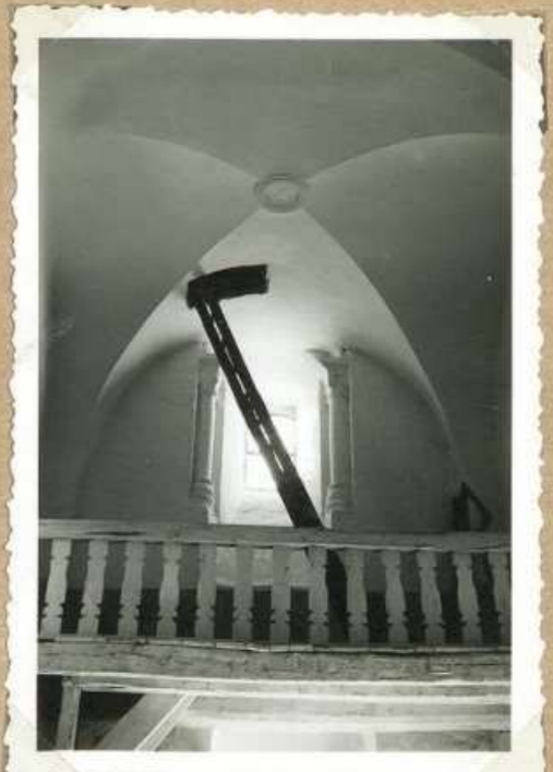
5644. Eglise de Brouelles deux colonnettes romanes
