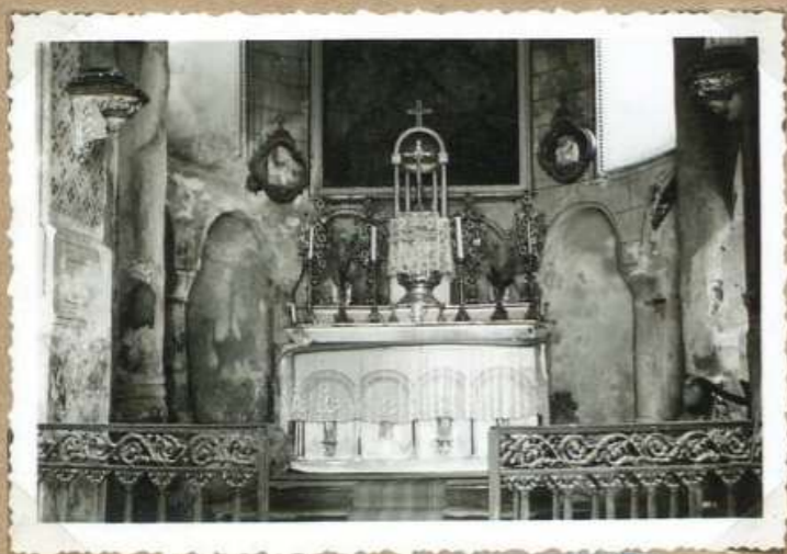
5636 Eglise de Maxou - Détails des arcatures du chœur
