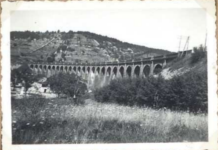
674 Viaduc de Calamane
