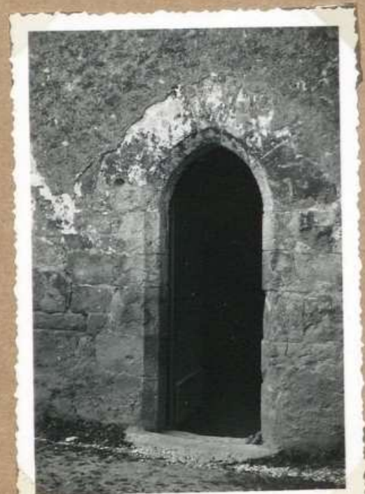
7136 L'église Porte latérale
