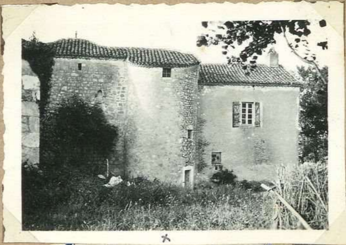
4459 - Ch eau de St Privat N.
