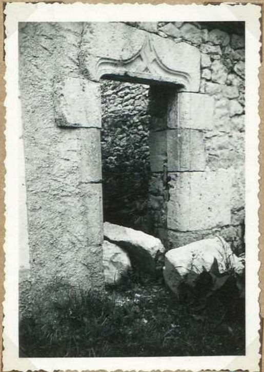
4407 Linteau de porte maison Rue Bessou
