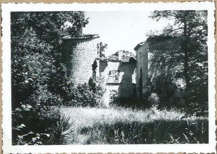
4439 Ch teau de Bateng facade ouest 1952
