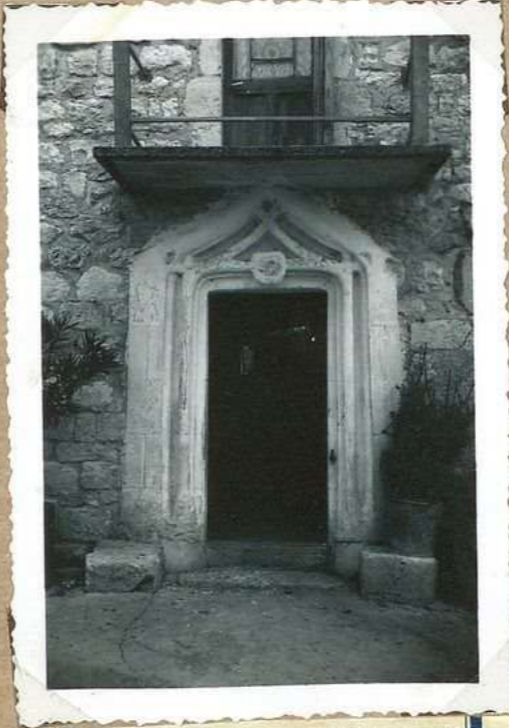
4494 Porte du ch eau de Velas
