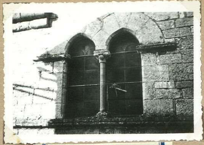
915. Fenêtres du ch eau
