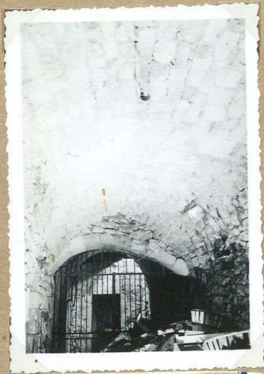
4418. Voûte souterraine dite "chemin de ronde"
