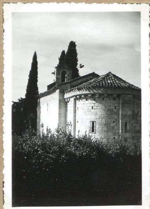
950 Eglise de Russac abside
