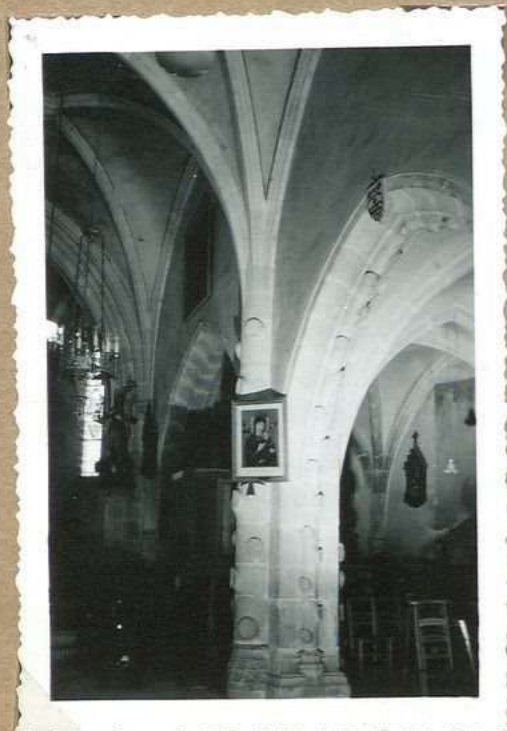
4448. Eglise de Cezac pilier et 9 e arcad
