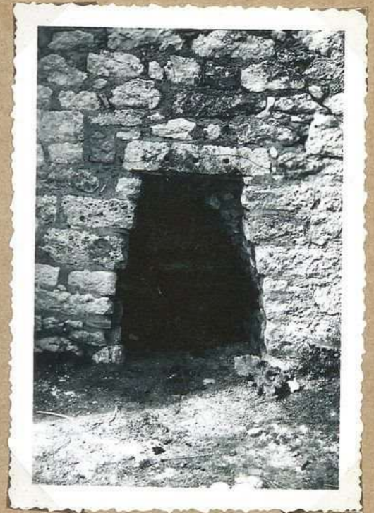
4502 Entrée souterrain de Labouffie
