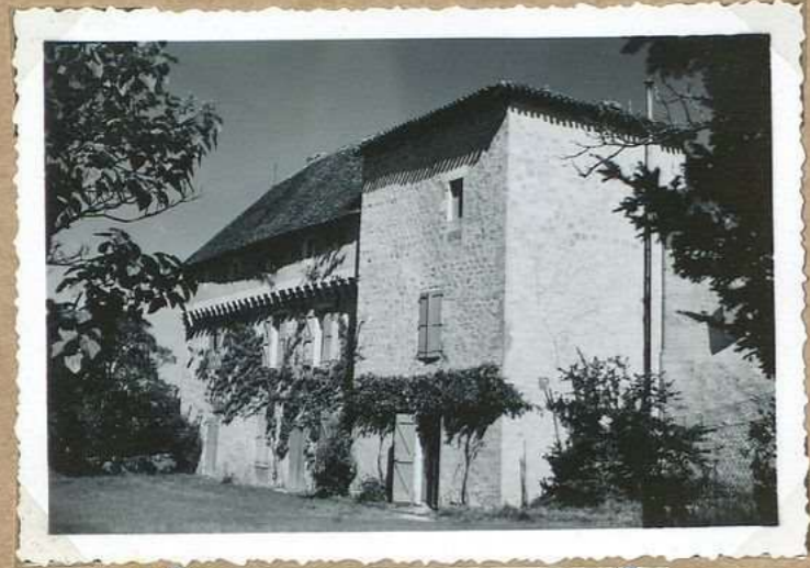
4518 Ch teau de Boisse facade sud
