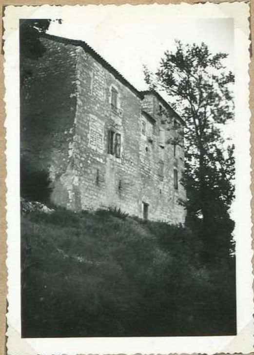
4456 Ch eau de St Privat façade nord
