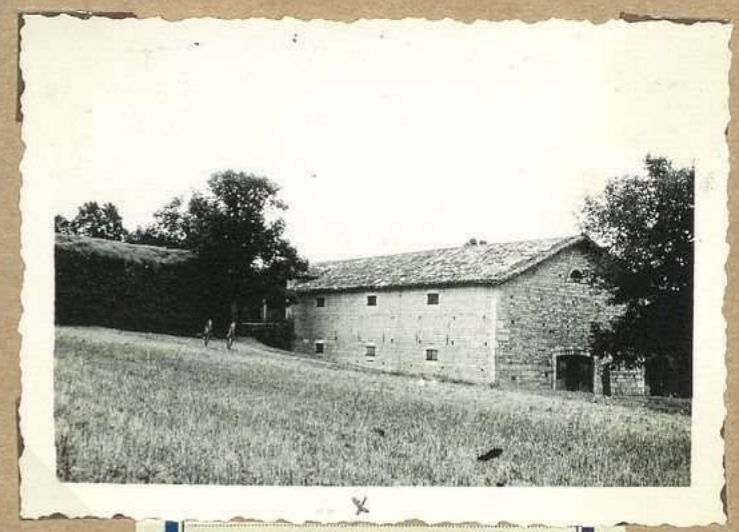
5081. Ch eau de Boyer: la grange
