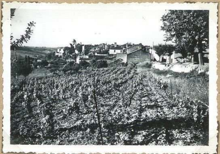
1447 Vue générale E. de la Route de Cahors
