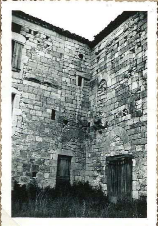
4465. Le château (vue de l'extérieur)
