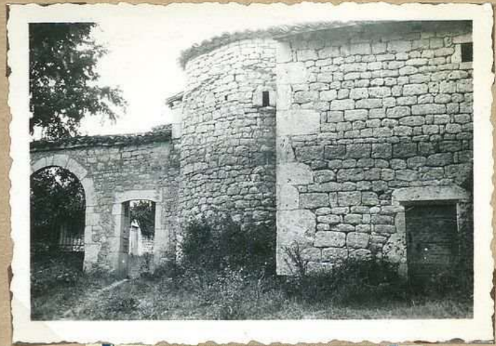
1046. Ch eau de Régagnac entrée est.
