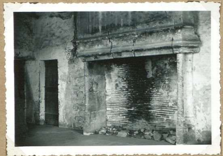
4431. Ch eau de St Anthet - cheminée 1 er étage
