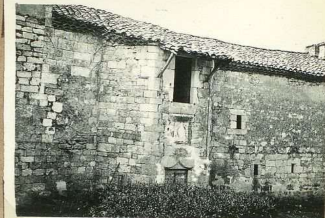
5082. Ch âteau de Montcaigu (façade nord)
