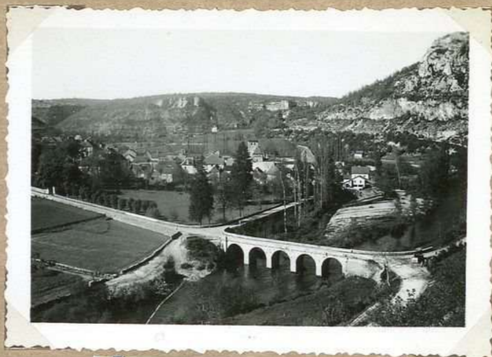
2546. Vue générale et pont sur la Cèze.
