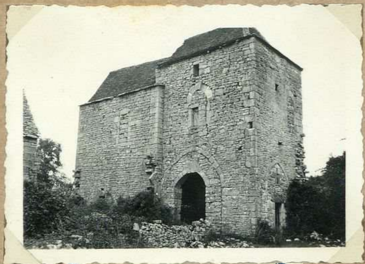
3632 Anciennes constructions E de St Berault
