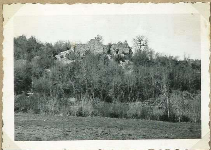
3812. Ruines de Lantouey (vue d'ensemble)
