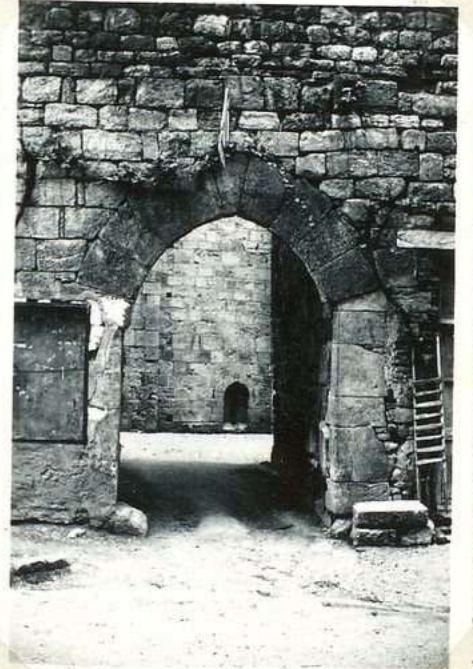
2530 Porte des remparts S
