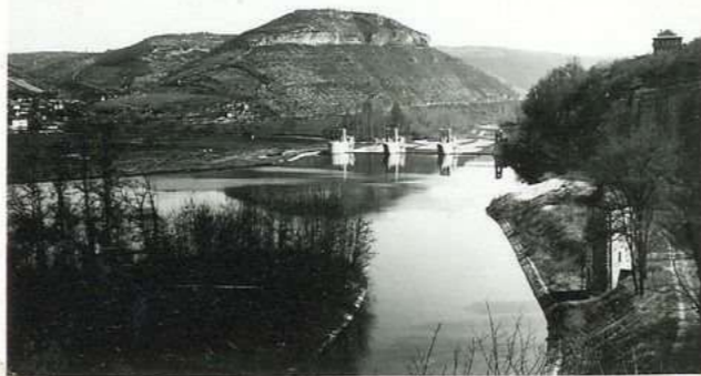
660 Barrage sur le Lot et rue Waiïfier
