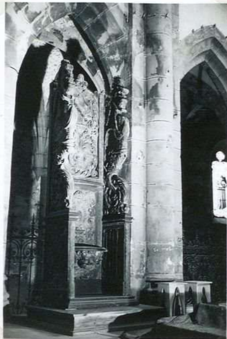
4395. La stalle du chœur Église de Marcilhac
