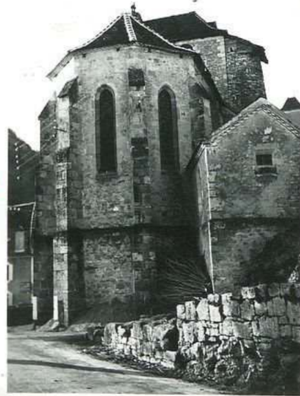
2177 - Eglise de Larnagol (abside)
