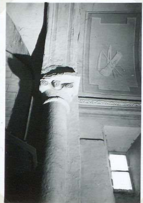
7024 Eglise: Col. de chap. au chœur évangél.
