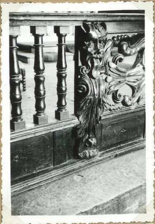
8074 Eglise de Mercues Appui de communion détail
