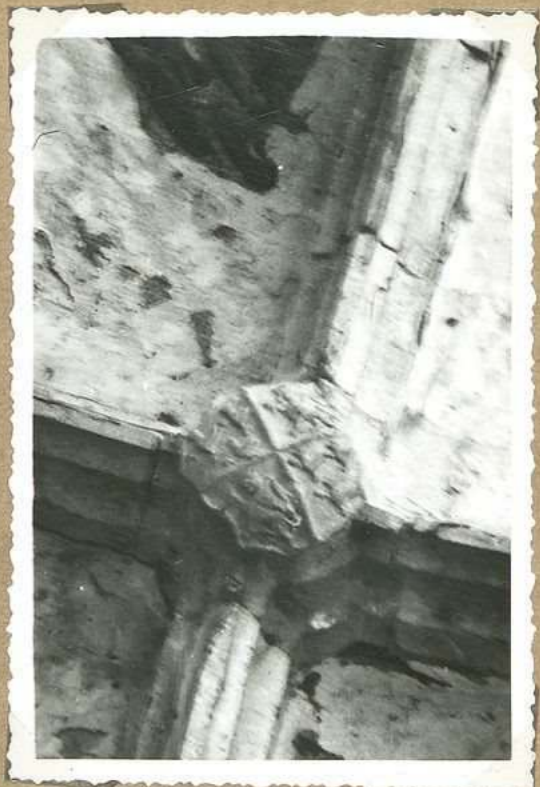
13-1/54. Eglise du cimetière 8063 Clef de voûte - tele
