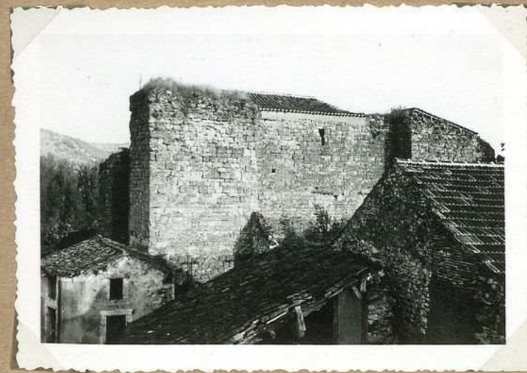
8107 La "tour" de Pradines Fusée de Pradines
