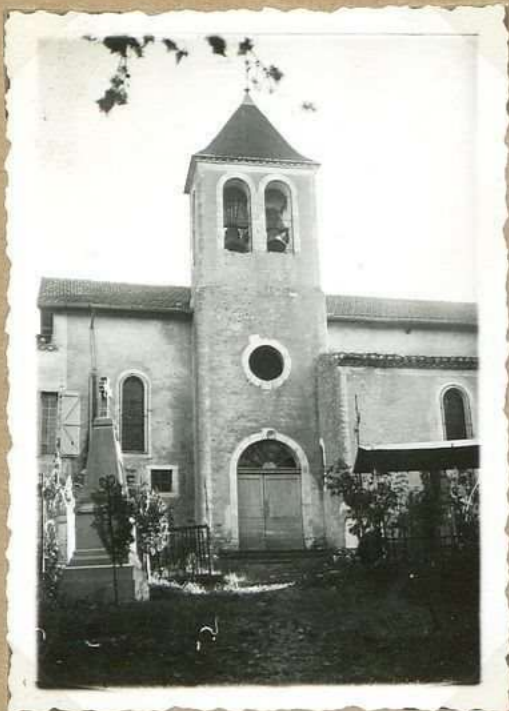
2107 Eglise de Lamagdelainé
