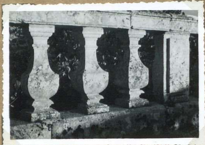
8082. Château de Mercues détail balustrade E
