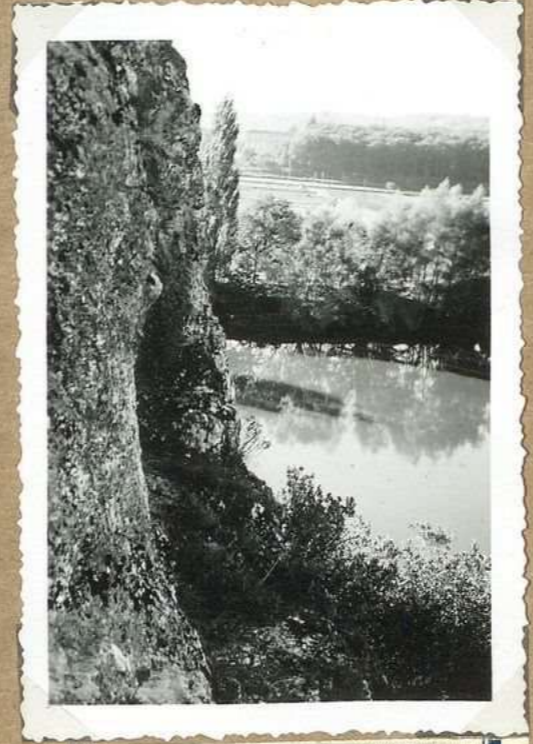
8048 Tour de péage Niche des Vieilleux
