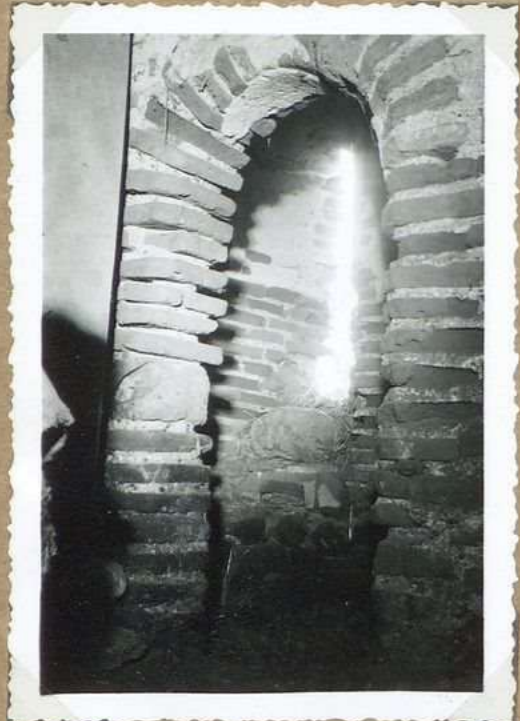
8038 Ch eau de Reganhae Re dilet bastion
