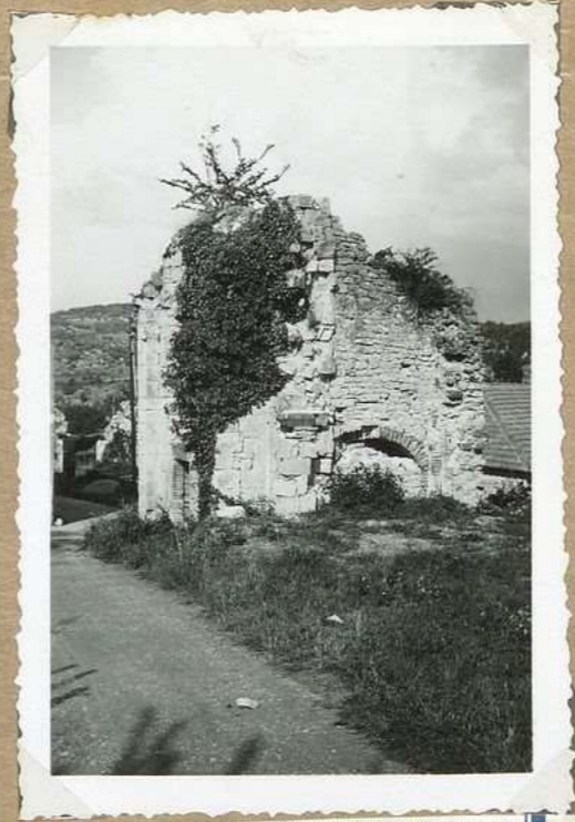
9059 - Vestige ancienne eglise. O.
