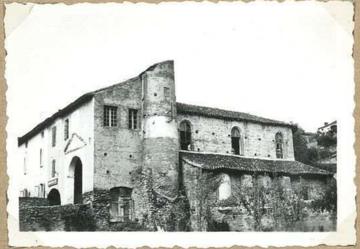
5977. Anc ve église des Recollets (vue de l'est)
