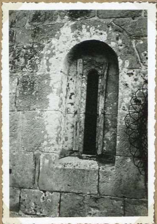
8114 Eglise: Fenêtre romane de l'abside
