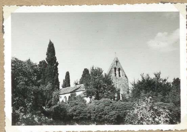
8087 Eglise: Vue d'ensemble S.E.
