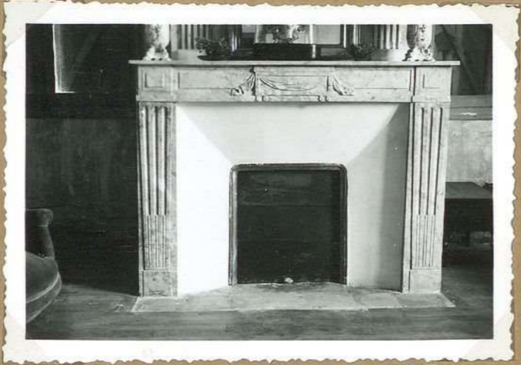
9199. Ancien ch eau des Evêques cheminée marbre blanc
