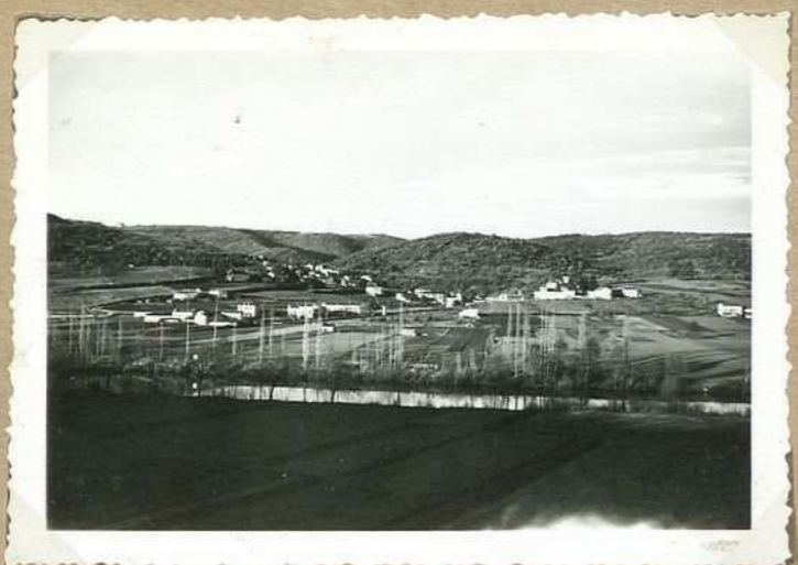
2101 Vue générale (r.g. du Lot)
