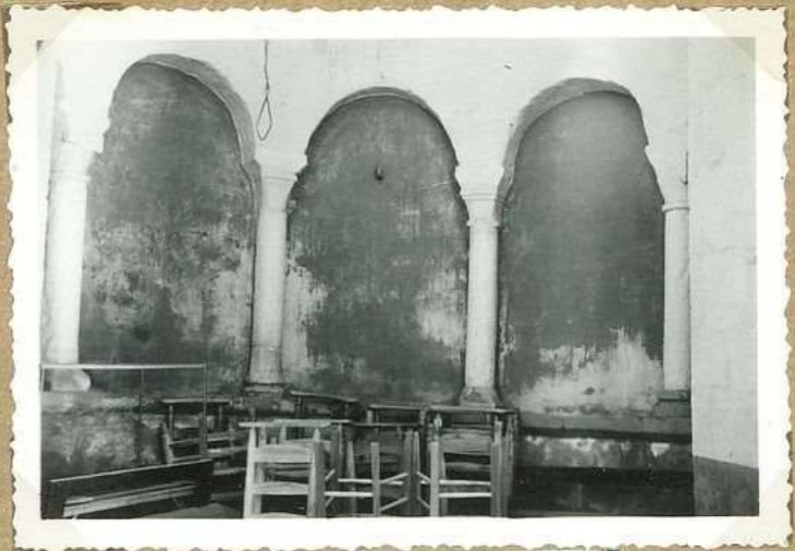
8072 Eglise: arcatures de l'ancien chœur.
