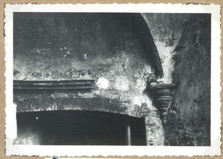
8057. Ancien monastère des Recollets: Cheminée de la cuisine (partie droite)
