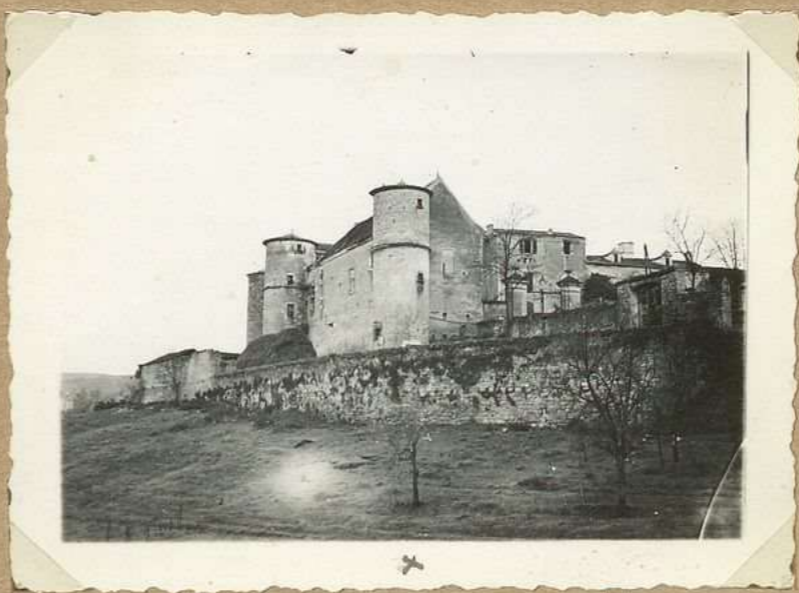
81 Ch eau d'Arcambal N.O
