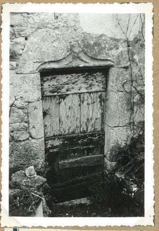
9114 M ors Vignati à Salgues Porte avec linteau accolé
