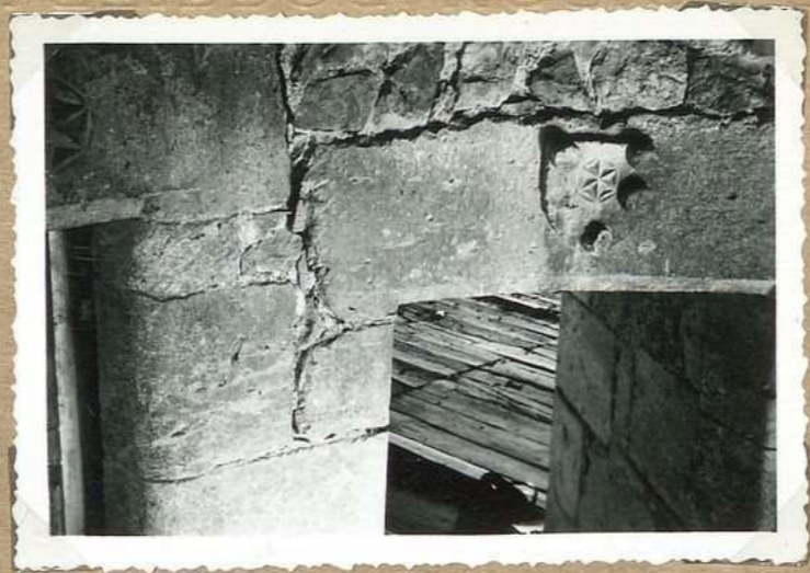
9092. Ch teau de Labastide M. 2 étages de portes d'escalier
