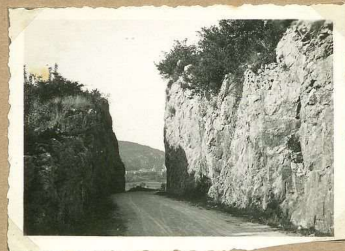
85. Route pittoresque Arcambal-Béarn
