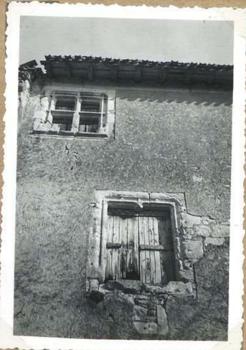
9090 Ch eau de Labastide M. Façade N.O. 2 fenêtres XV e
