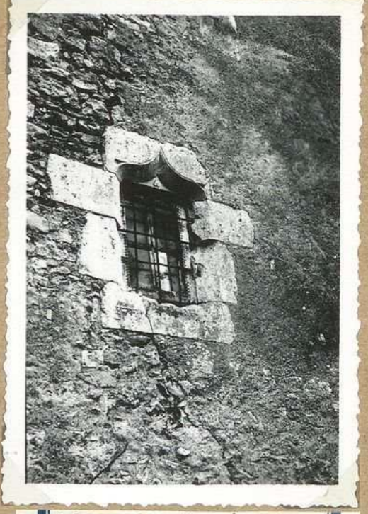
8866. Presbytère Fenêtre accolade façade W
