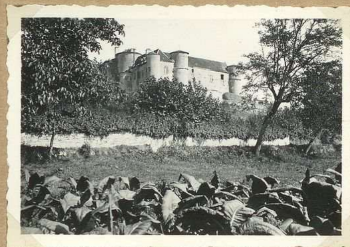
82. Ch eau d'Arcambal N.O
