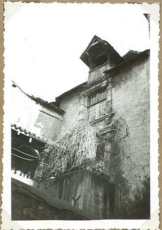
8372. 8 Rue St-Andre. Fenêtre 2 e ét. et lucarne XV e s. Vues de la cour de la G.R. St-And.
