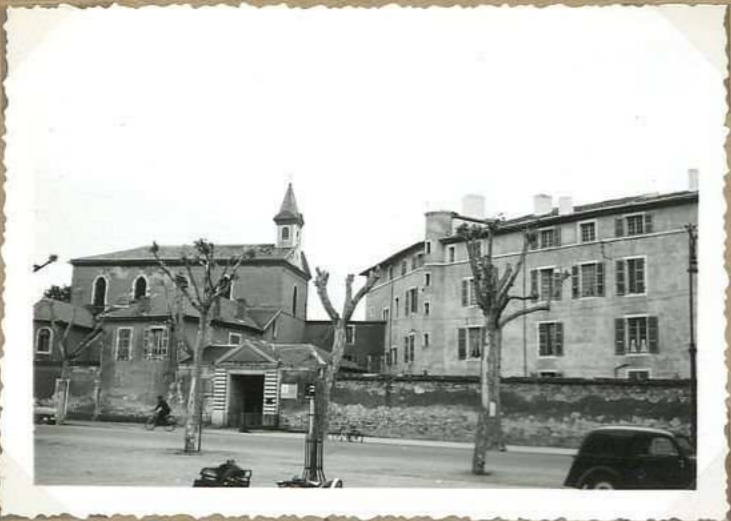
8515. 15 B e Gambetta Ancien couvent des Mirepoises. Vue de la place Thiers
