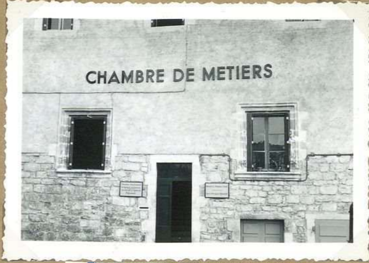
8447. Collège Séleigny Fenêtres sur façade est
