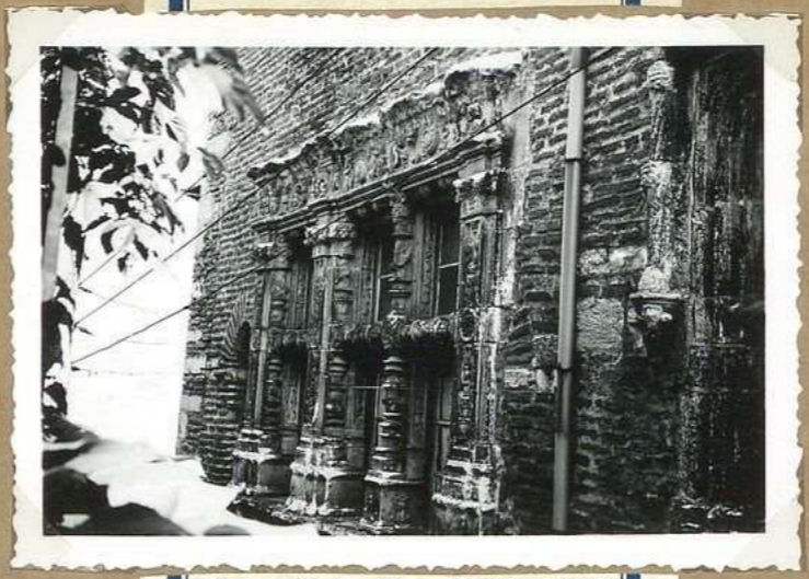
8629 - 8-10 - Rue Bergougnon Fenêtre Renaissance
