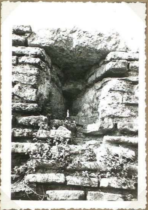
8599. Rue du Lot Restes des remparts: une meurtrière
