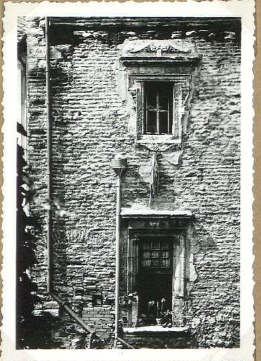
8623. 8-10. Rue Bergougnon Deux fenêtrées - sur cour, sud
