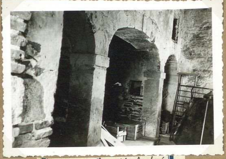
8373. 8. Rue St-Andre 3 arcades: chemise arcade centrale
