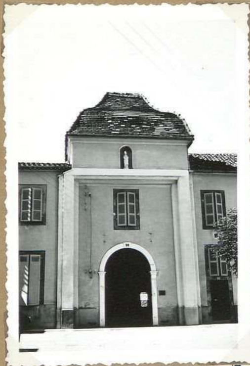
8613. 3 Place de la Verrerie Partie ouest de l'Arc: façade
