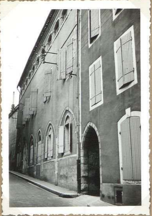
8472. 1. Rue du Chateau du Roi. Facade ouest
