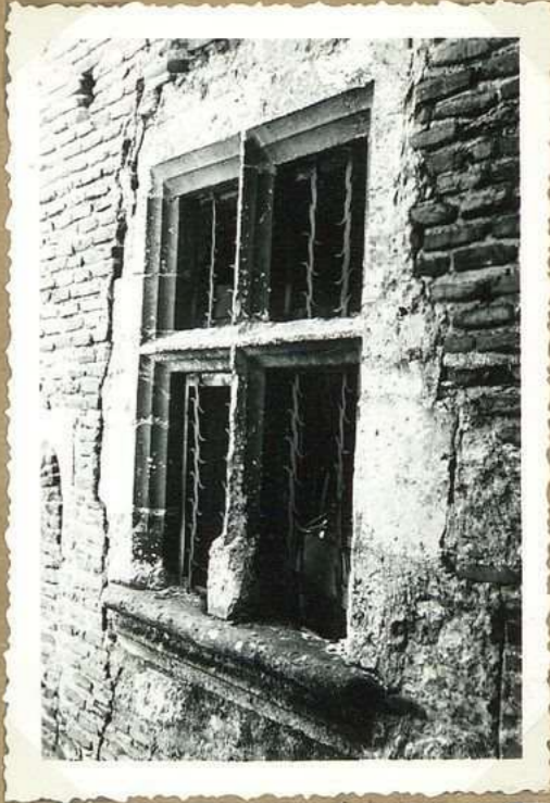
8448 Collège Séleigny Cour d'entrée: fenêtre du 2 e étage
