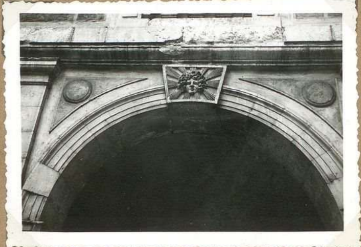
8685. Prefecture Pontet: détail clef de voûte
