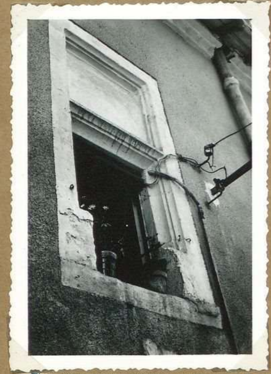
8433. 2 Impasse Séguier Fenêtre à travers pierre
