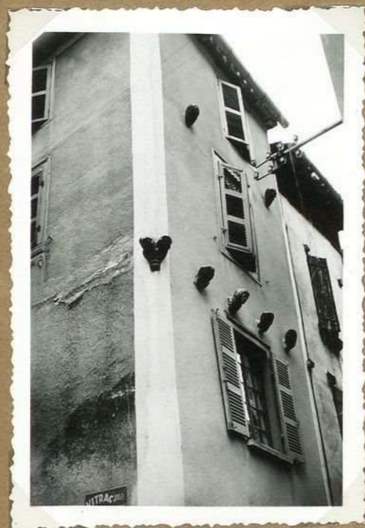
8641 Angle Rue St Pierre et Rue St. Andre Abords de fenêtres
