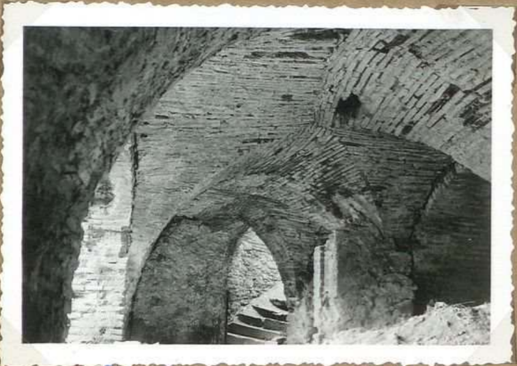
8542. 1 et 5. Surpass de la Citadelle. Vue des voûtes (O)
