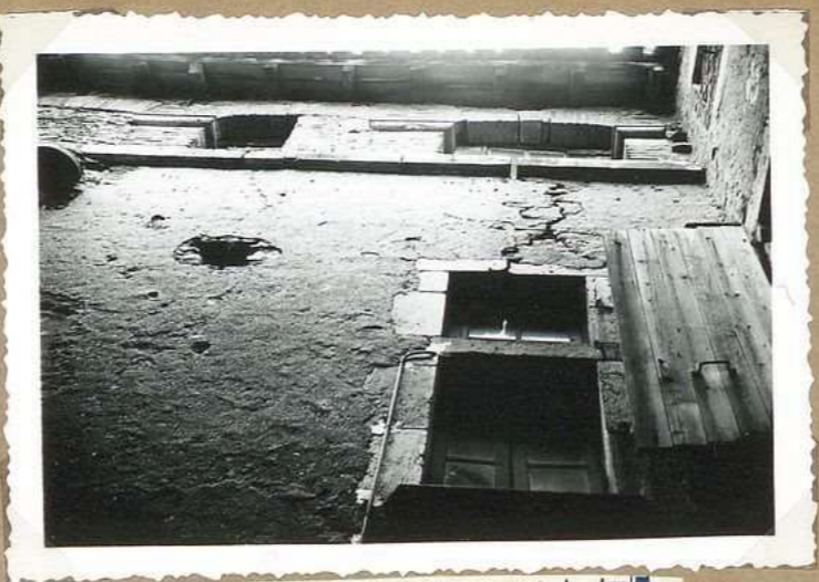
8551. 12. Rue St Barthélémy Fenêtre à croisée de pierre et mirandes.
