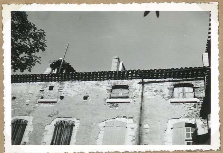
8458. 9. Rue Portail Alban Partie facade ouest
