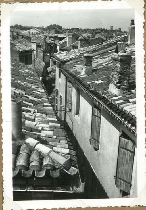
10.169 Vieux Cahors Rue Helmand
