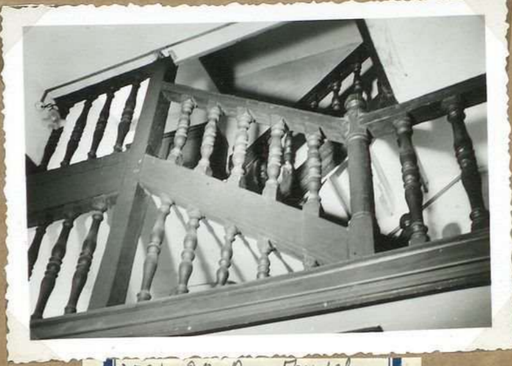
8521. 20. Rue Feydel escalier. partie en bois
