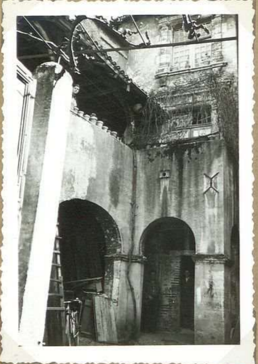
8369. 8. Rue St-Andre Vue d'ensemble, facade ext e
