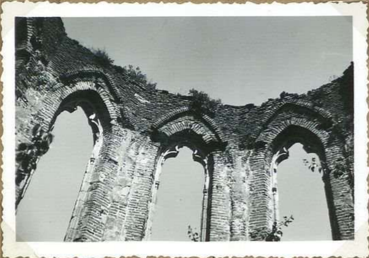
8611- Ruines de l'église des Dominicains - Detail des fenêtres
