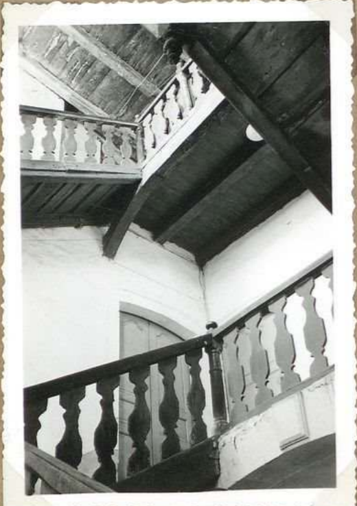
8460. 9. Rue Portail Alban Escalier - Balustrades bois à partir du 1 er étage
