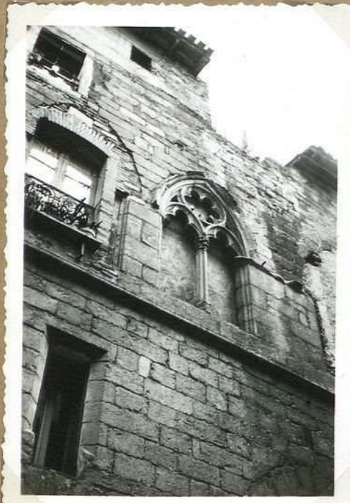
8503. 28. Rue des Saubiroises Fenêtre gothique XIII e s.
