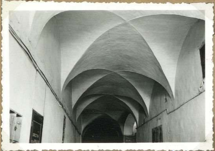
8579 Ancien immeuble des Lazaristes (caserne) Voûtes d'arêtes.
