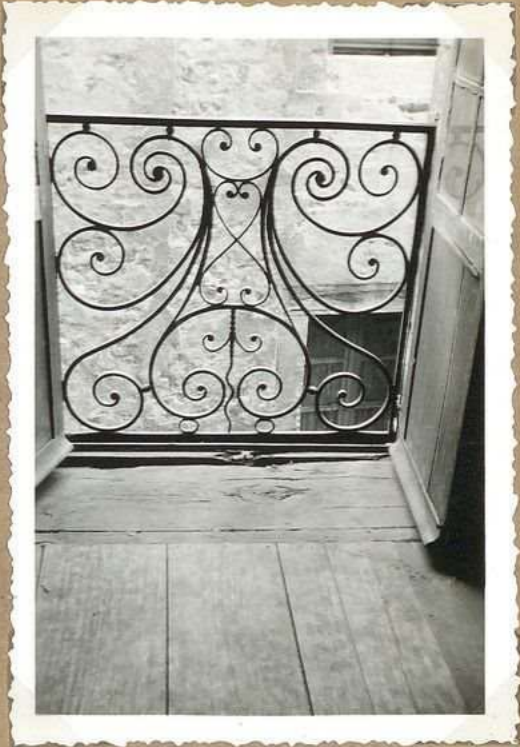
8459. 9. Rue du Portail Alban. Appui fenêtre escalier
