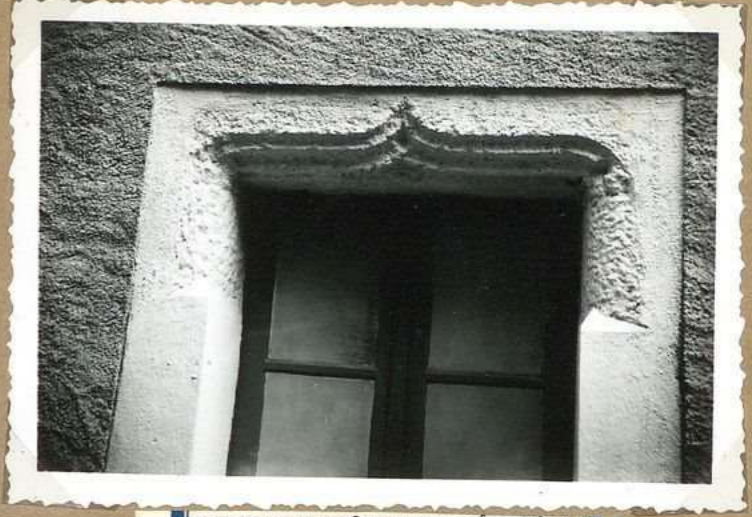
8496. 17. Rue des Soubiros Cour d'entrée. Niveau linteau en accolade
