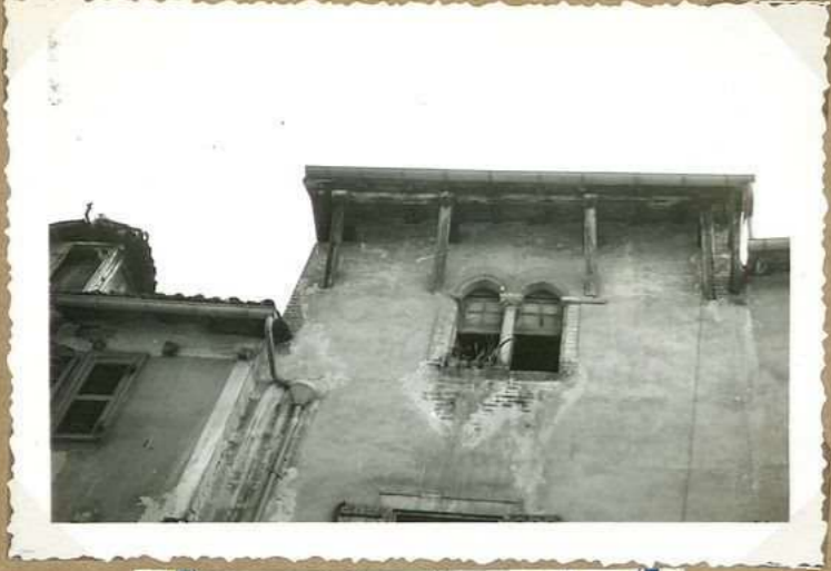
8405. 8 Rue Daurade Fenêtre gémme 3 e étage
