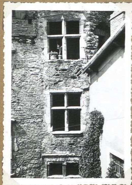
8626. 3 fenêtrées à croisée de pierre, sur cour, S. 8-10. Rue Bergougnon
