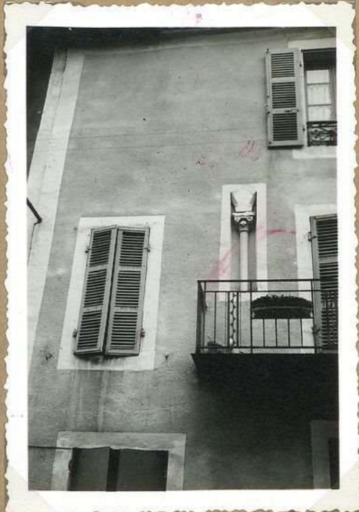
8523. 20 bis. Rue Feydel. Colonnelle et chapeau en cast. fer (1 er étage)
