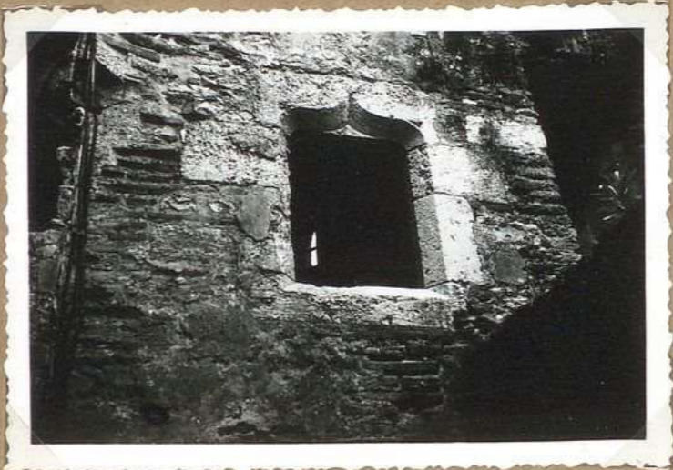
3492. 12 Rue Cheau du Roi Fenêtre avec linteau accolé
