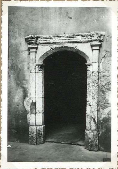
8624 8-10. Rue Bergougnon Cour int re - porte d'escalier
