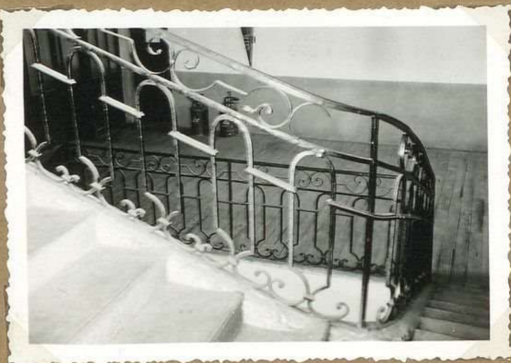
8581 Ancien immeuble de Lazaristes (caserne) Detail peronneuse escalier 2 e étage
