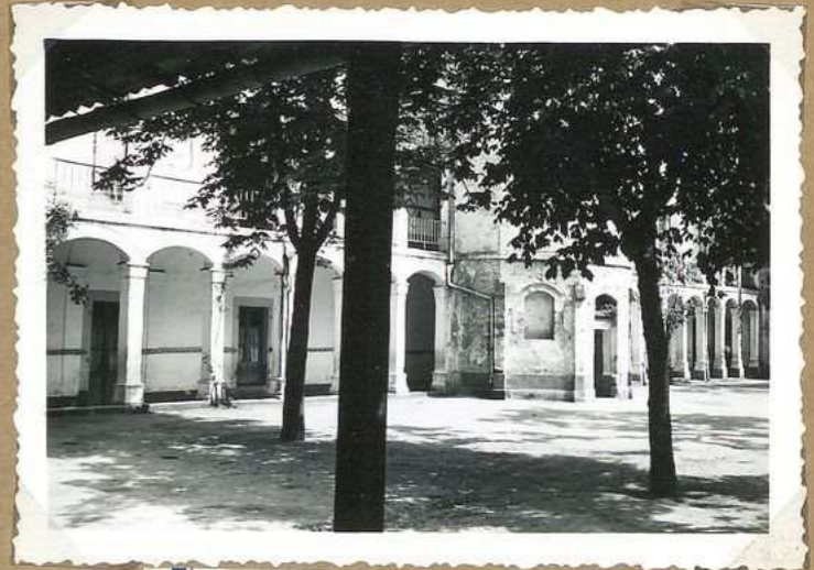
8699. Ecole de filles, Rue Wilson - Peristyle, vue des
