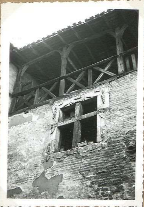
8463. 11. Rue des Trois Baudouin. Façade S. (cours) fenêtre
