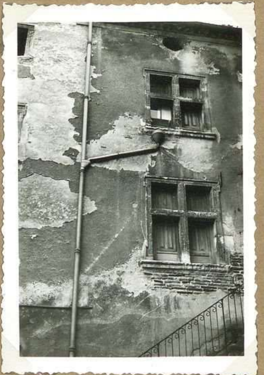
8377. G. Rue St Andre Deux fenetres a croisee de pierre sur corn. XVII e s.
