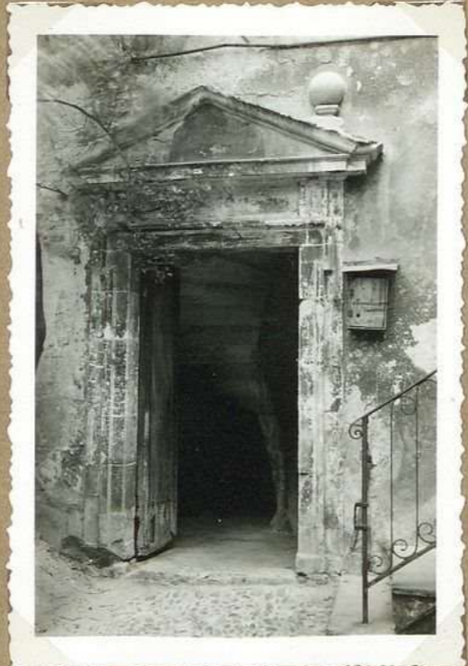
8376. G. Rue St Andre Porte d'escalier
