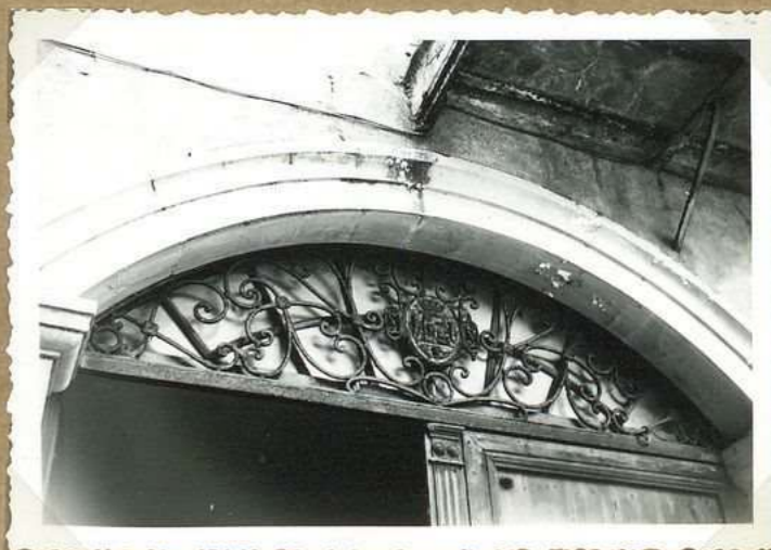
8429. 3 Place de la Libération. Imposte et ferronnerie de portail d'entrée
