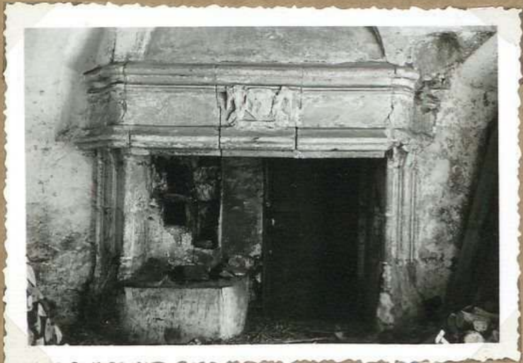
8532. Ancien couvent des Mirepoises - Cheminée XVIII e
