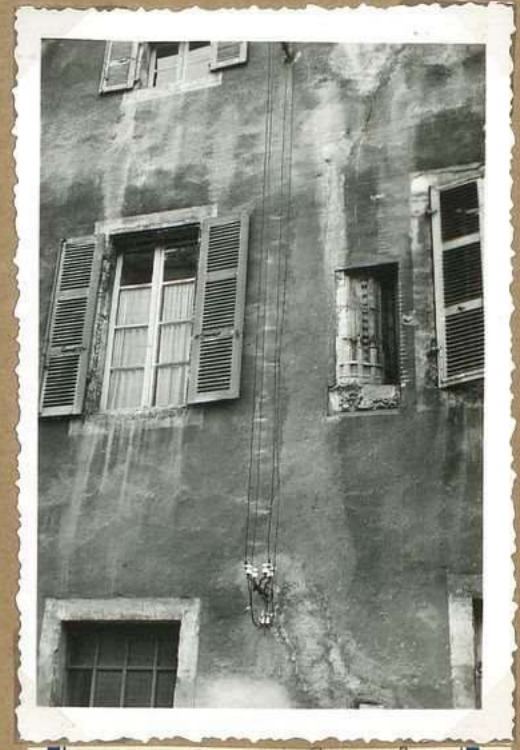
8621 - 2 Rue J. Carrière Vestige fenêtre du XV e s.
