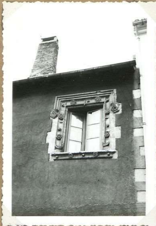
8467. 4 Rue Portail Alban. Fenêtre sur rue
