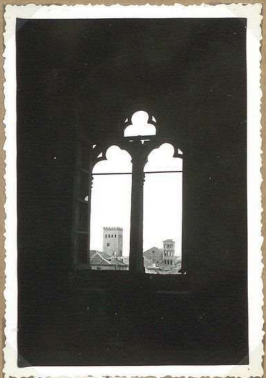
8477. Chateau du Roi. Fenetre xiii. Vue de l'ouest?
