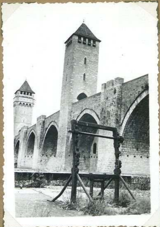
9803 Pont Valentin vieux treuil de l'écluse
