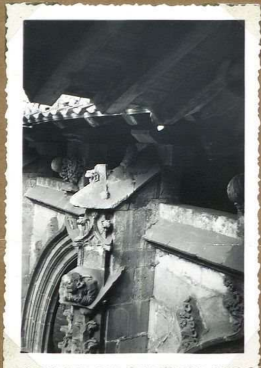
9842 Détail de contrefort
