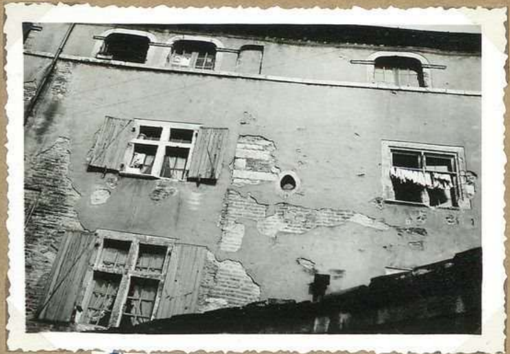
8527. Ancien couvent des Mirepoises. Facade sur des Mirepoises
