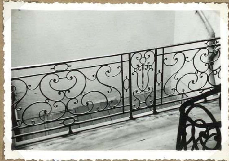
8488. 17. Rue du Cheval du Roi Balustrade pour 1 er étage
