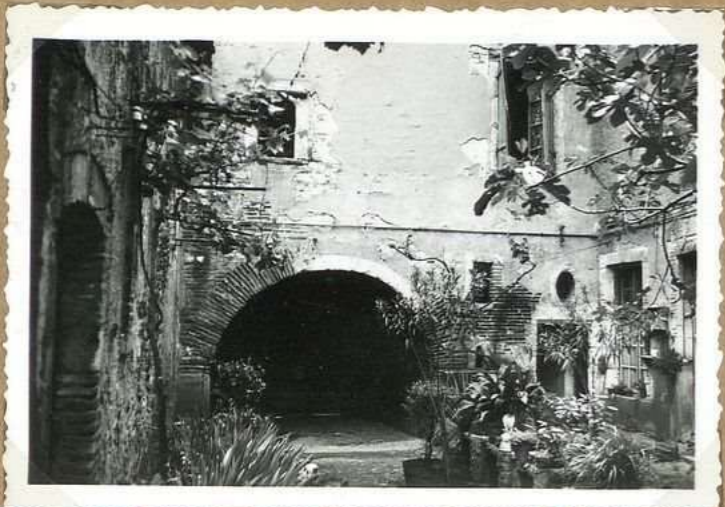
8510. 8 Rue Louis Deloncle La porche, côté cour
