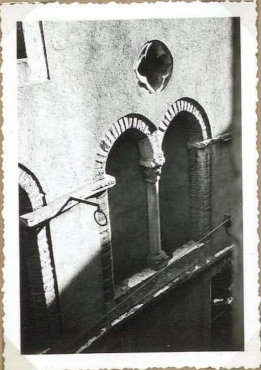
8384. 18. Rue St. Andre Baies geminées 1 er étage ancien
