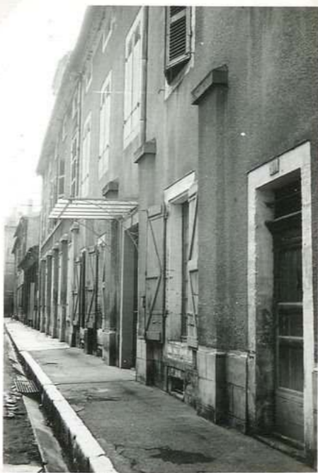
8836 - Corps de la Chapelle Série de Contreforts
