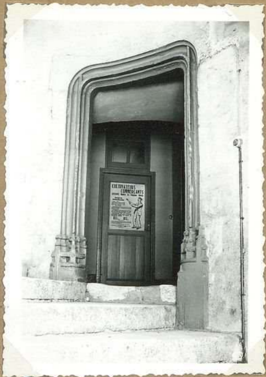
8441. Collège Séleigny Porte d'escalier. 2 e étage
