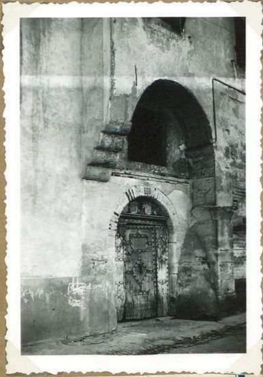
8423. 6. Rue Daurade Fort et embellissement
