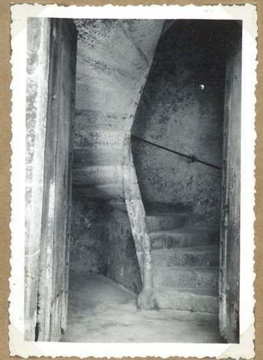
8414. 6. Rue St. Andre Paire inf re de l'escalier
