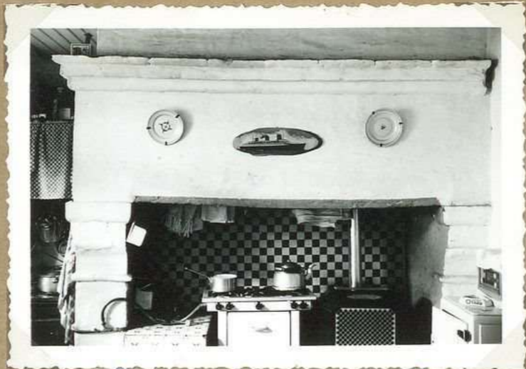
8426. 14. Place de la Libération Cheminée briques XVII e s. 3 e étage
