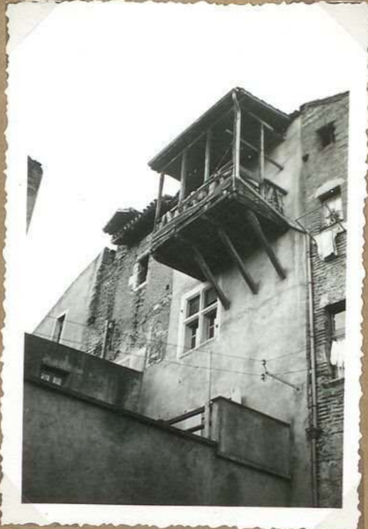
3 et 5. Rue des Soubiroux Balcon, fenêtre croisée pierre 8538
