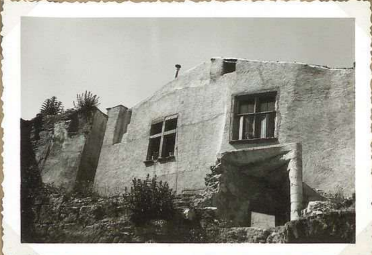
8386. 10. Rue J. Vidal Deux fenêtres à croisée de pierre E
