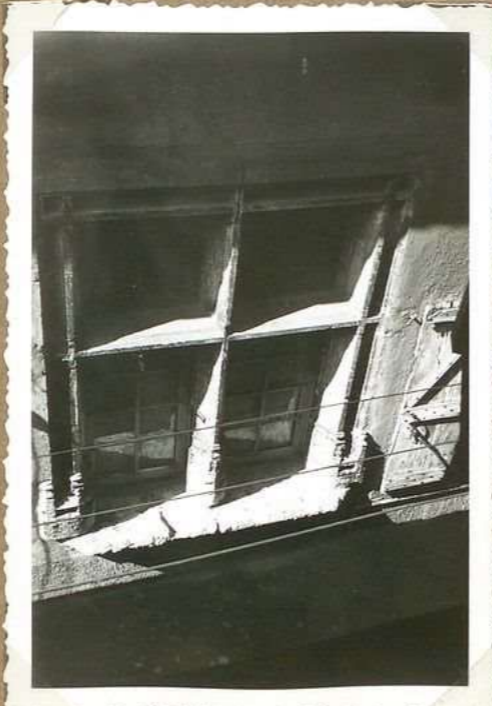
8337. 5. Rue 7. B. Delpach. Fenêtre à bois de pierre, sur rue
