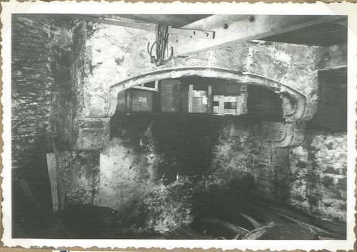
8312 - 22 Rue Clémenceau An ve m oy dine Cheminée en pierre
