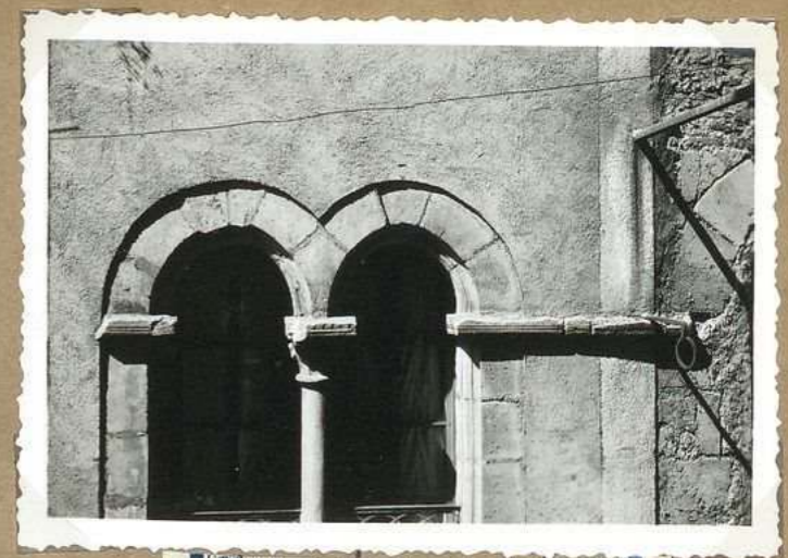
8309-6 Impasse Catonne Baie gem. 1 er et. detail
