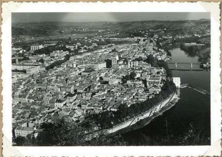
562 Vue générale (du N o St Cyr)
