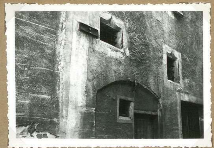
8252. 8. Rue Lashie 2 baies avec linteaux accolés
