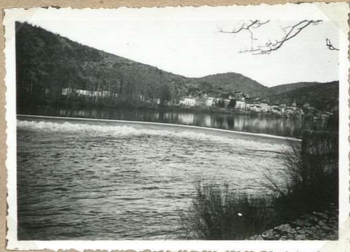
5953 Le Lot en aval de Larroque, barrage
