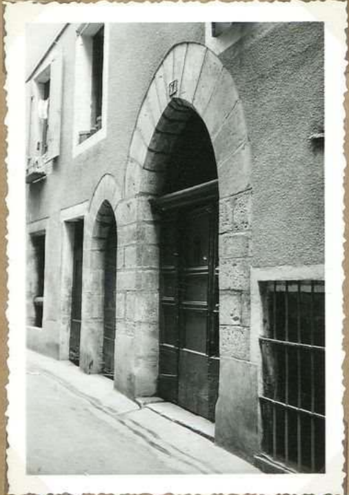
8294. 7 Rue du Tapis Vert Porte et arcade sur rue
