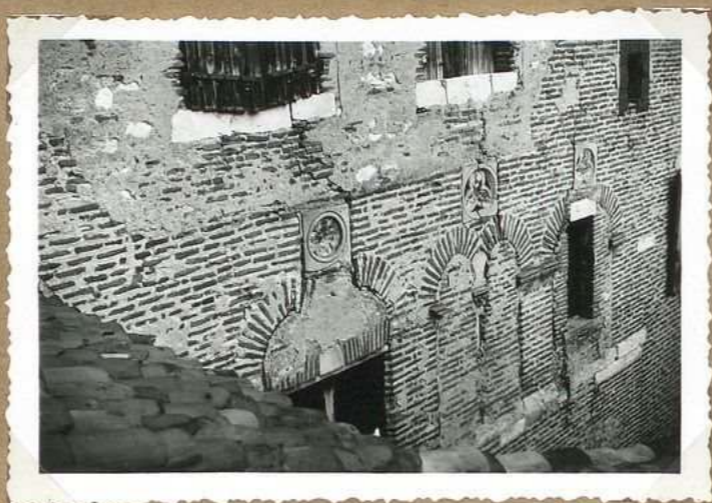
8258. 10. Rue Lastic Façade en briques: base gothique
