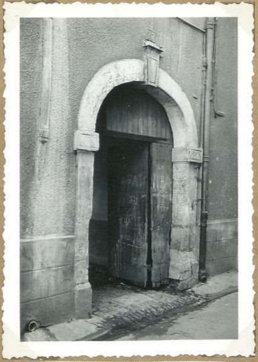
8260-16, Rue Lashie. Portail d'entrée sur rue
