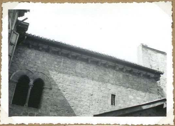
8287 - 7 bis Rue St James Grenier au Chapitre: corniche
