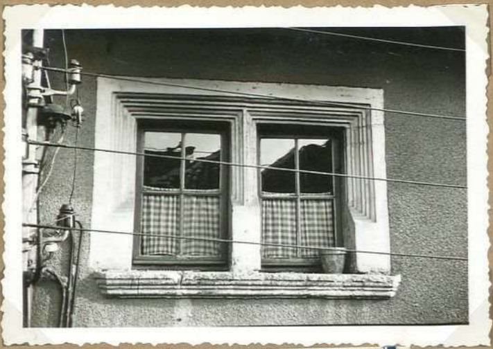
8250. 8. Rue Lashie. Fenêtre XVII e s. 2 e ét.
