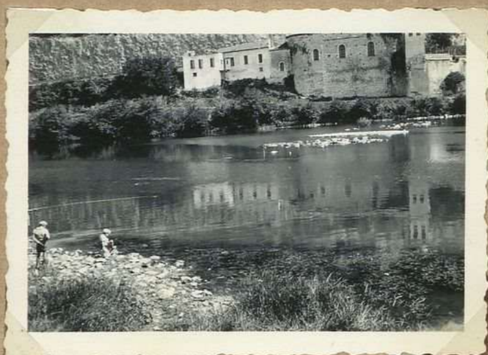
510. Le pont Vieux Piles aux bannes eaux
