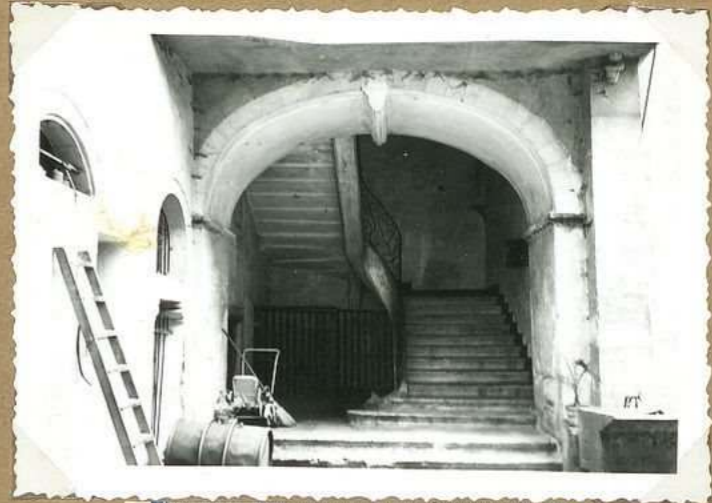
8360. 3. Rue de la Prefecture Porche d'entree (cave)
