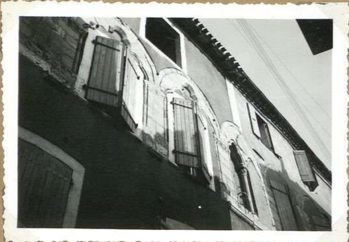
8235. 71. Rue Nationale facade fenêtrée XIII e
