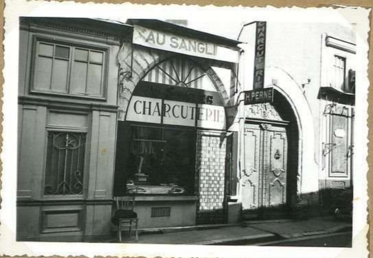
8358. 3. Rue de la Prefecture gds arcade et porte d'entree
