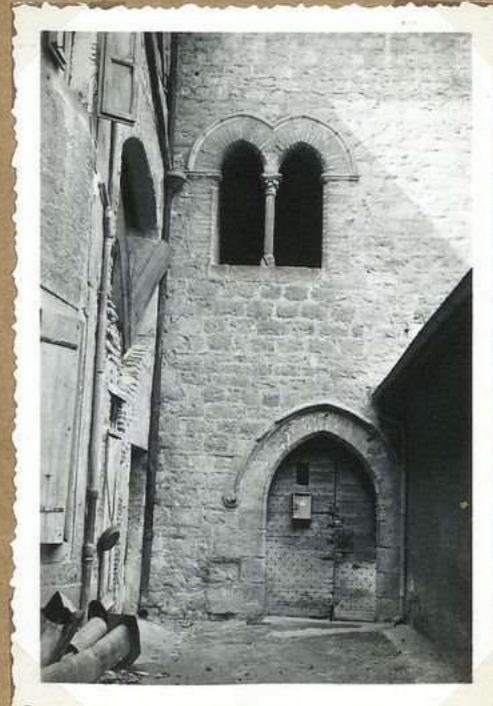
8288 - 7 bis. Rue St James Grenier au Chapitre; Fenêtres et porte
