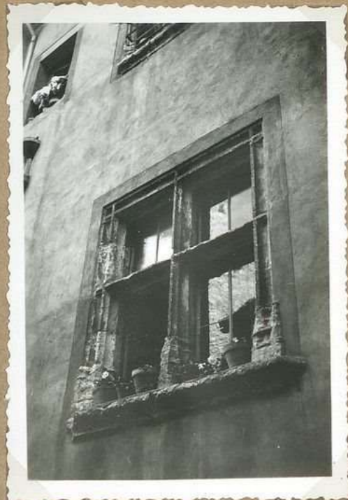
8334. 5. Rue F. B. Delpech Fenêtre croisée de pierre 1 er ét. sur cour
