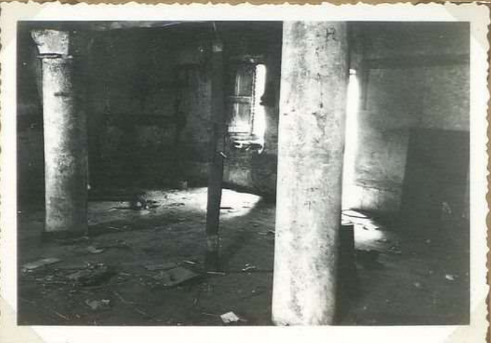
8330. 6. Rue 7. B. Delpach. Entresol; colonnes cylindriques
