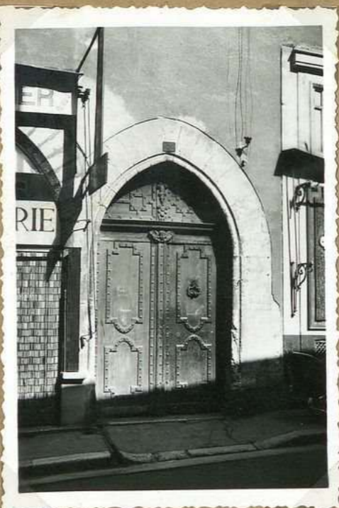
8359 - 3. Rue de la Prefecture porte d'entree
