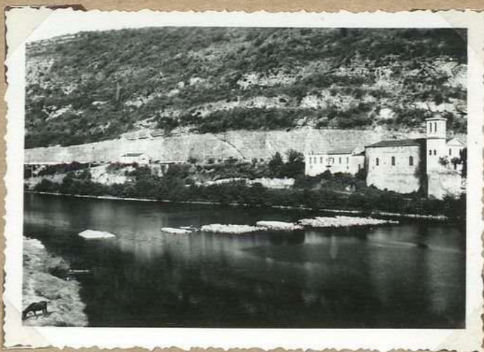
510. Le pont Vieux. Piles aux bannes eaux
