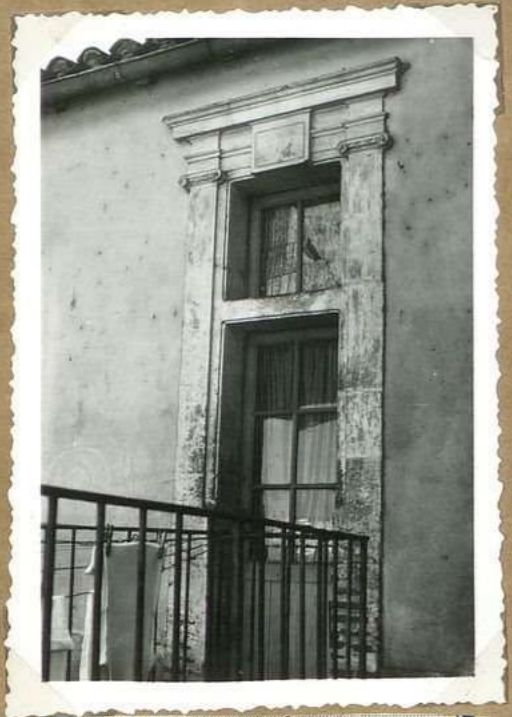
8262. 16, Rue Lashie. Porte linteée avec traverse pierre
