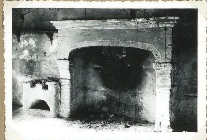
8232. 66. Rue Nationale Cheminée en briques XVII e 2 e et.
