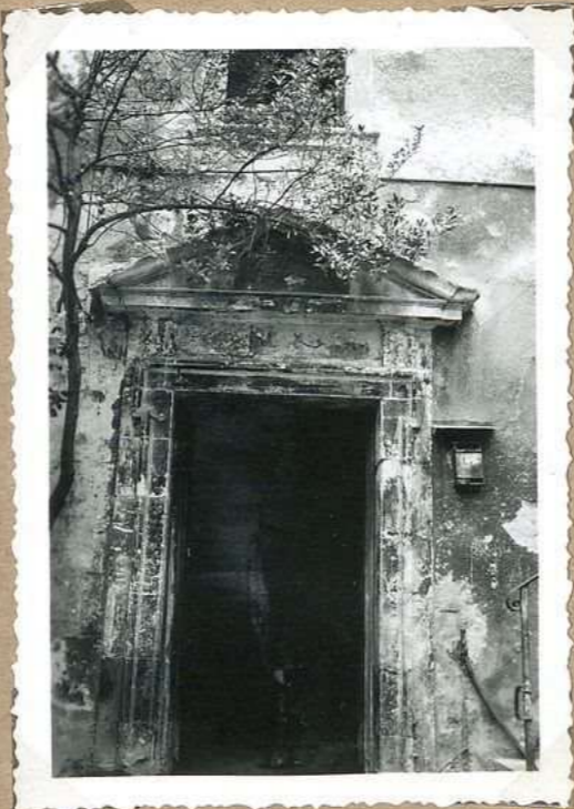
5952 Porte d'escalier n° 6 de la Rue St André
