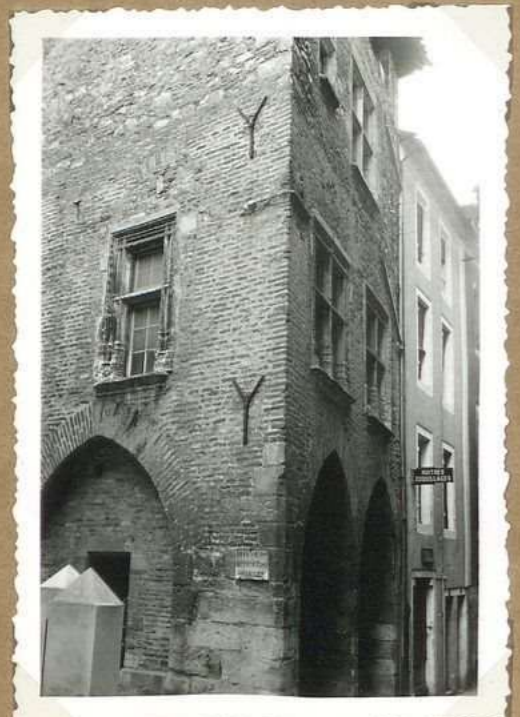
8349. 2. Rue de la Halle Facade sur rue Fondue
