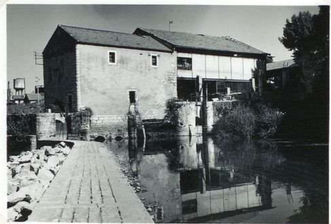
560. Moulin du Perie'
