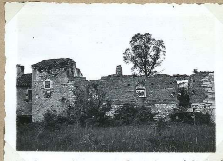
5911 Vestiges "collège" de Bégoux
