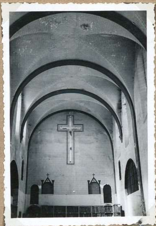
4537 Chapelle des Capucins Arch. de pls. côté chœur
