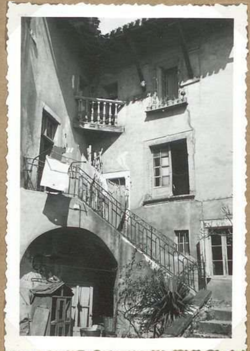
8247. Surpass la capelle. Détail escalier ferroviaire
