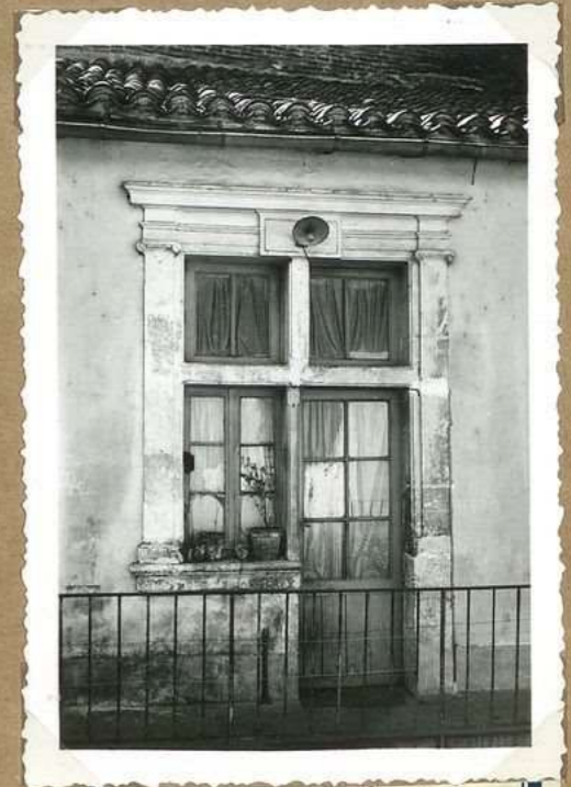
8263. 16, Rue Lashie. Porte linteée avec traverse et meneau
