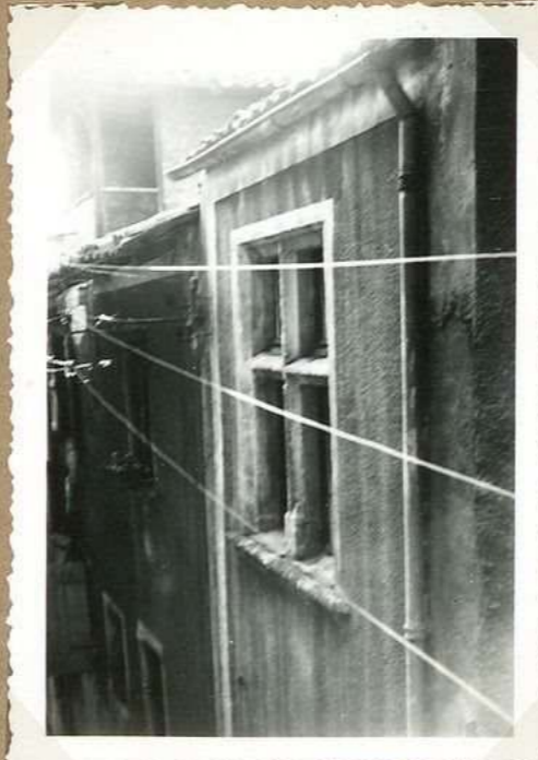
8238. 15. Rue du Cheval Blanc fenêtrée à croisée de pierre.
