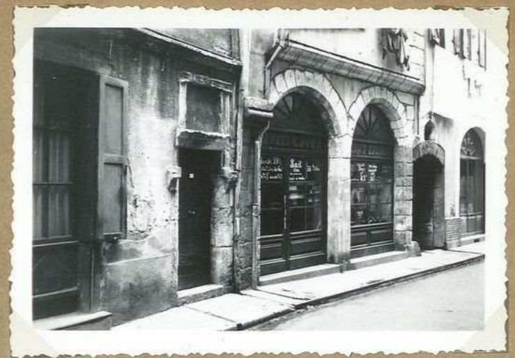
8229. 53, Rue Nationale Encorbellement pierre Mocade de la façade
