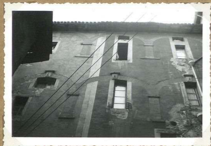
8303. 14. Rue Clémenceau Double arcades de 3 arcades S.
