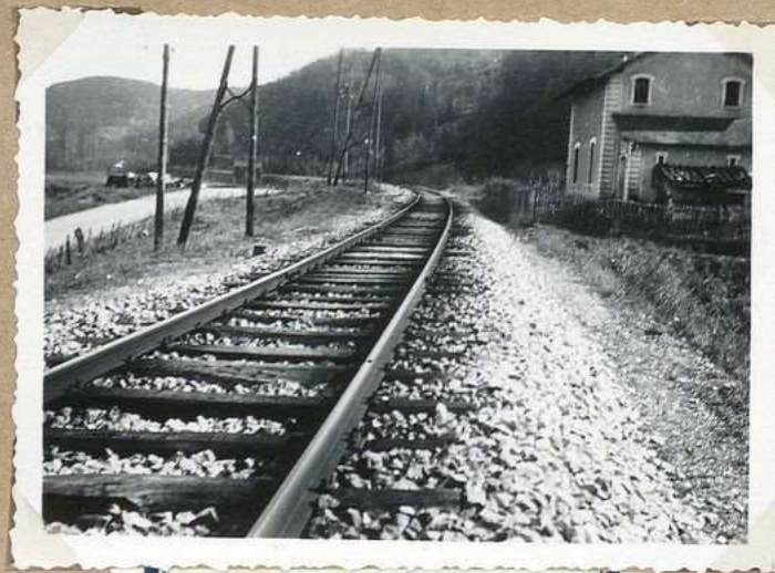
5947 Voie ferrée Cahors Capdenac à Caraniès
