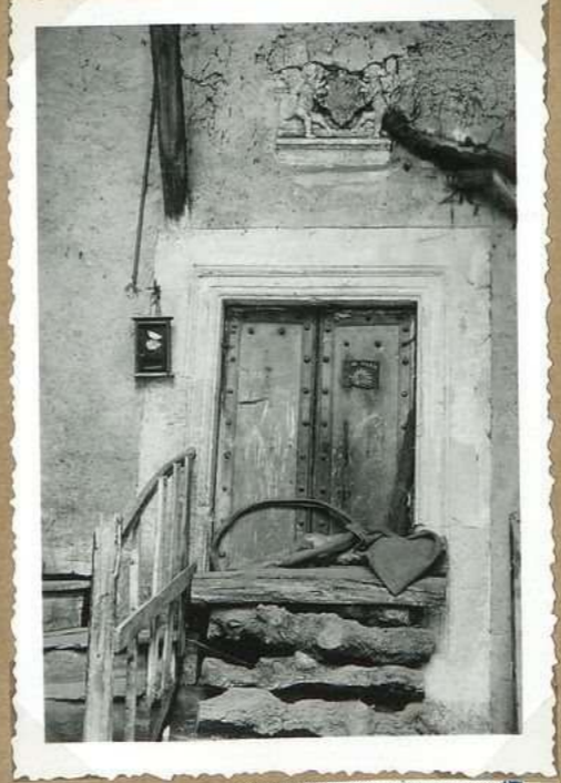
8251. 8. Rue Lashie. Cours. porte surmontée d'un armoiré
