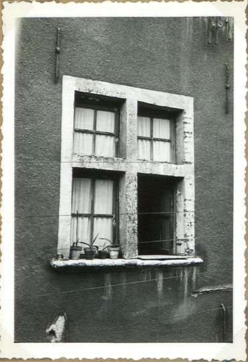
8283 - 4. Rue St James - Fenêtre à croisée de pierre
