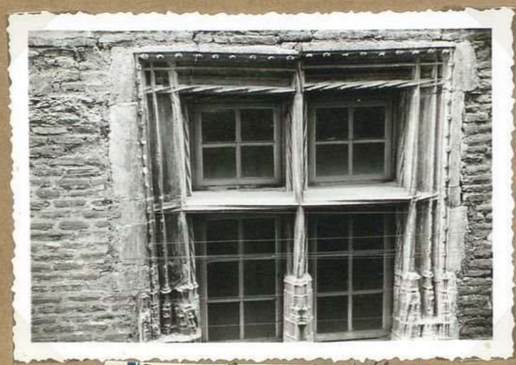
8350. 2. Rue de la Halle Fenetre sur rue Fondue la + au sud
