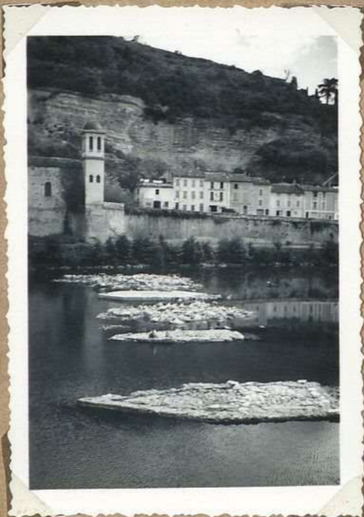
607 Piles du Pont Vieux aux Basses eaux
