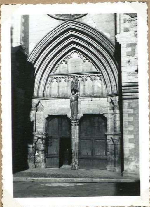
573 Eglise St Urbain le portail
