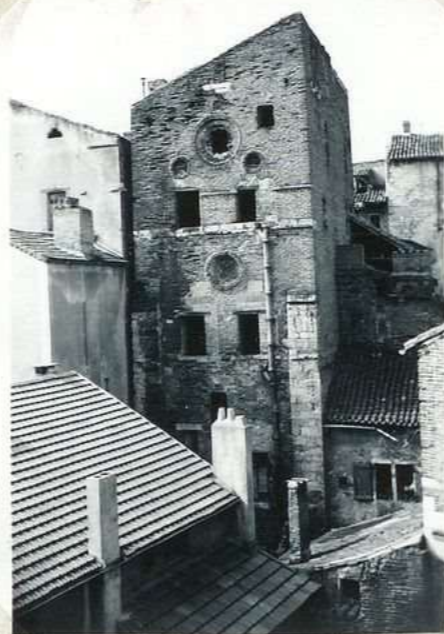
590. Tour de la Rue du Four St e Catherine
