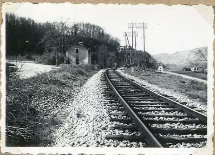
5946 Voie ferrée Cahors, Capdenac à Caraniès
