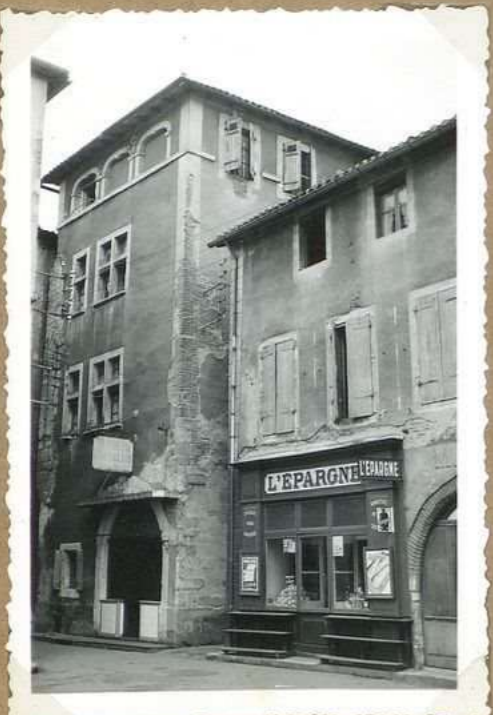
8229. 28. Rue Nat le Facade vers St. Roumeau
