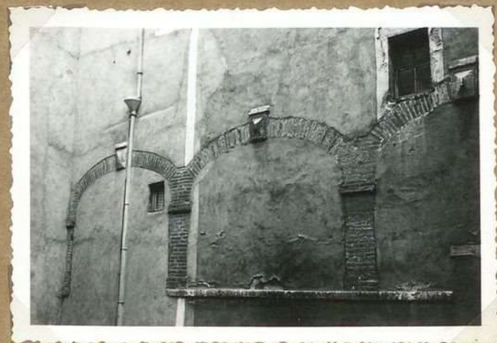
8305. 14 Rue Clémenceau 3 arcades murées N.
