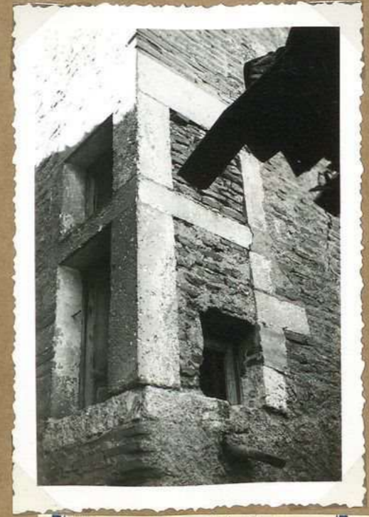
8271. 5. Rue St Urbise Fenêtre d'angle, sur rue
