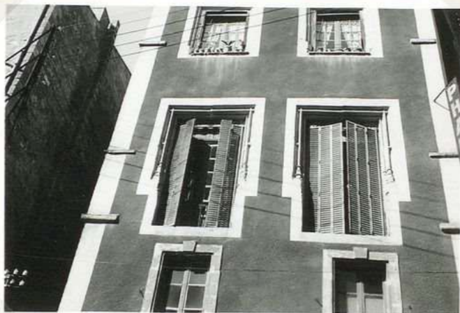
8321. 2 Pl. J. Chapou (20 Rue Foch) 2 fenetres 14. et. de face
