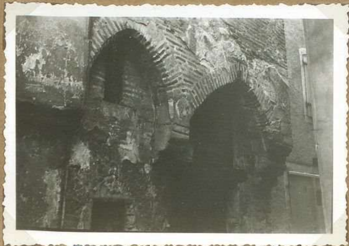
8338. 6. Rue 7. B. Delpach. Detail, encorbellement sur rue
