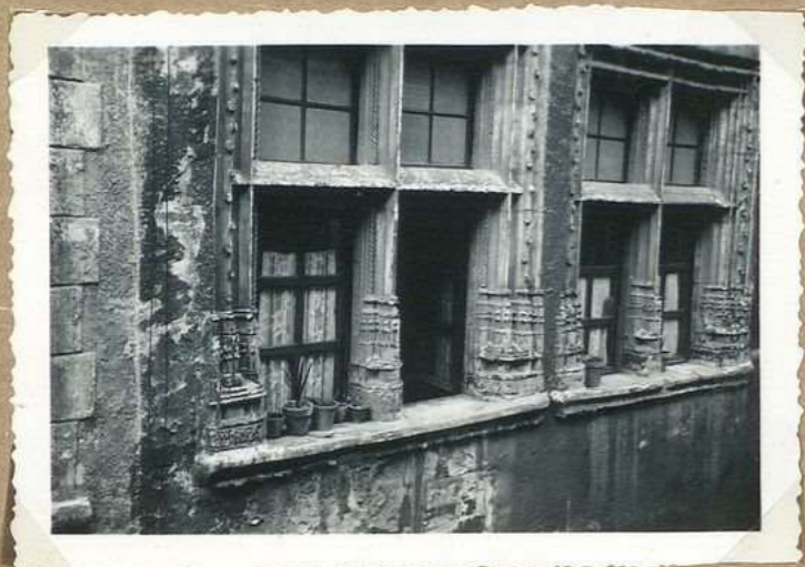
572 Fenêtres 2 e étage 16 Rue Nationale
