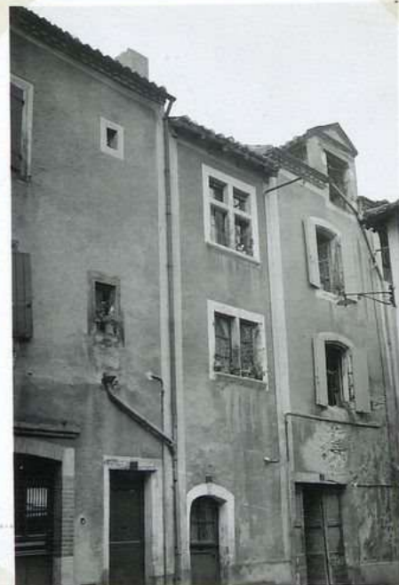
7925. Facade XV e s. 5. Rue S t Laurent
