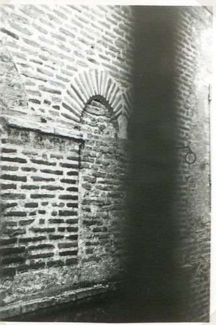
8325. 8. Rue J. B. Delpach Vestige baie ogivale sur rue
