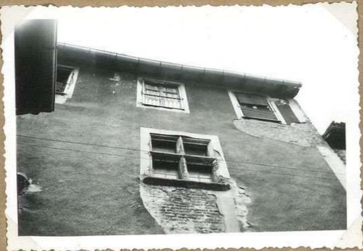
8223. 28 Rue Nat le Fenêtré croisés pierre sur rue Foucault.
