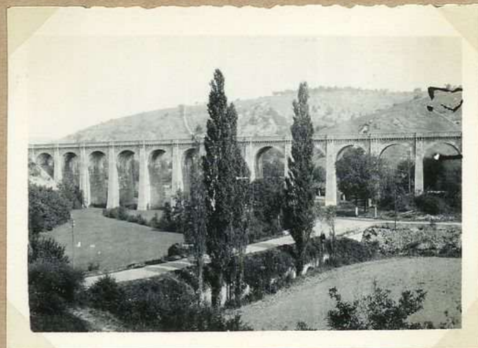
5925. Viaduc des Sept ponts.
