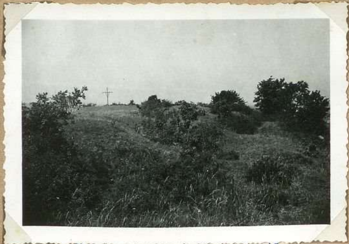
305 Fortifications de Pech de Rincourt
