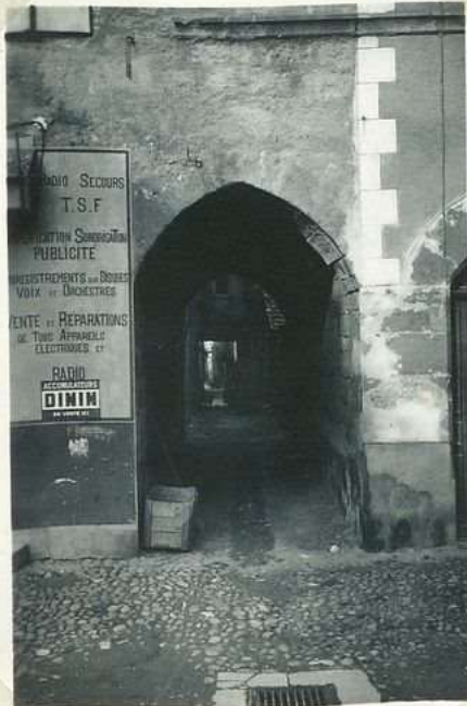
421. Vue de rue avec passages couverts
