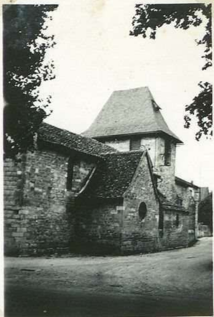
412 Eglise de Bretenoux
