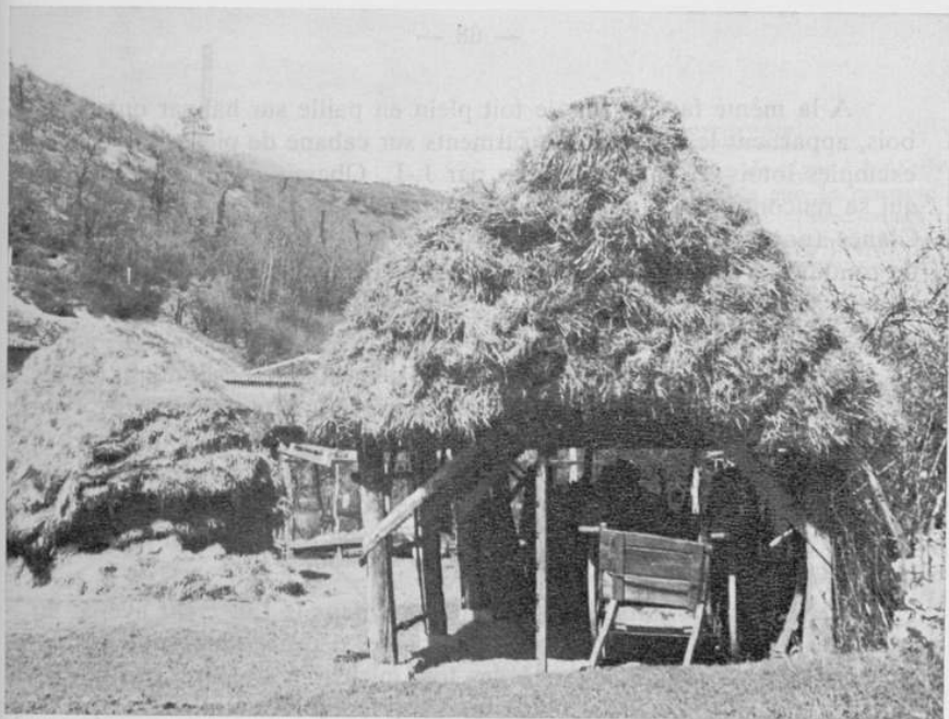
Combe de Filhol, Cne de Lacapelle-Cabanac : Hangar sur poteau couvert d'un toit plein en paille (cl. A. Cayla).
